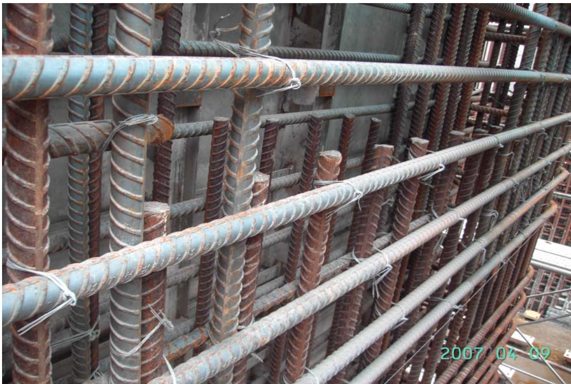
圖十：一號機核燃料運輸箱儲送通道周圍鋼筋遭截切
