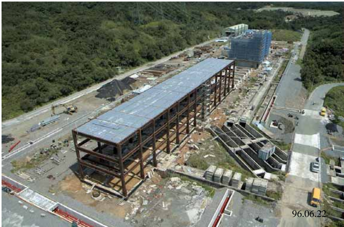
圖八：開關場施工現況圖景
