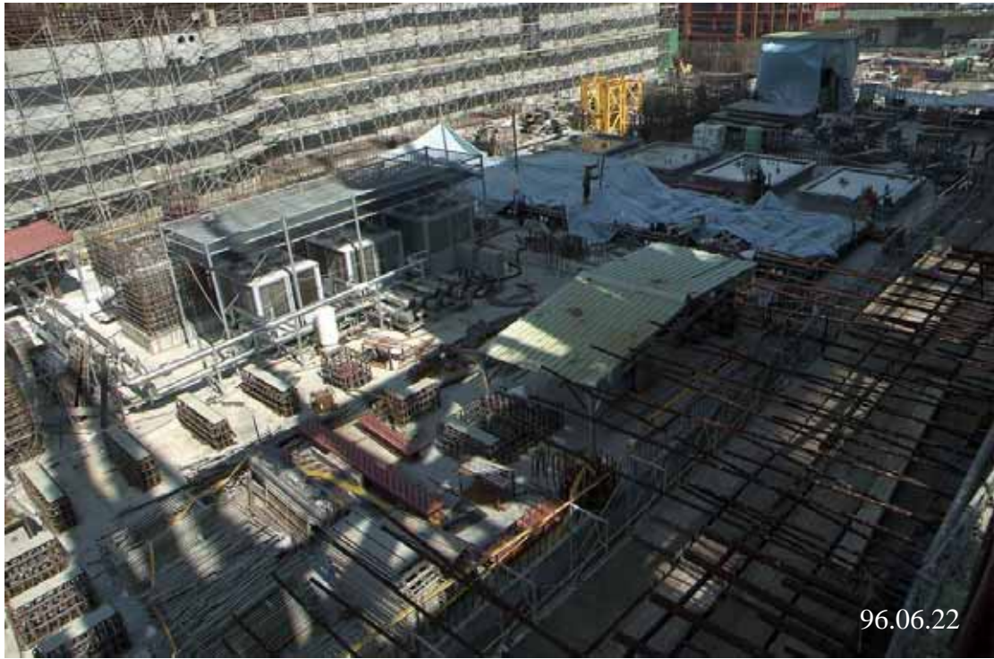
圖三：一號機控制廠房施工現況圖景
