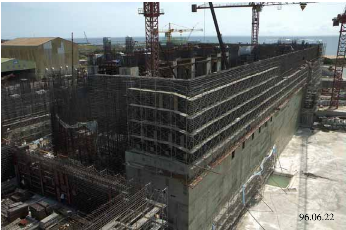
圖六：二號機汽機廠房施工現況圖景
