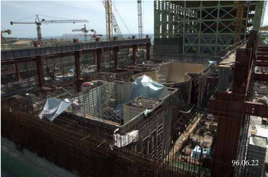
圖一：一號機反應器廠房施工現況圖景
