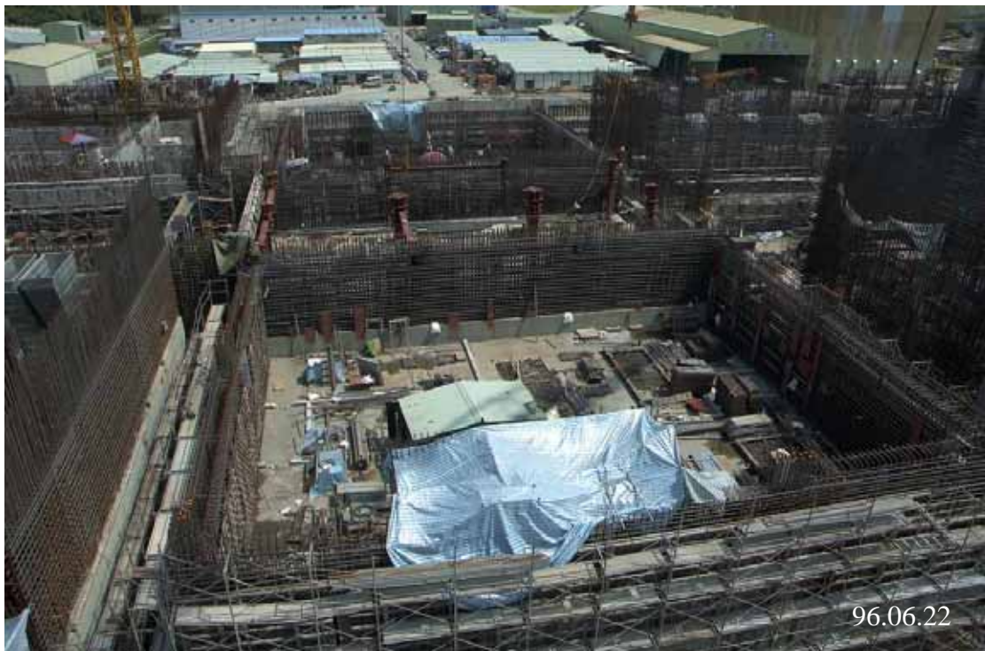
圖四：二號機控制廠房施工現況圖景
