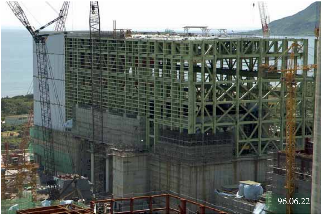
圖五：一號機汽機廠房施工現況圖景
