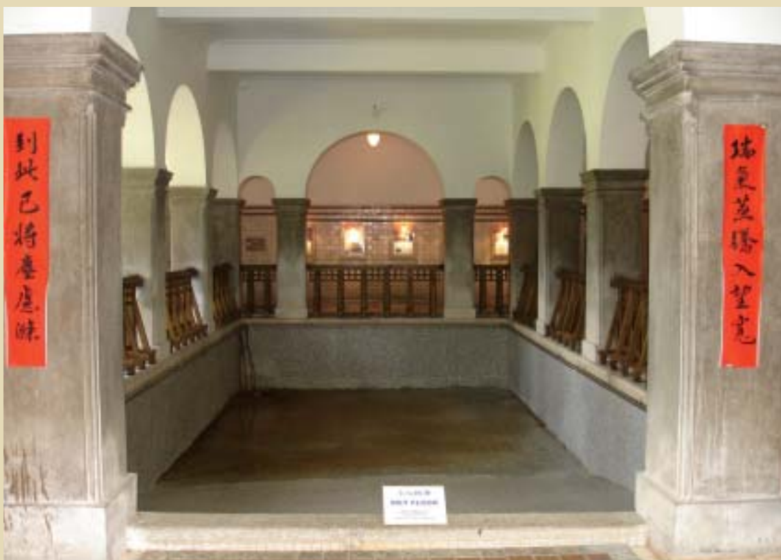
● 北投溫泉博物館一樓的公共大浴場，長9公尺，寬6公尺，深度由40-130公分，浴池周圍為圓拱石柱，當年為東亞第一大公共浴池（2005年攝）。
