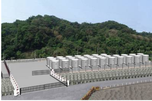
核一廠用過核子燃料乾式貯存設施示意圖 (核研所提供)
