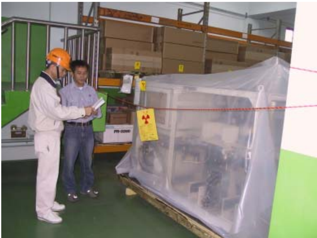
照片八：視察儀控設備維護作業情形
