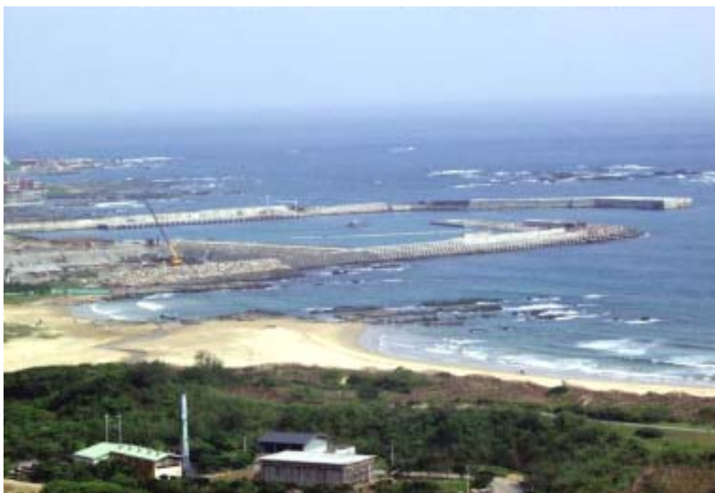
照片六：南北防波堤及重件碼頭施工現況
