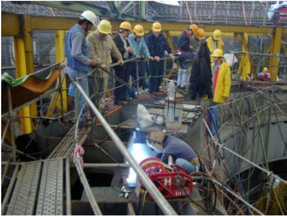
照片十一視察一號機基座安裝銲接作業情形
