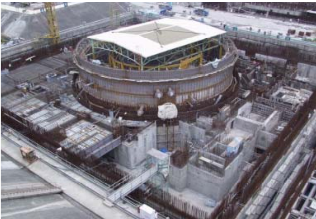
照片二：一號機反應器廠房施工現況
