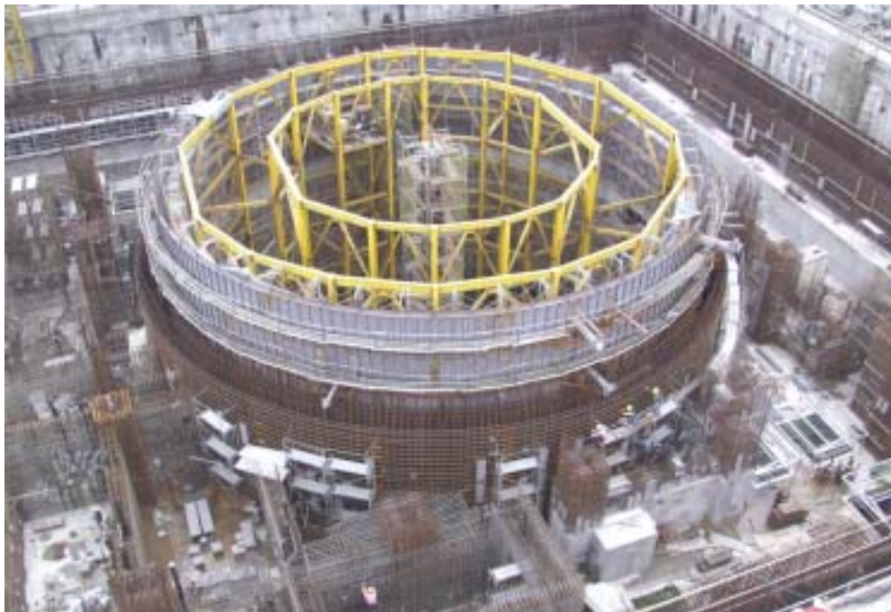
照片四：二號機反應器廠房施工現況
