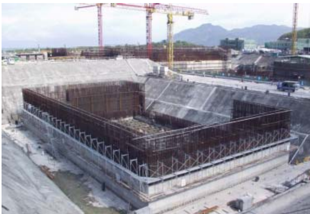
照片五：輔助用過燃料廠房施工現況
