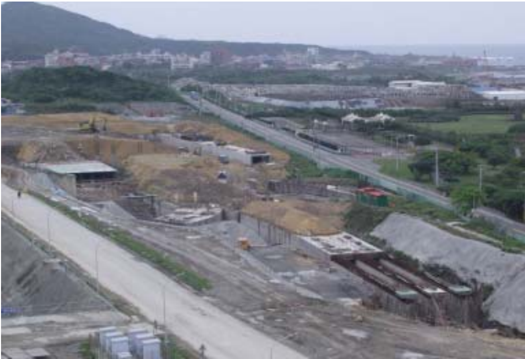
照片七：進水暗渠施工情形
