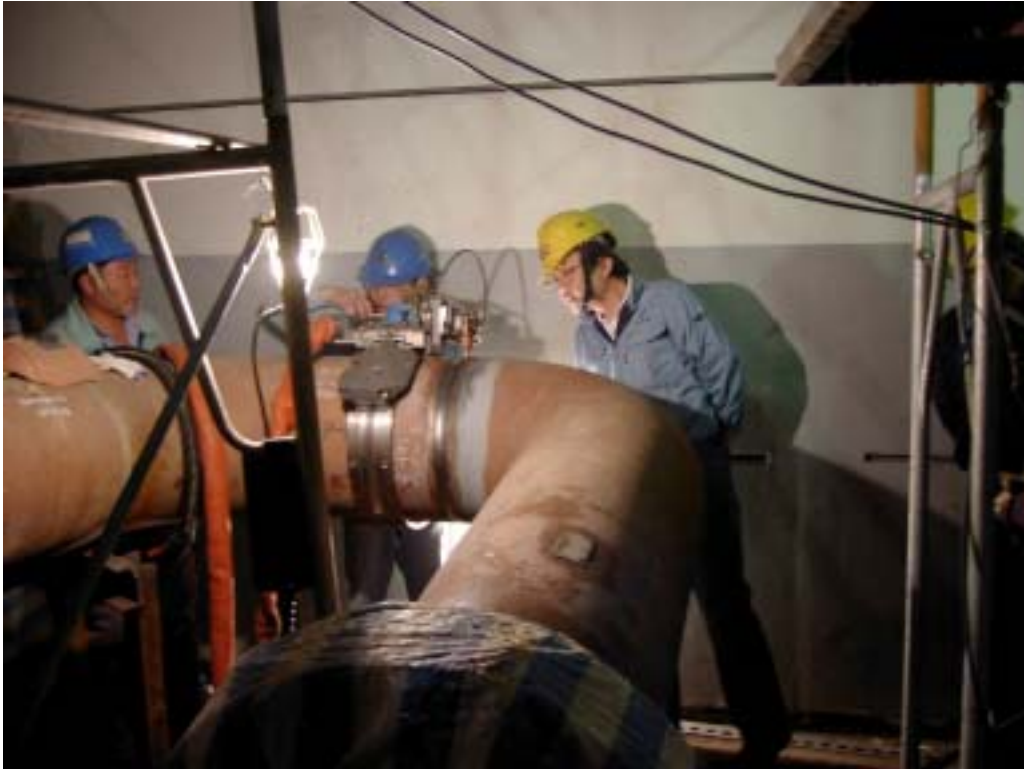
照片九：JAPEIC 人員視察現場管路自動銲接作業情形
