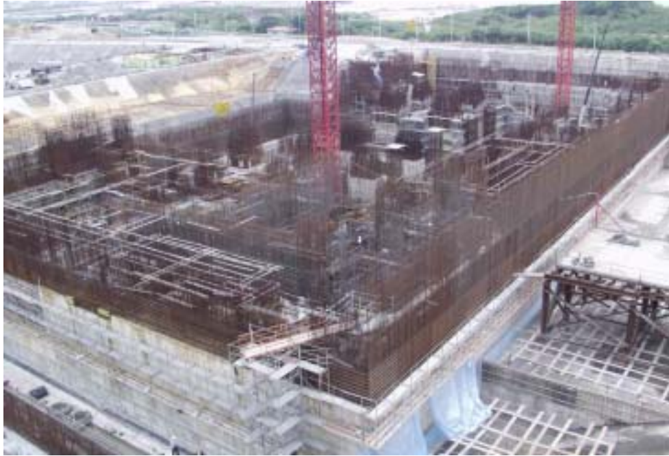
照片三：一號機汽機廠房施工現況
