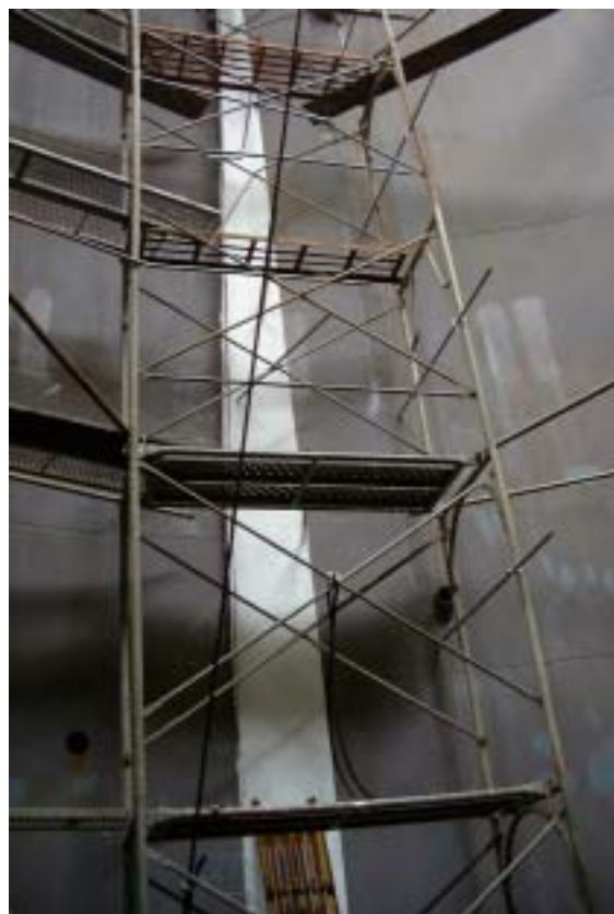
照片八：鐸後持溫，再覆蓋絕熱帶緩慢冷卻至環境溫度
