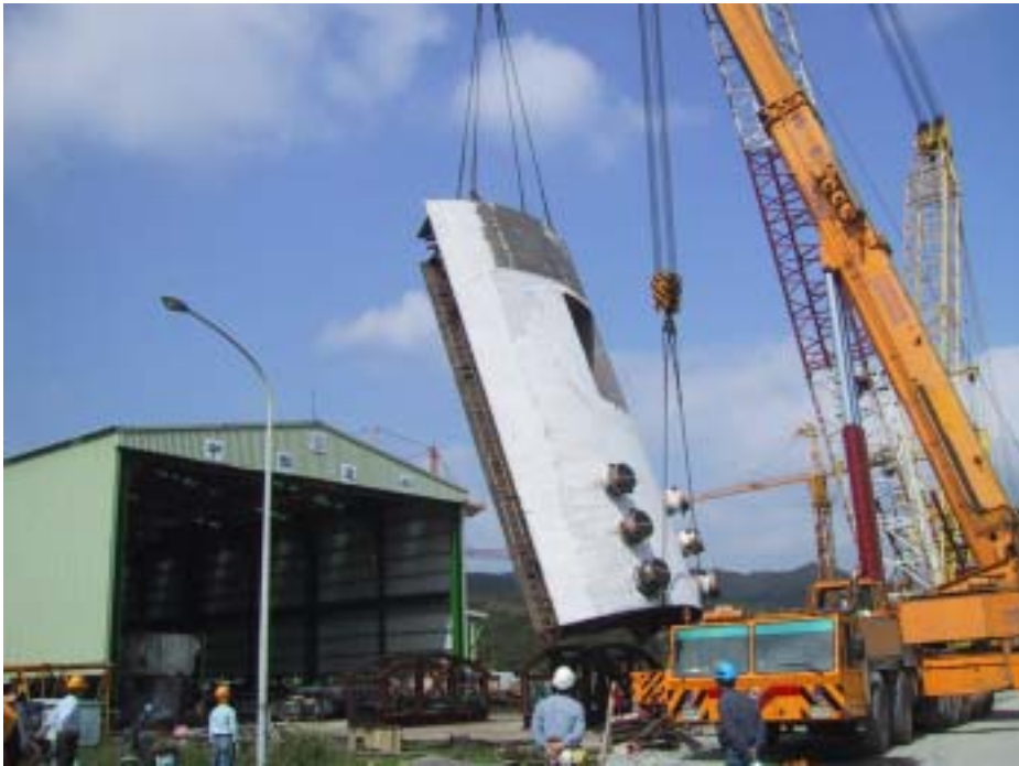
照片一：基座第一層扇形鋼構體(RS 11 吊裝作業)
