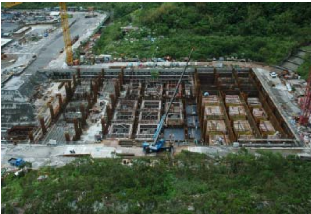
照片六：核廢料廠房施工現況
