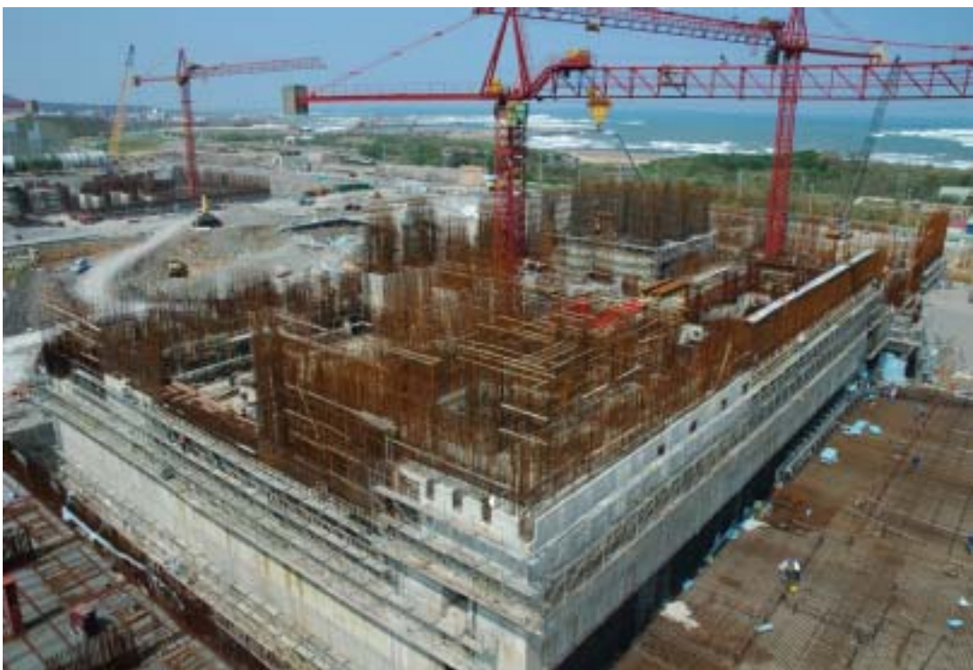
照片四：一號機汽機廠房施工現況
