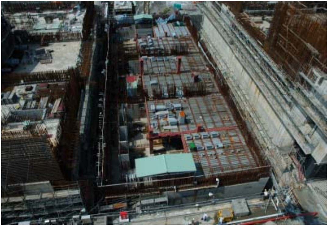
照片三：一號機控制廠房施工現況
