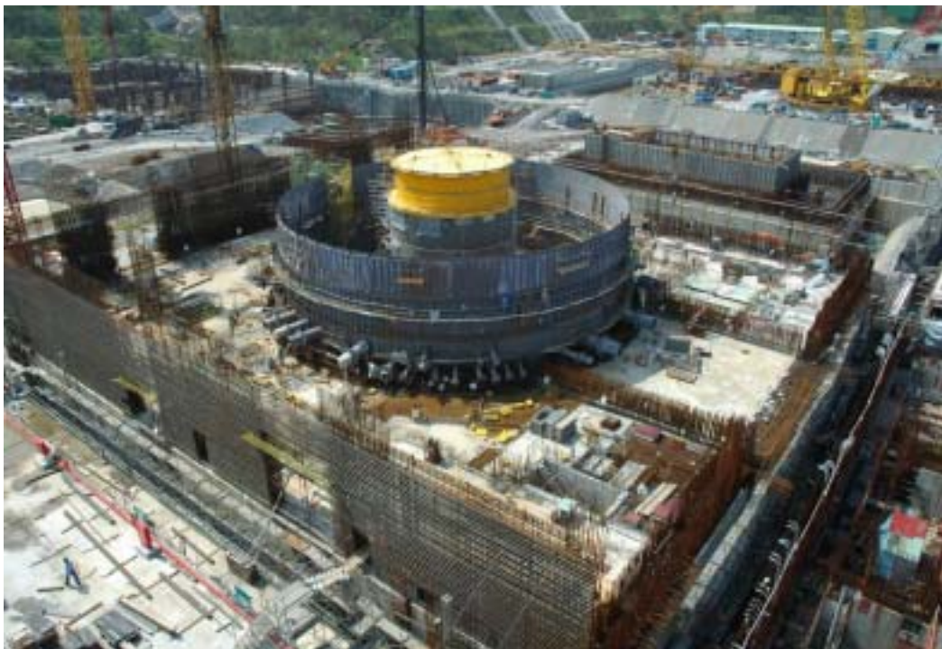
照片二：一號機反應器廠房施工現況
