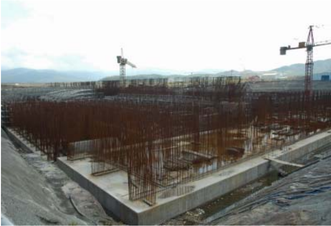
照片七：抽水機房施工現況
