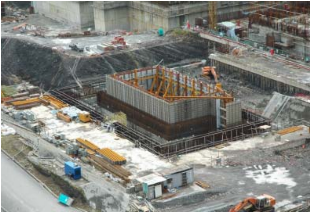
照片五：輔助用過燃料廠房施工現況
