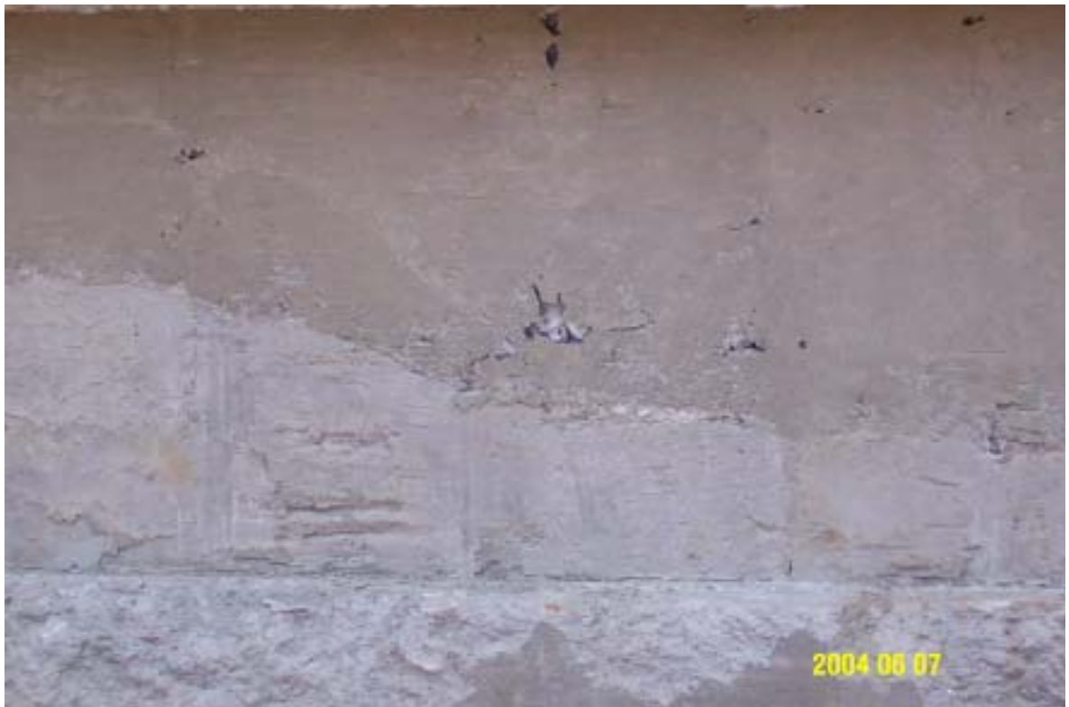
圖十：CWPH 基座疑似冷縫情形（顏色不同）
