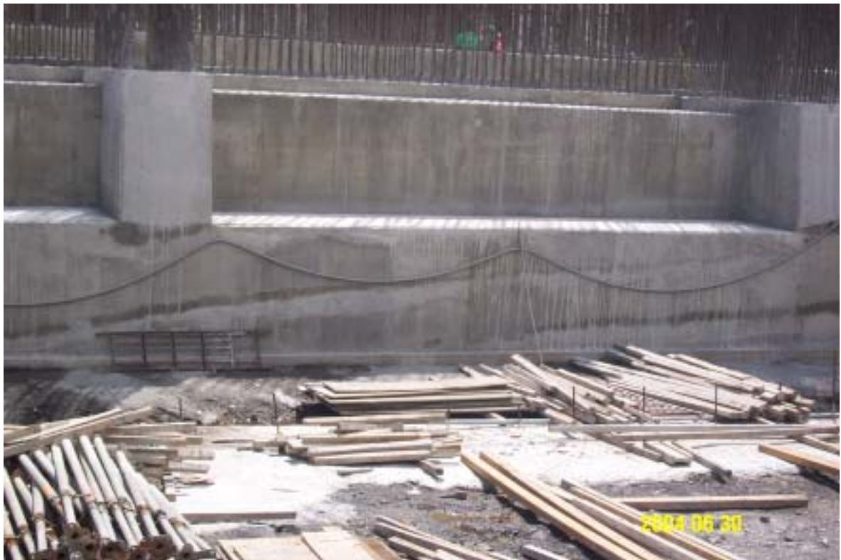
圖十二：CWPH 基座疑似冷縫情形（明顯節理）
