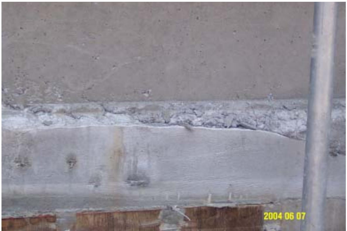
圖九：CWPH 基座疑似冷縫情形（明顯縫隙）
