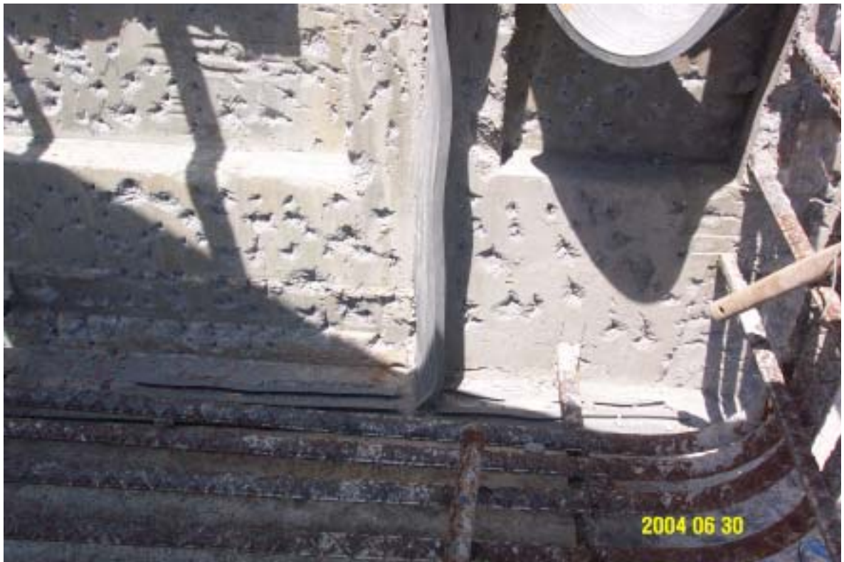
圖七：CWPH 基座內、外型止水帶連接情形
