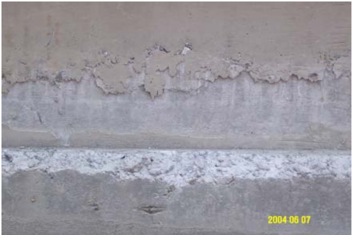
圖十一：CWPH 基座疑似冷縫情形（同昇層上下厚度卻不同）
