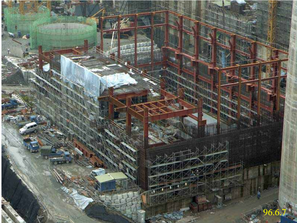
照片八：輔助用過燃料廠房施工現況
