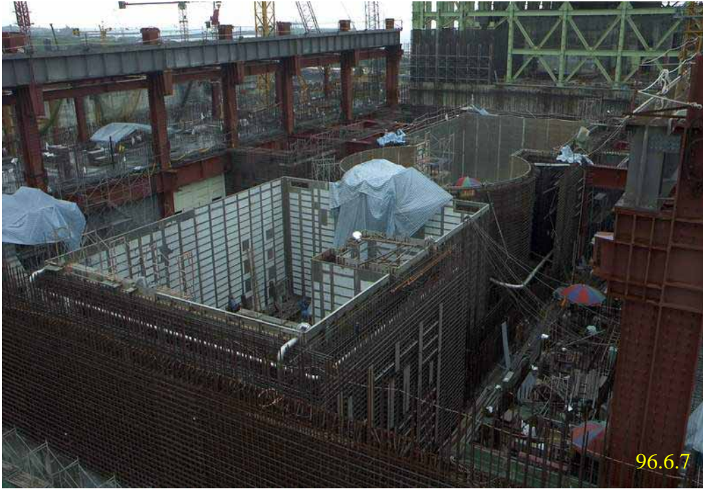
照片五：一號機反應器廠房施工現況
