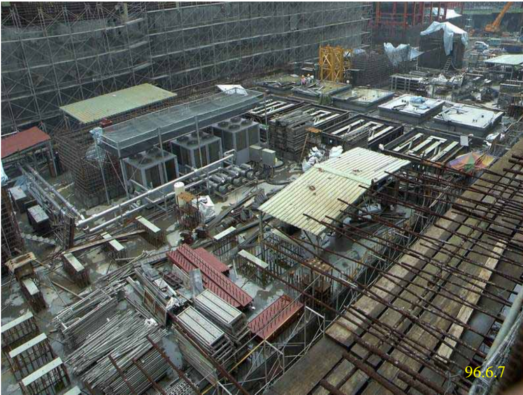
照片六：一號機控制廠房施工現況
