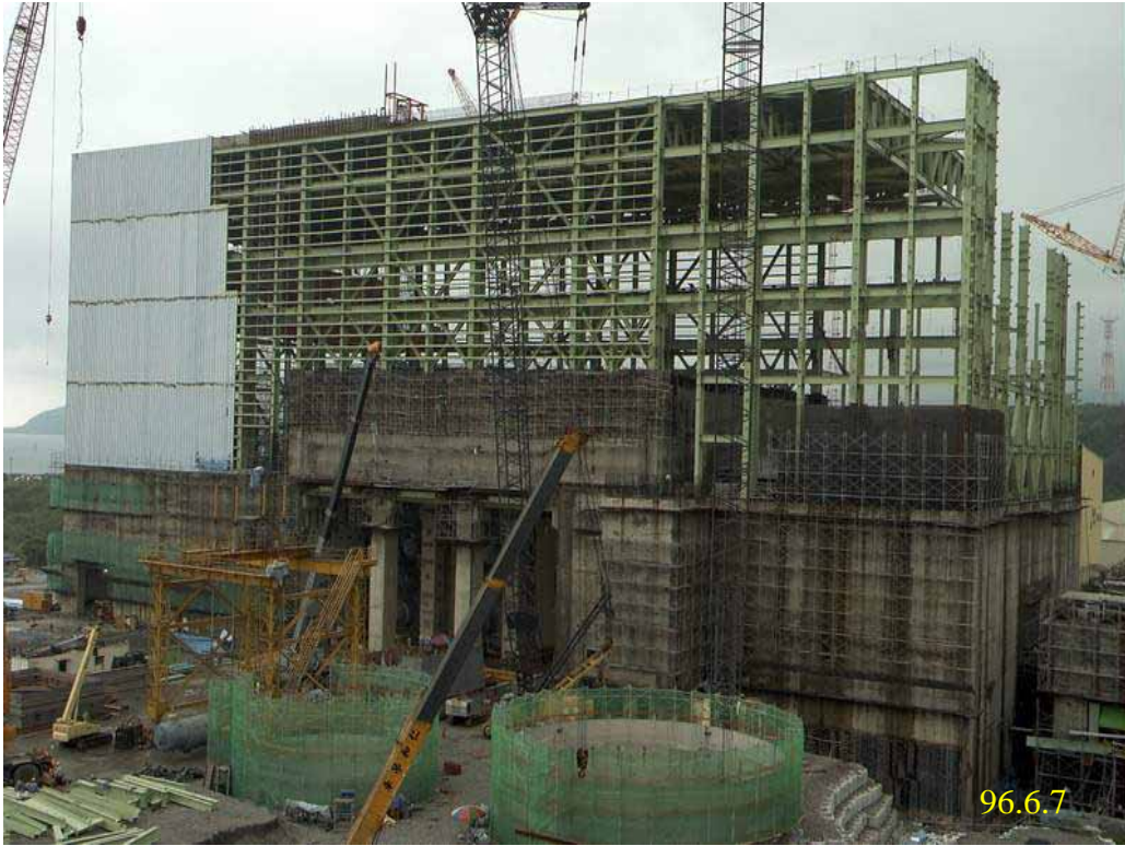
照片七：一號機汽機廠房施工現況
