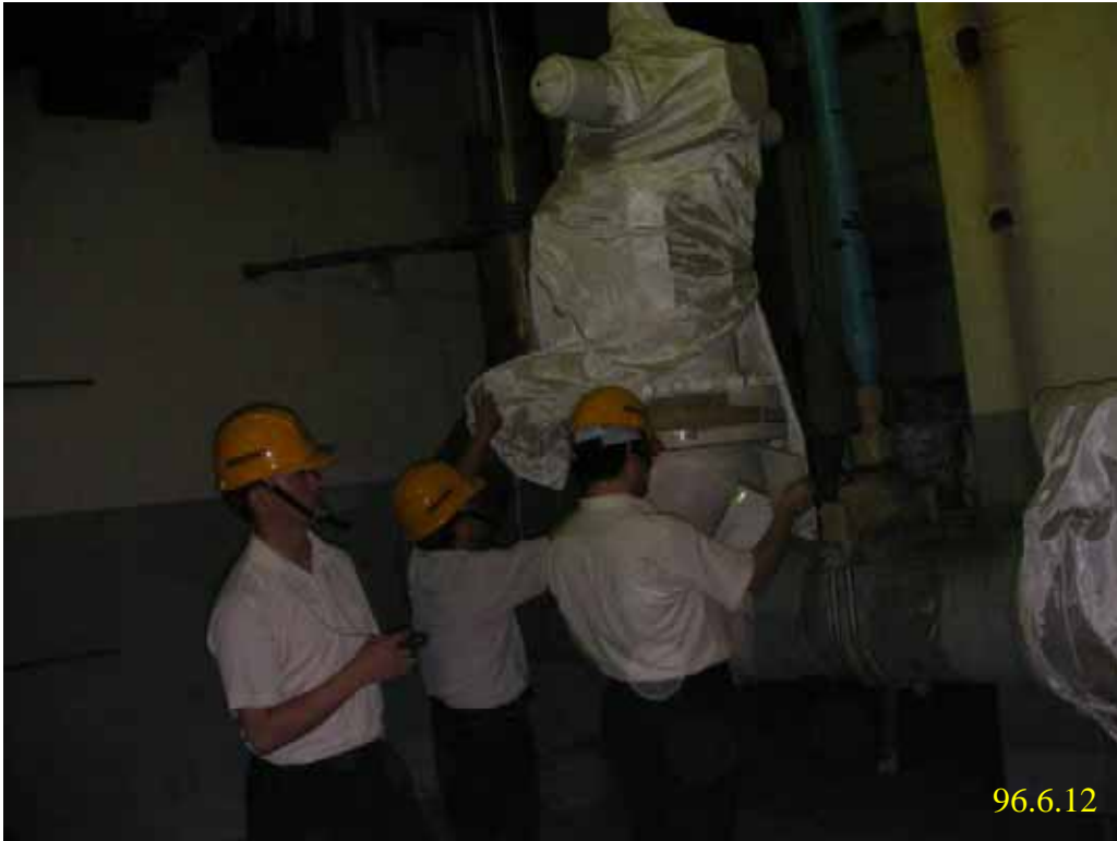
照片九：於一號機反應器廠房 EL-8200 視察設備維護情形
