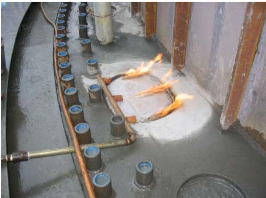
圖四：澆置後養護中準備進行人孔封鋸之預熱除水作業
