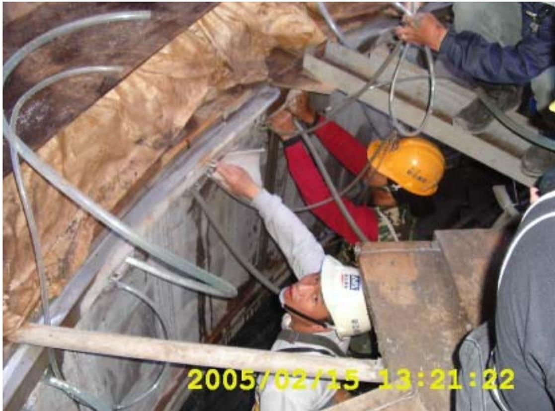
圖十一：半圓形開口處封板插塑膠管
