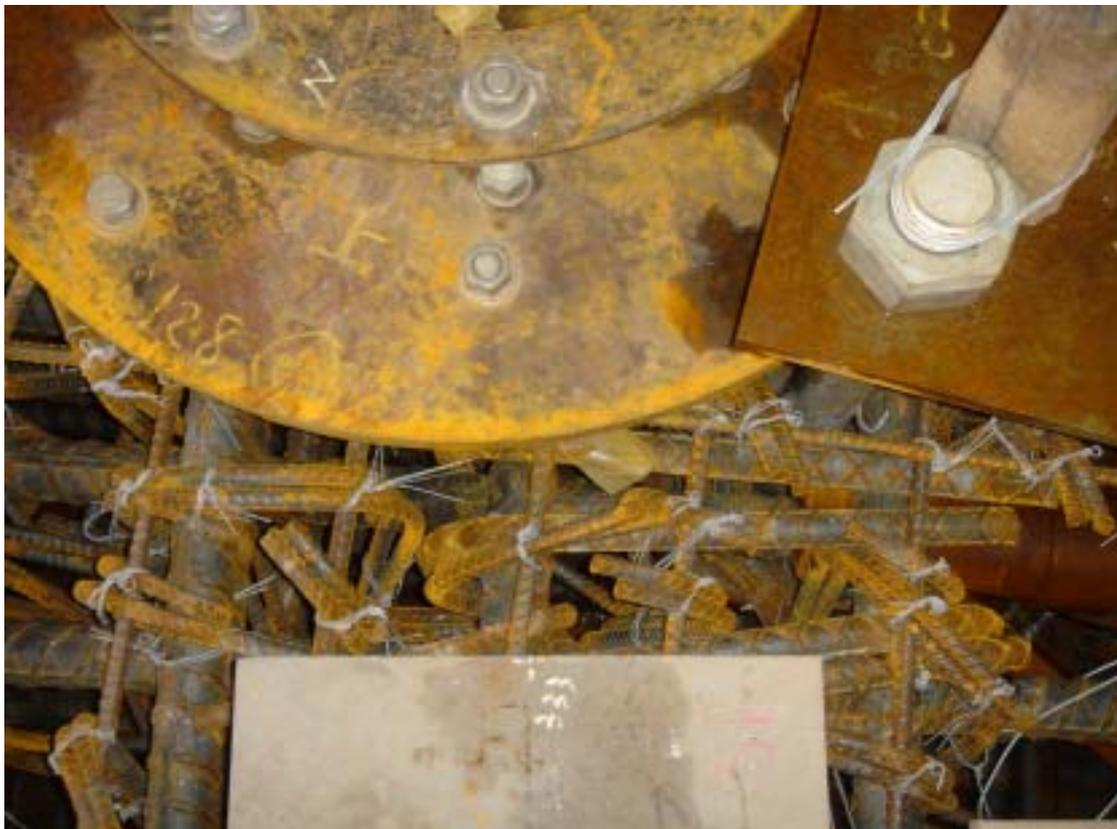
圖六：一號機隔膜地板箍筋排紮不正確情形
