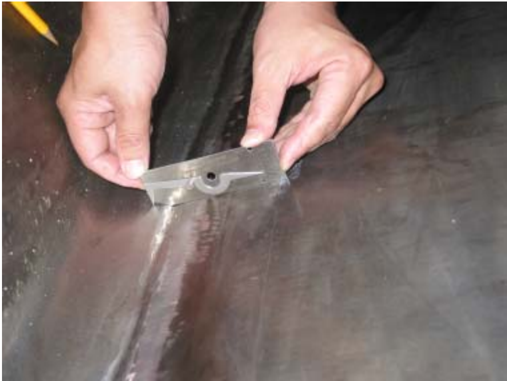
照片十六：基礎銲道&外鈹 309L 防蝕覆層量測情形
