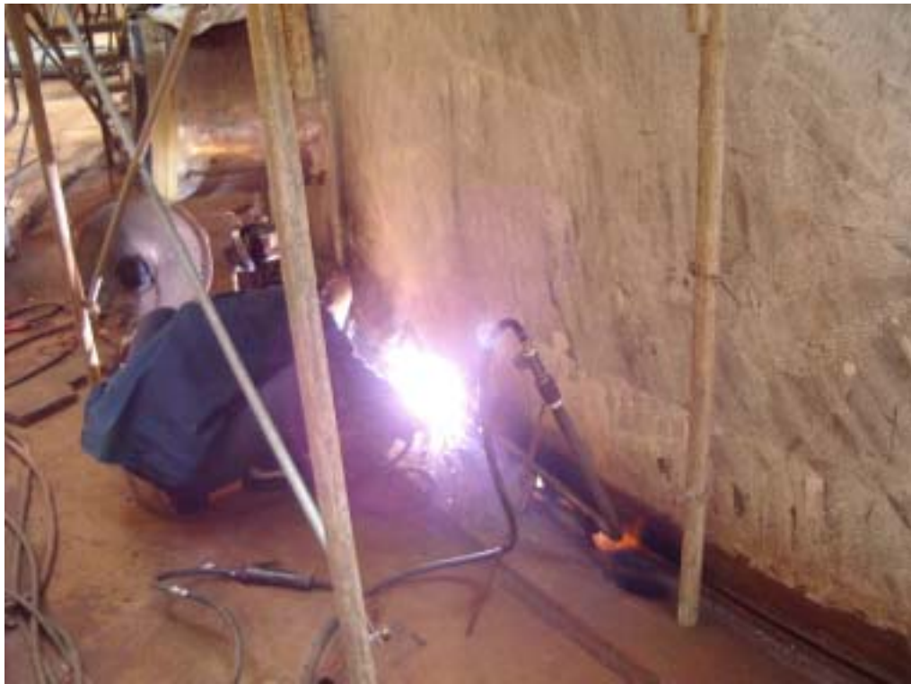
照片十一：基礎鉚道鉚接並同時持續預熱情形
