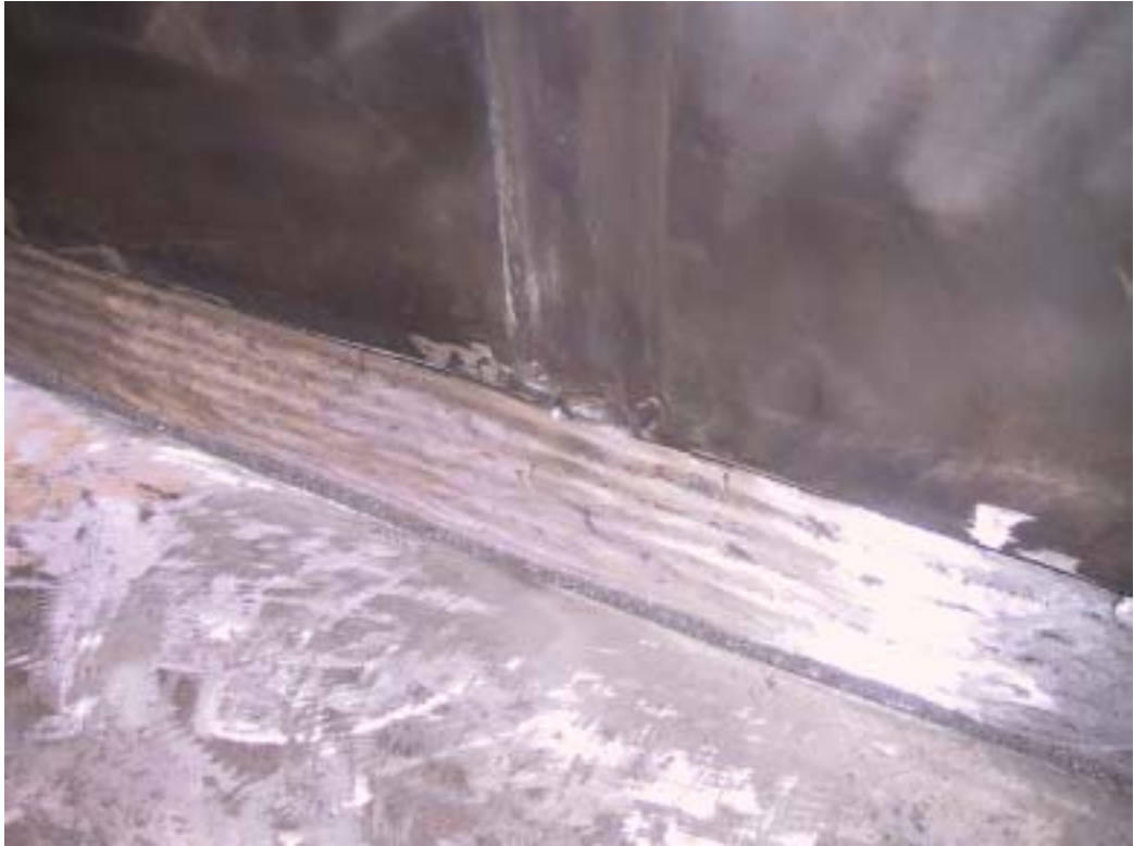
照片十四：基礎銲道研磨後情形
