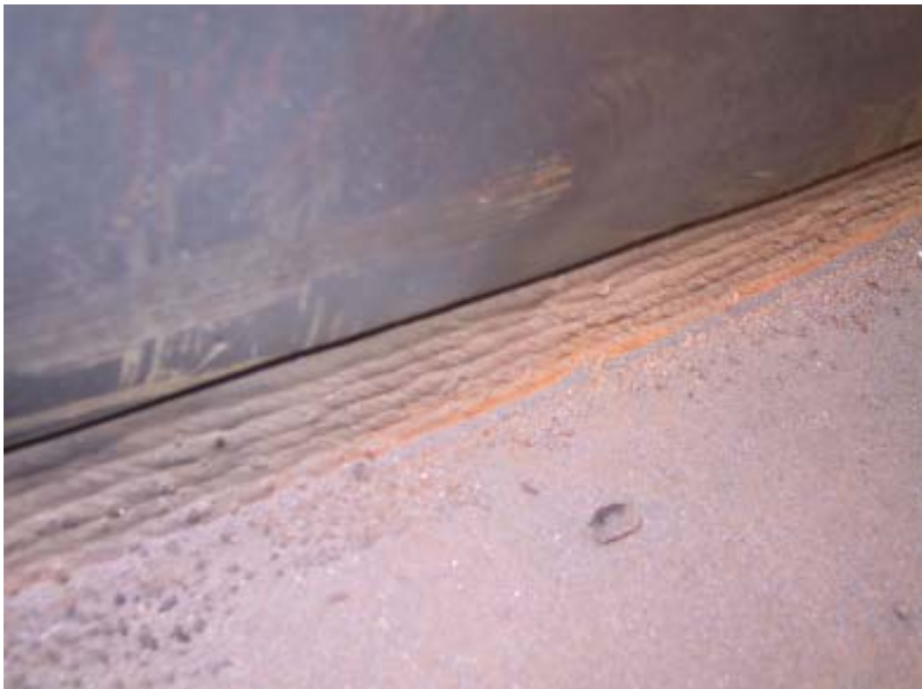
照片十二：基礎鉚道鉚後情形
