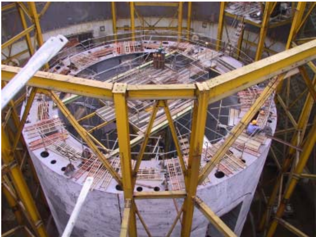
照片二：基座吊裝粗定位後情形
