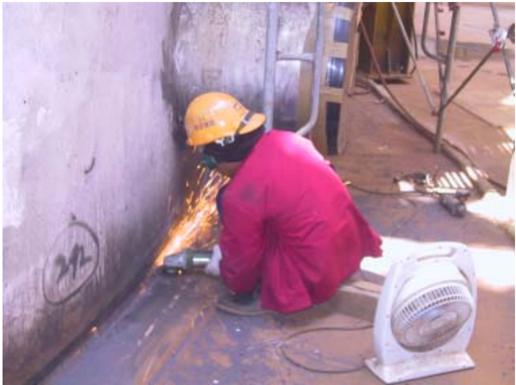
照片十三：基礎銲道研磨情形
