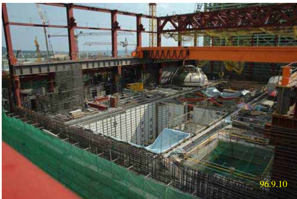
照片二：一號機反應器廠房施工現況
