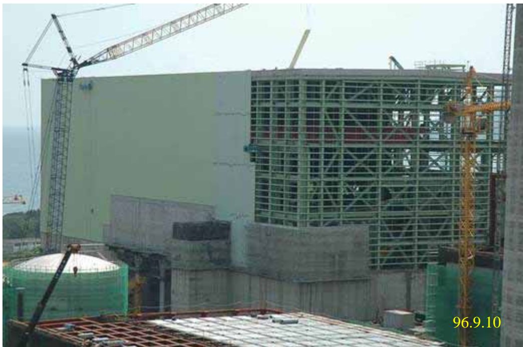
照片四：一號機汽機廠房施工現況
