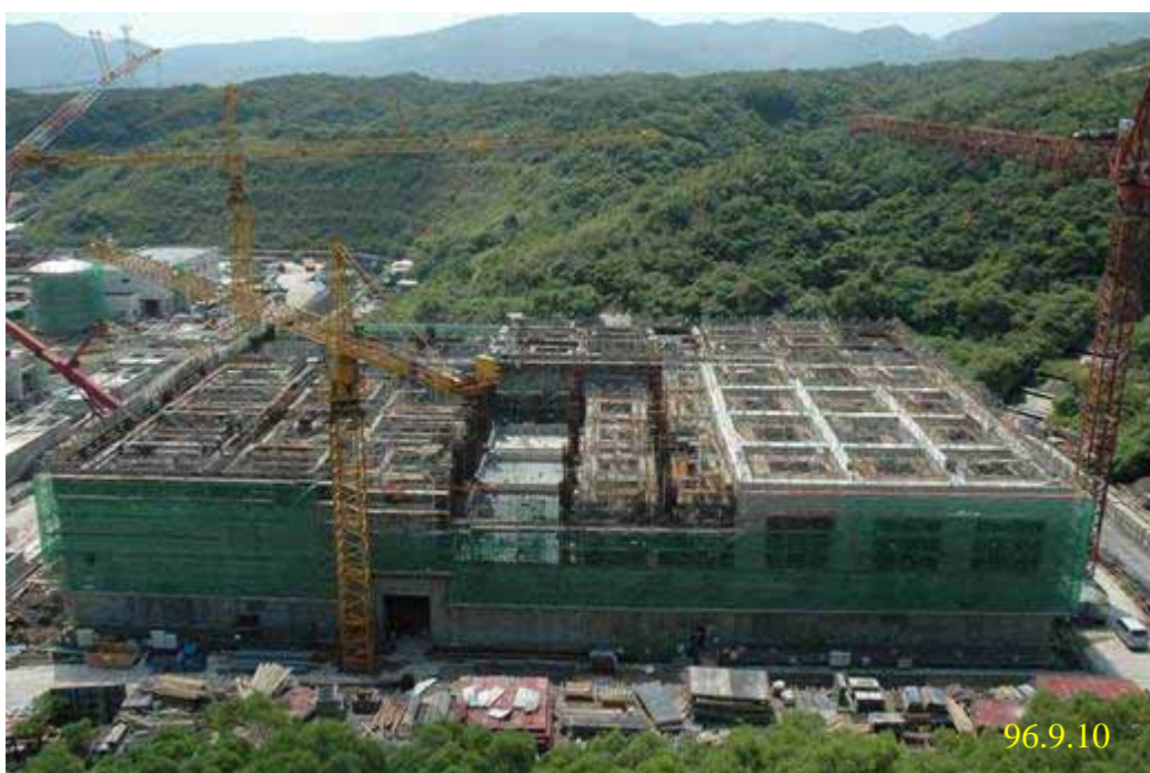
照片六：核廢料廠房施工現況
