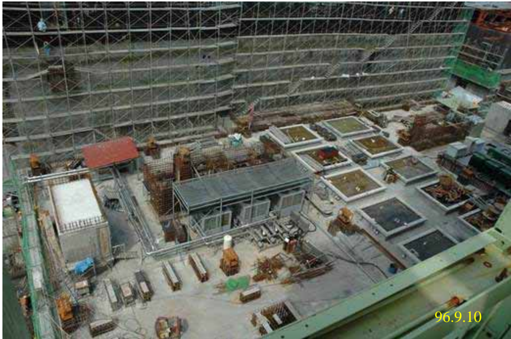
照片三：一號機控制廠房施工現況
