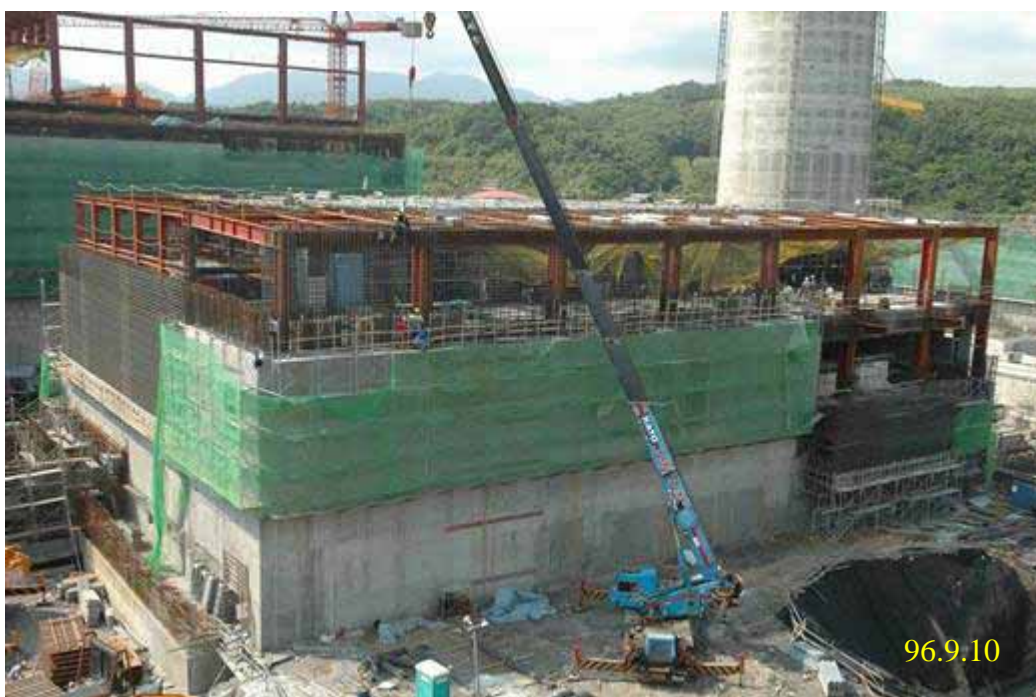
照片五：輔助燃料廠房施工現況
