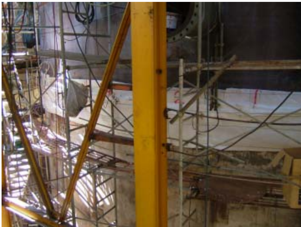
圖十二：整圈鐳道同時執行鐳後熱處理作業情形
