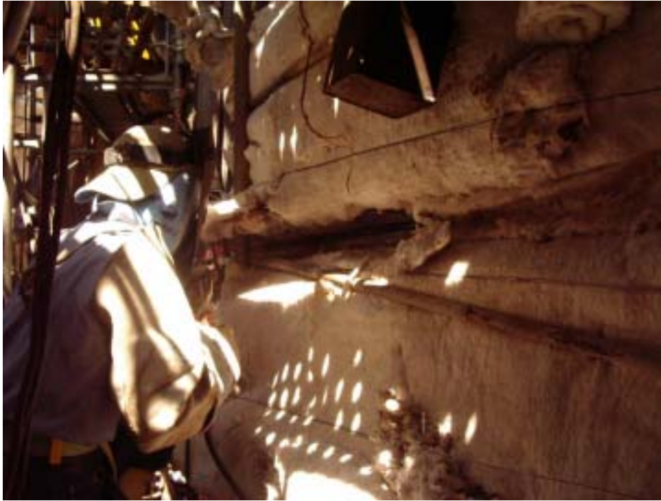
圖三：第一次試鐸作業情形(第 21 號缺陷)
