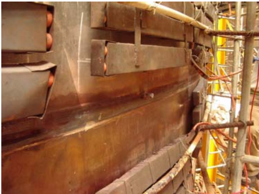
圖八：第二次試鐸後 WN23 鐸道(第 59 號缺陷位置)情形
