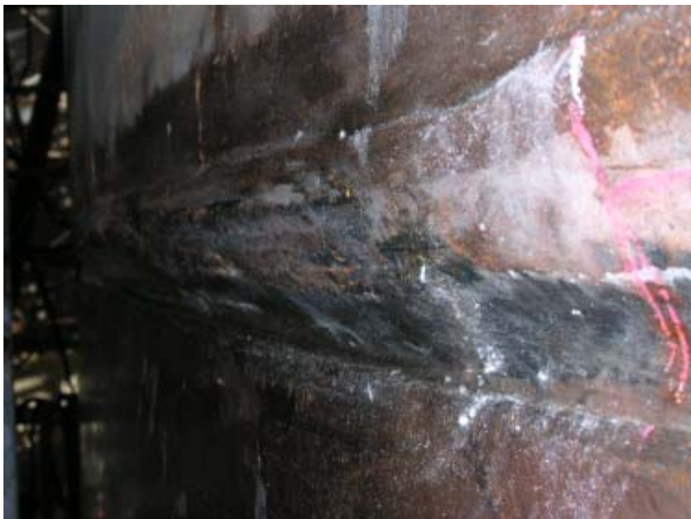
圖十：WN23 鐸道高低落差情形
