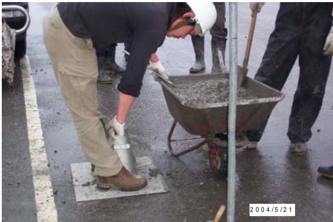
圖六：混凝土澆置中現場取樣試驗情形
