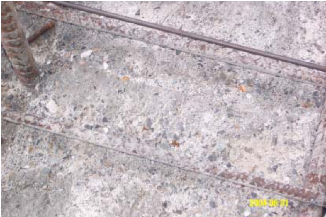
圖十三：澆置後表面潔淨骨材外露情形
