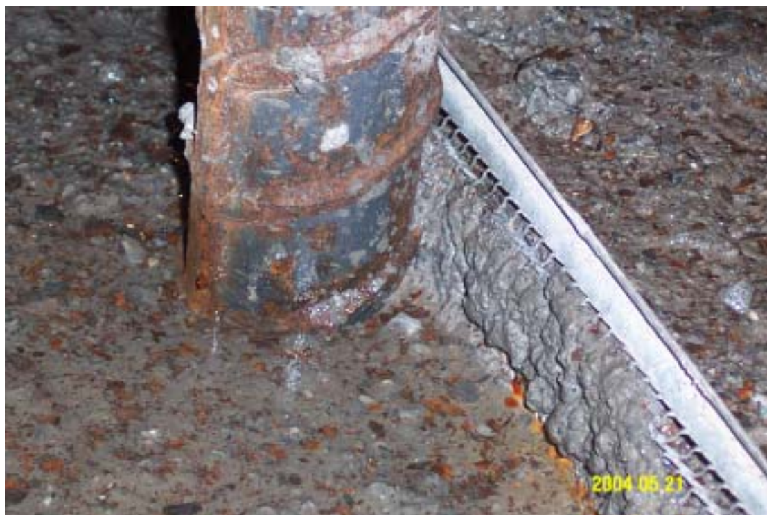
圖四：施工凸樁尺寸改善後情形
