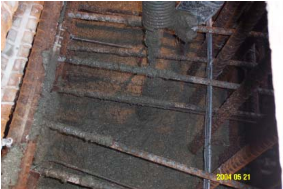
圖十：現場進行混凝土澆置作業情形
