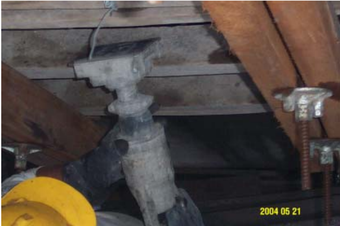
圖十一：澆置中採用外模振動器振動情形
