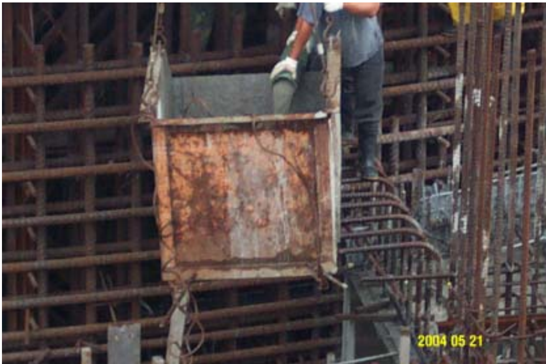
圖八：潤管水泥砂漿以廢料槽裝載運離情形
