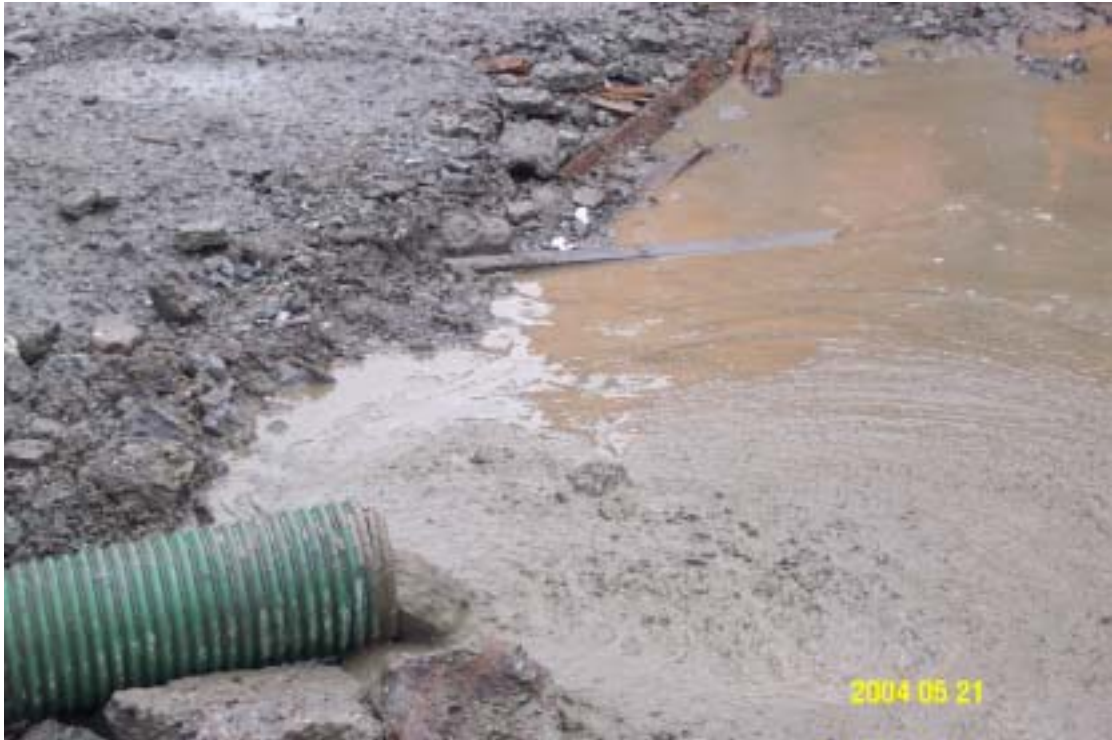
圖九：潤管水泥砂漿傾洩於空地作整地處理情形
