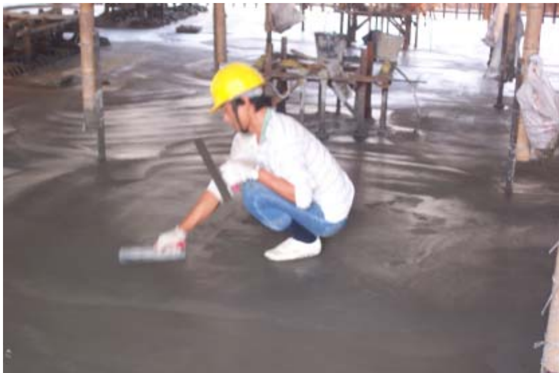
圖十：完成面之 S-2 表面粉光施作情形
