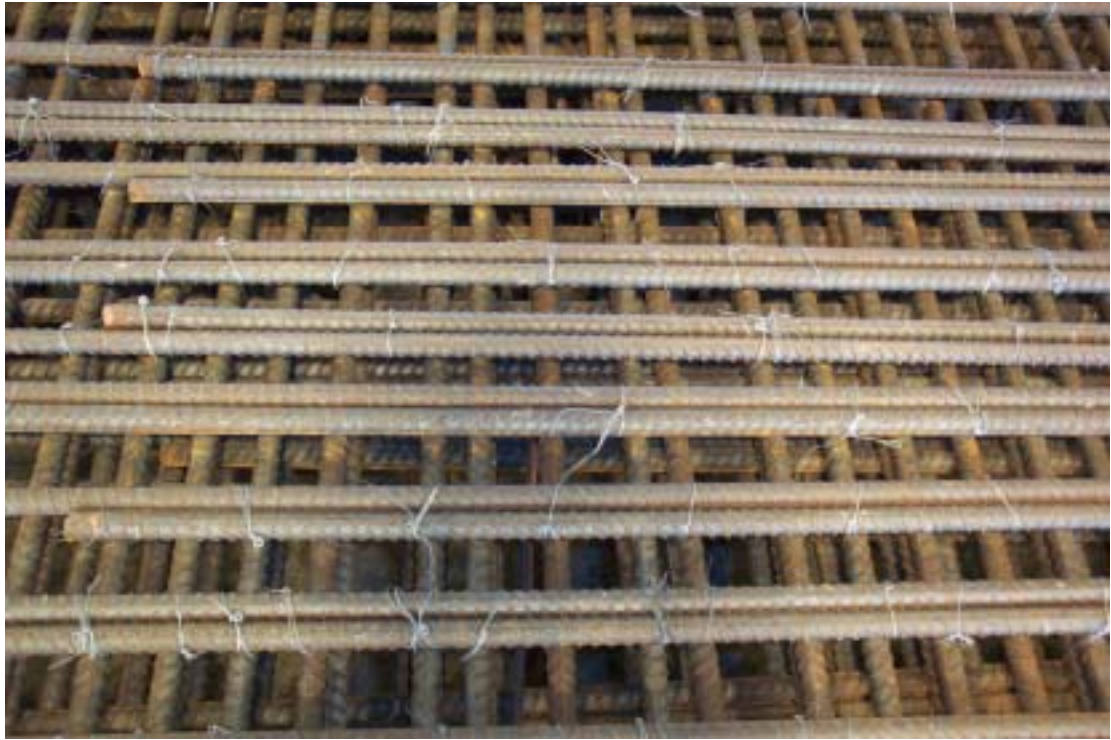
圖一：鋼筋間距改善後情形
