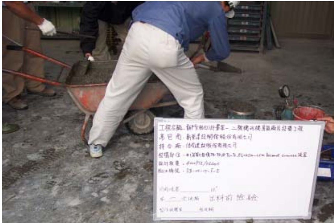
圖三：首次混凝土產製時混凝土取樣試驗（3/31 15：52）
