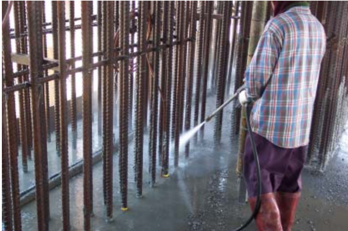
圖十五：澆置後次日即以水刀清洗鋼筋表面上混凝土情形
