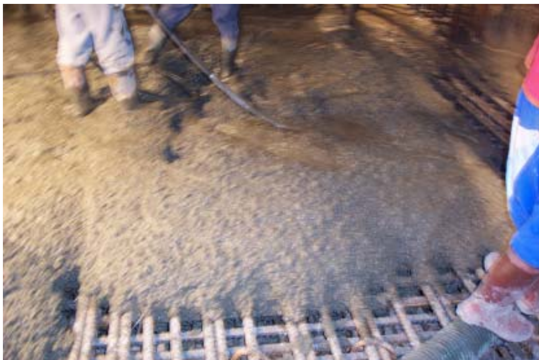
圖八：混凝土堆積在頂層鋼筋上搗實作業執行現況
