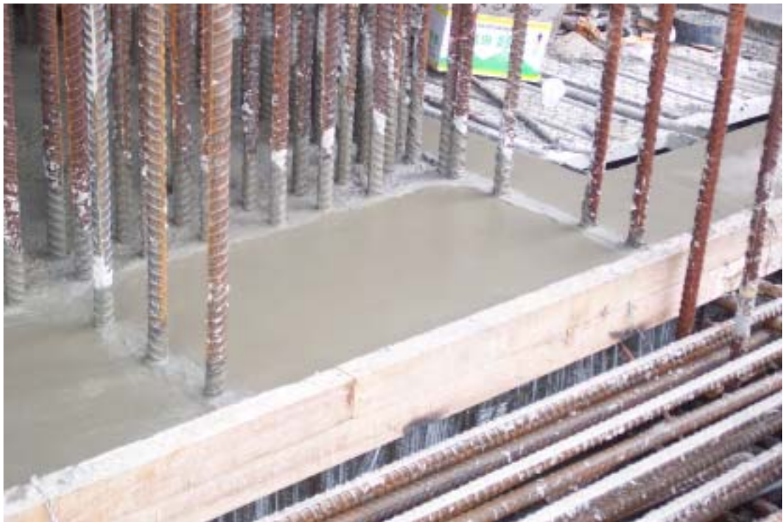
圖十二：接續面應為粗造面卻以表面粉光處理情形
