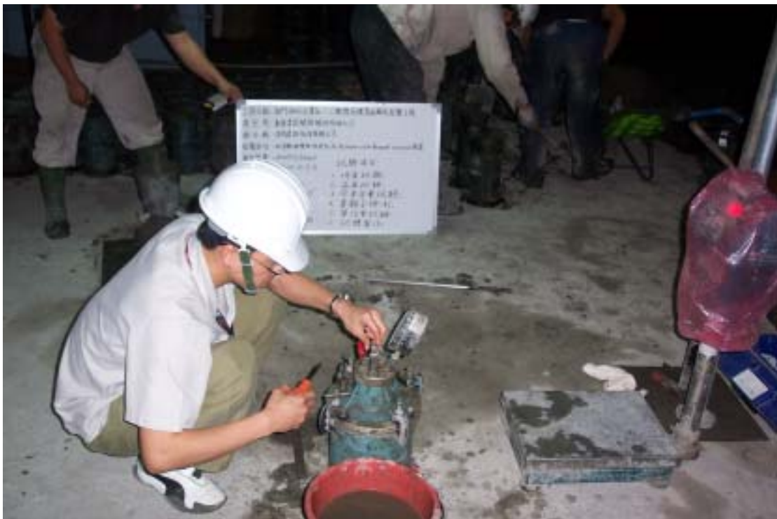
圖四：混凝土含氣量試驗現況（3/31 21：25）
