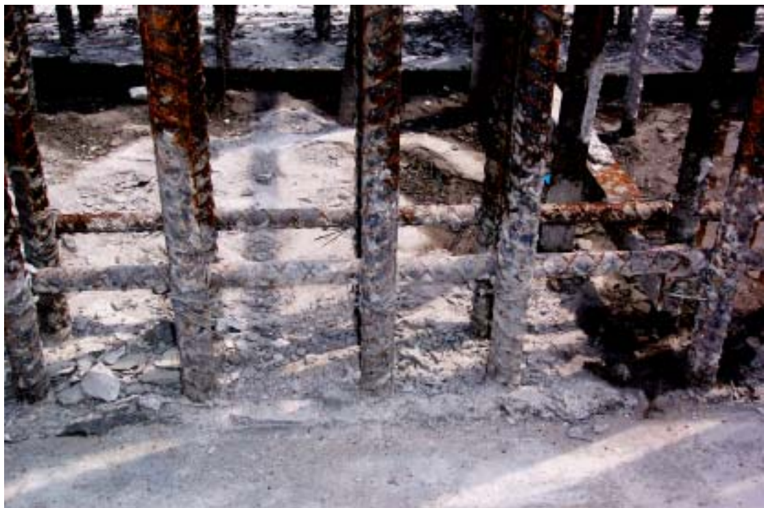
圖十六：部份鋼筋表面混凝土敲除後仍有乳沫附著且打毛作業不確實（僅部份打毛且骨材未外露）情形
