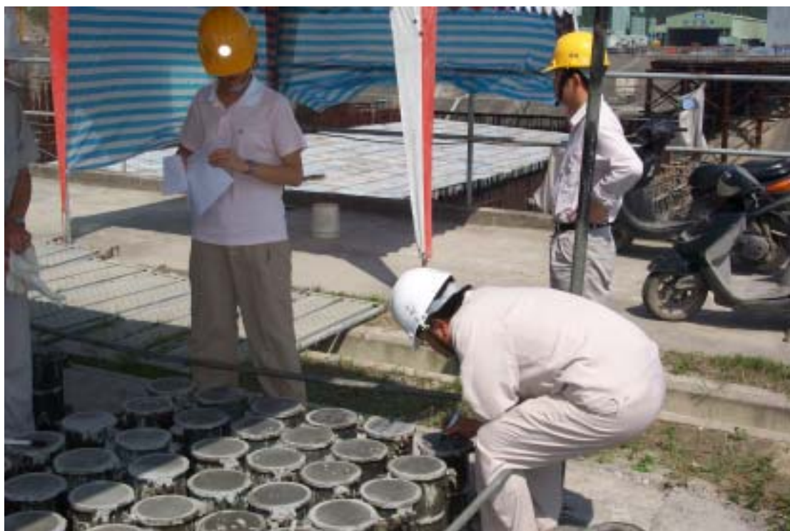
圖十七：混凝土品管員管控試體點收、編號等作業情形
