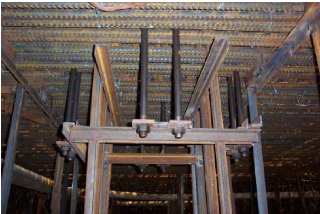
圖二：鋼筋間距改善後情形
