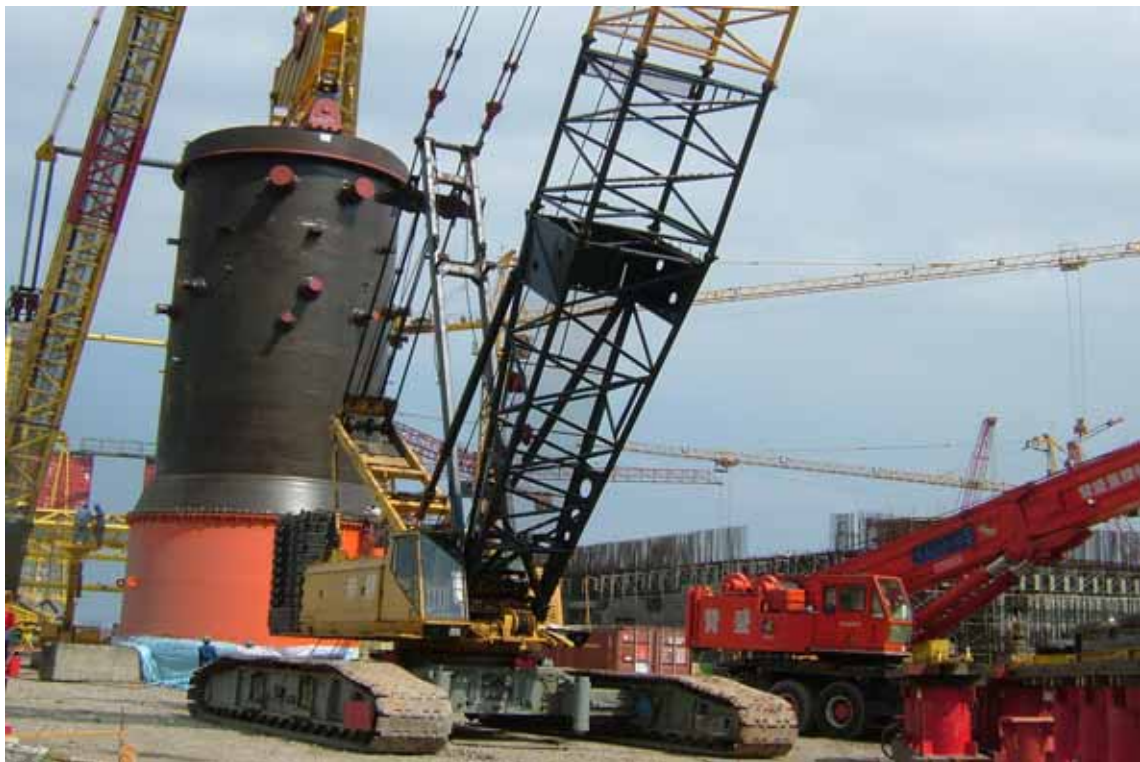
照片十：反應爐壓力容器 (RPV) 吊裝作業 (二)
