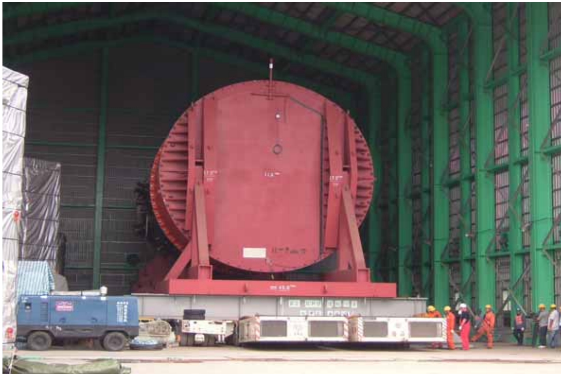
照片六：反應爐壓力容器 (RPV) 運輸作業 (一)
