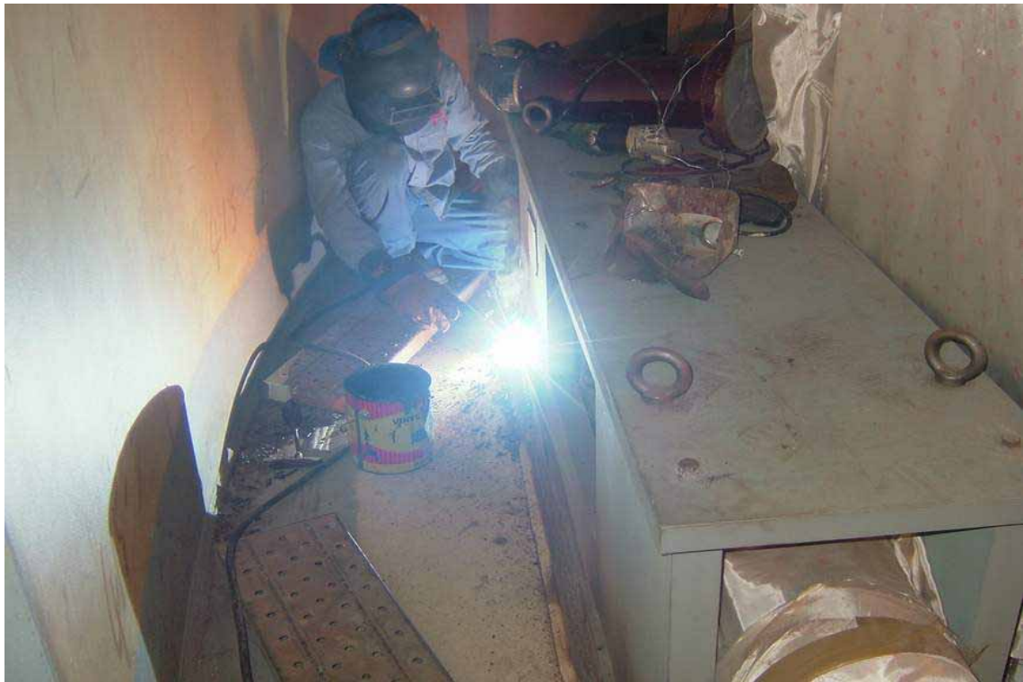
照片十六：穩定器安裝作業（一）
