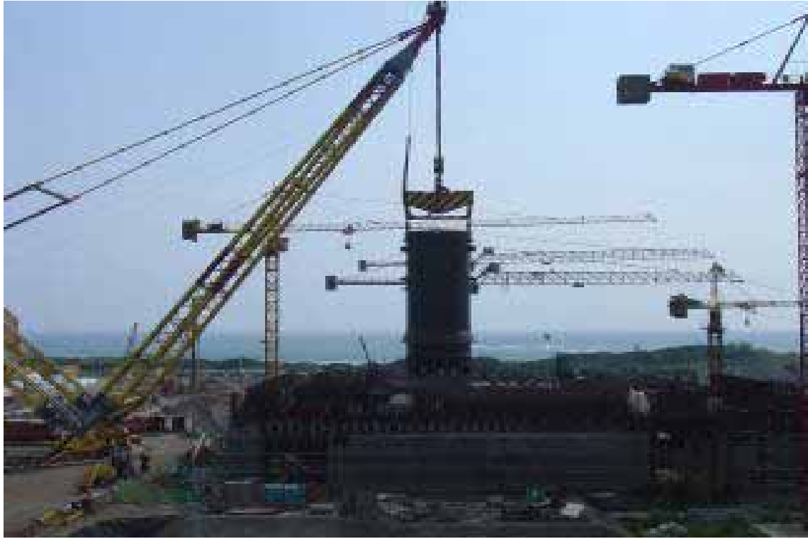
照片十三：反應爐壓力容器 (RPV) 吊裝作業 (五)
