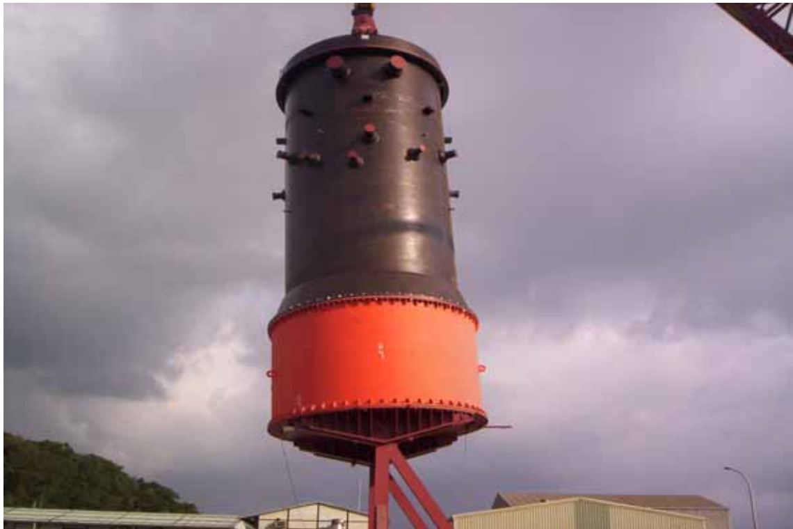
照片十二：反應爐壓力容器（RPV）吊裝作業（四）
