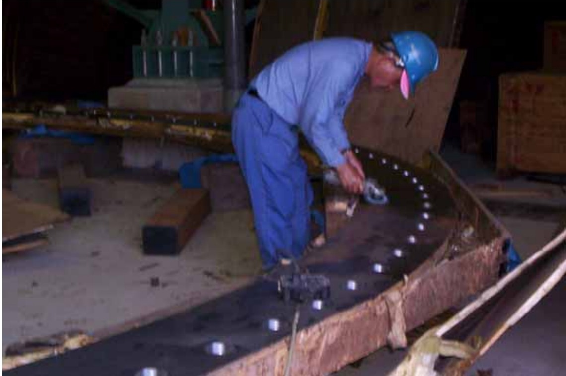
照片一：承载板 (Bearing Plate) 整理
