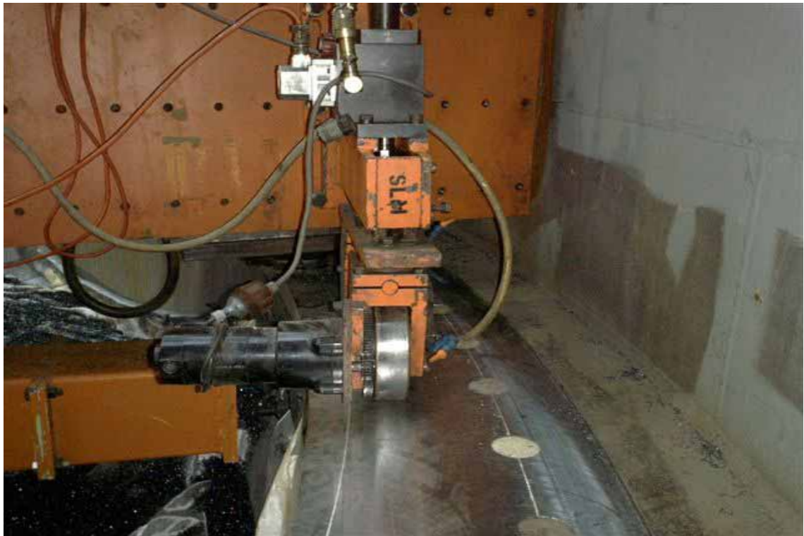
照片二：基座支撑支架研磨 (一)
