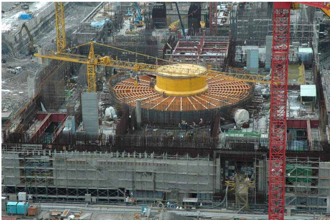
照片十八：反應爐壓力容器（RPV）安裝後現況
