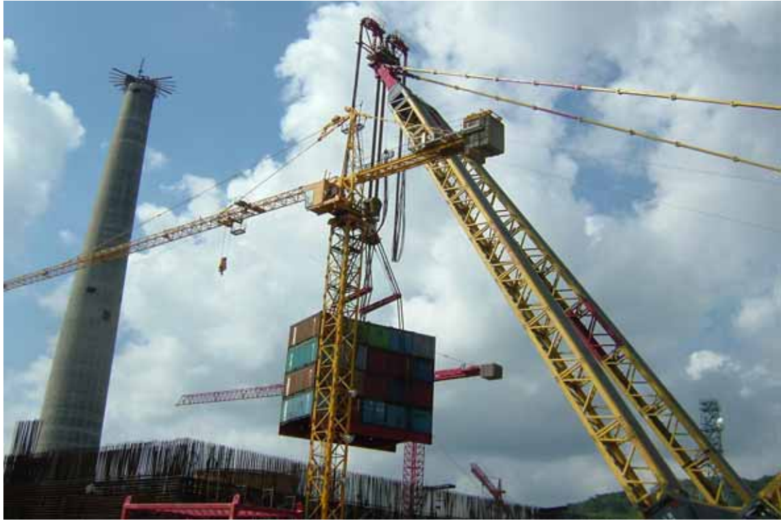
照片五：反應爐壓力容器 (RPV) 試吊作業 (二)
