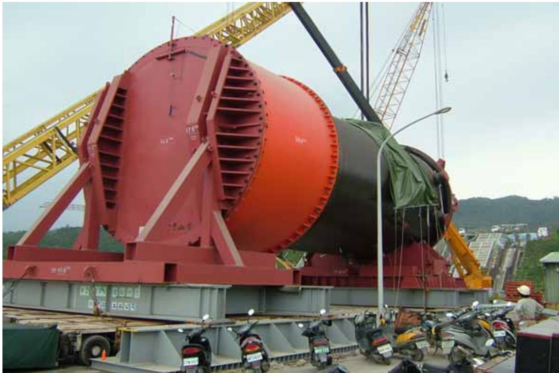
照片八：反應爐壓力容器 (RPV) 運輸作業 (三)
