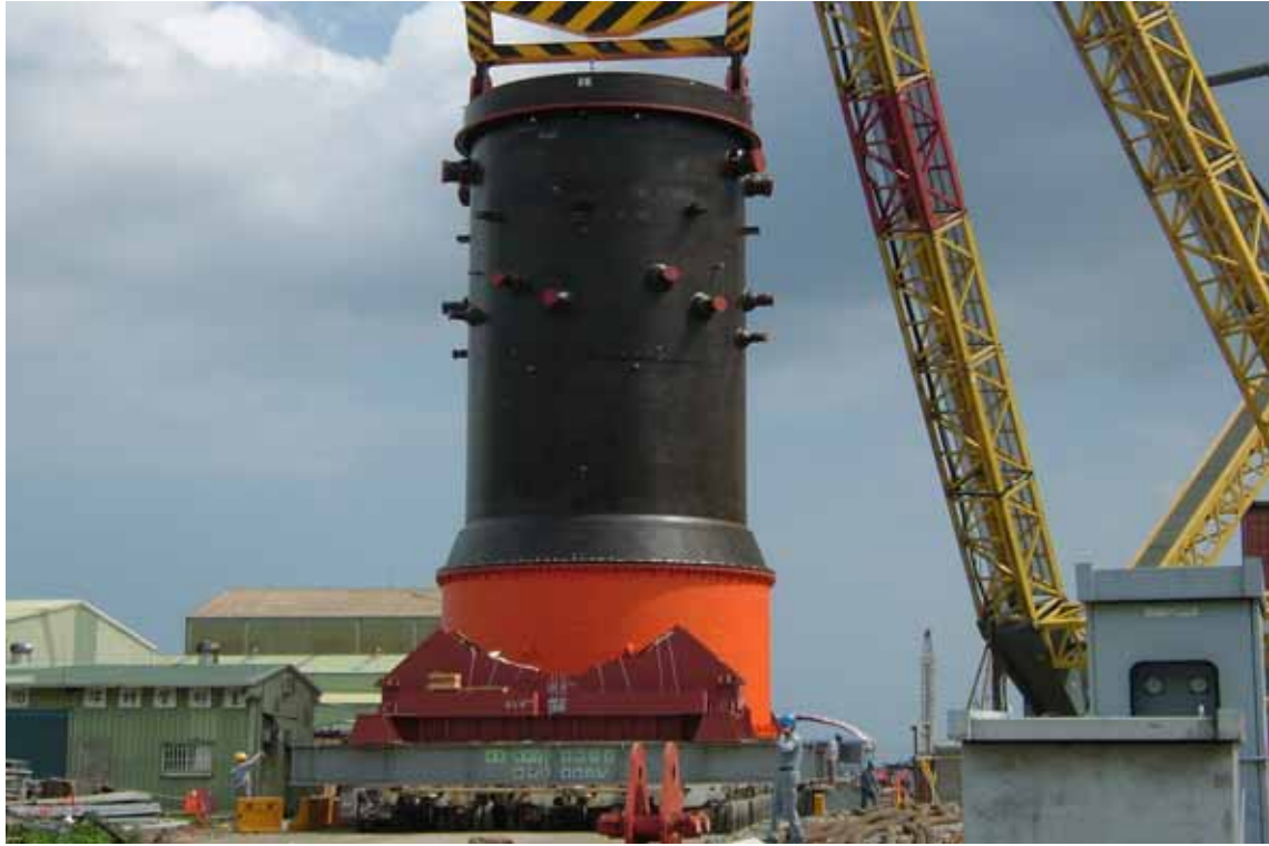
照片十一：反應爐壓力容器（RPV）吊裝作業（三）
