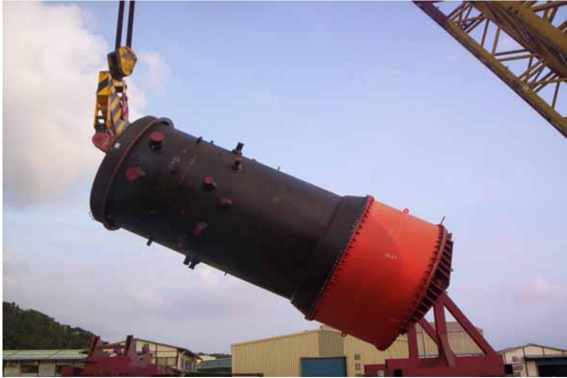
照片九：反應爐壓力容器 (RPV) 吊裝作業 (一)
