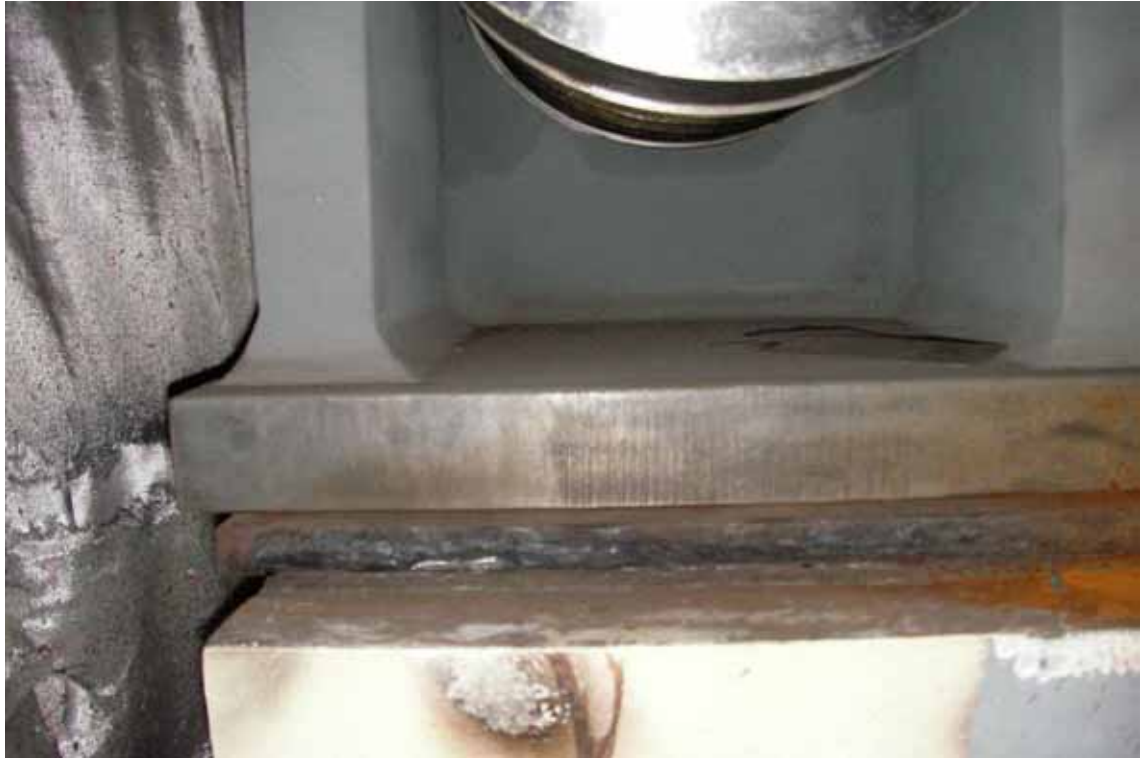
照片十七：穩定器（IN 4501）支撐架墊鉸銲道第二次遭移除後情形
