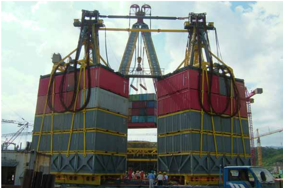
照片四：反應爐壓力容器（RPV）試吊作業（一）
