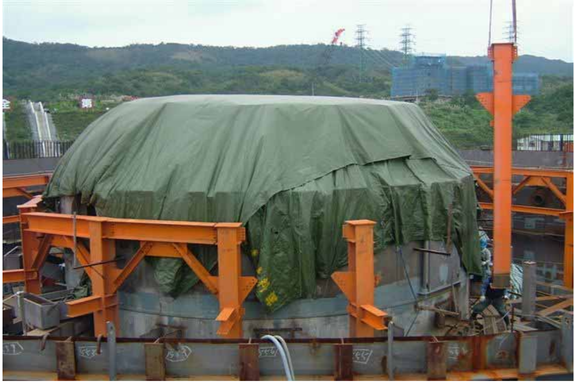
照片十五：反應爐壓力容器（RPV）吊裝後現況
