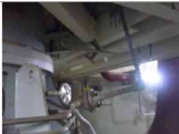
進行管路沖洗時將管線加工彎折
