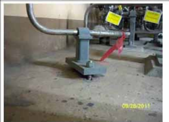
#2 DIV. II 儀器架室：管線支撐座固定螺栓懸空，無水泥砂漿基座，能否發揮原設計支撐功能恐有疑義。
