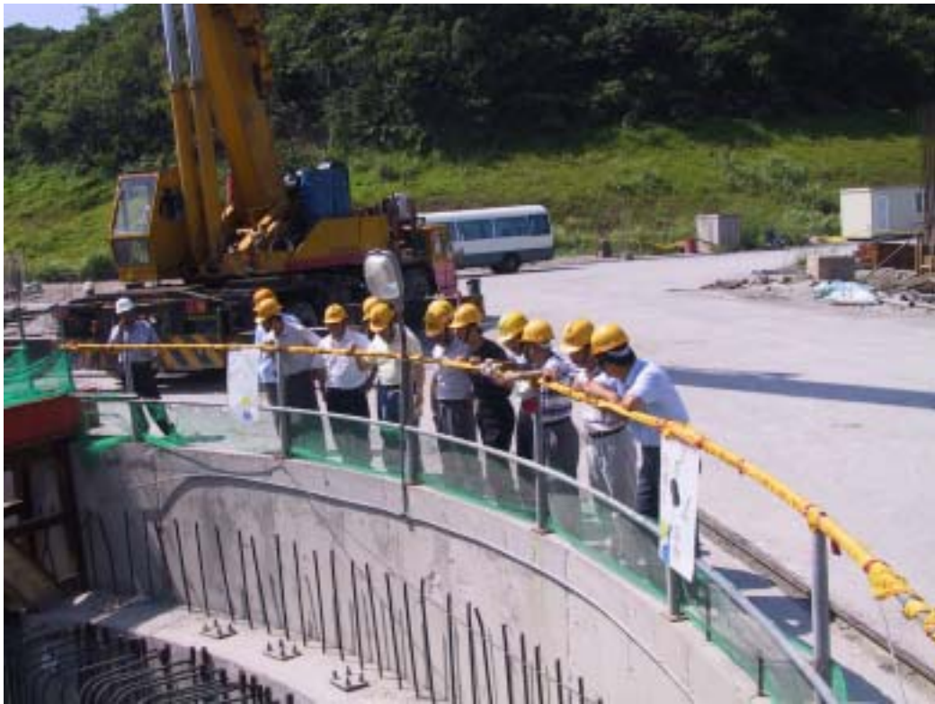
照片九：視察循環冷卻水出水道工程一號出發井情形
