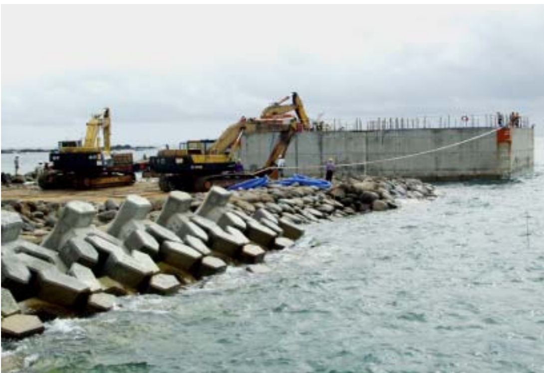
照片六：北防波堤首座沉箱拖放定位施工情形
