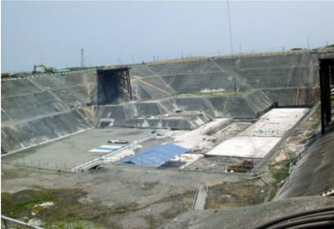
照片五：二號機汽機廠房施工現況
