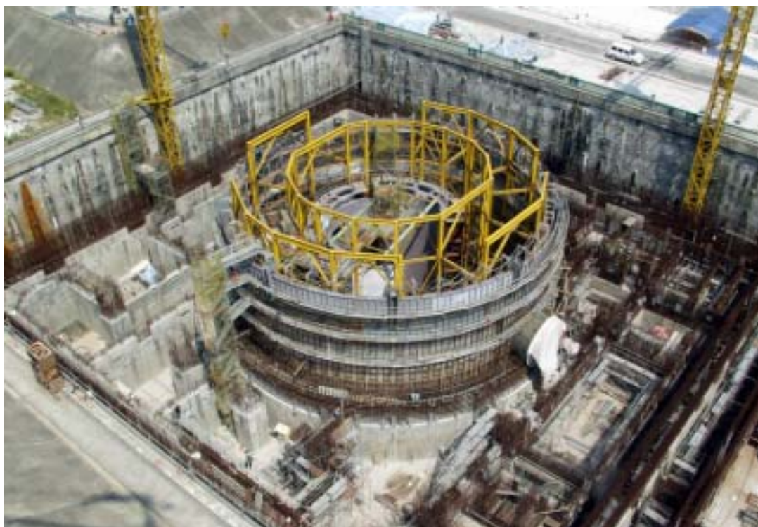
照片二：一號機反應器廠房施工現況
