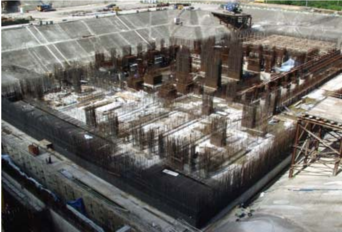
照片三：一號機汽機廠房施工現況
