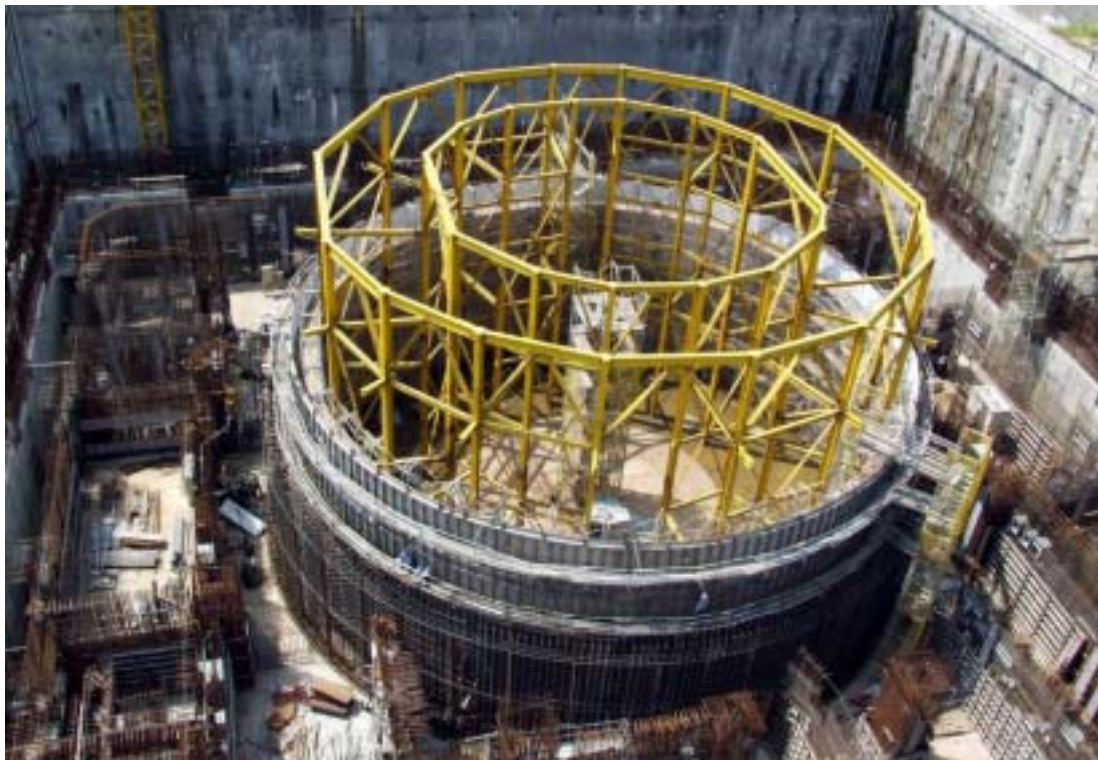
照片四：二號機反應器廠房施工現況
