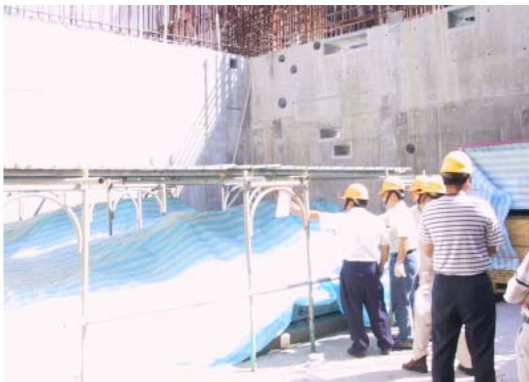
照片八：視察反應器廠房機械設備安裝情形
