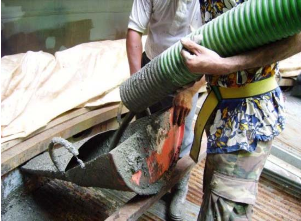
圖 5：二號機基座之 RPV 支撐座澆置情形
