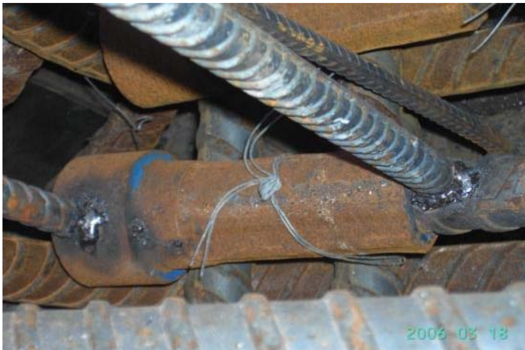
圖 2：埋件支撐銲接於鋼筋上情形
