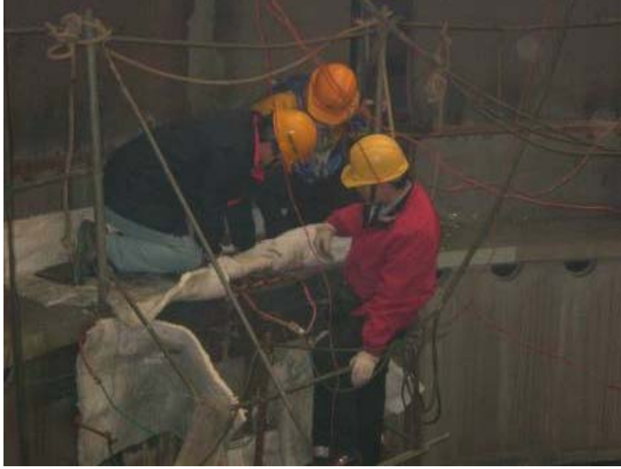
照片二十一、視察基座第三層 Support Skirt Flange 第三次熱處理熱情形
