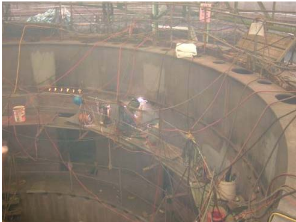
照片十四、基座第四、五層間內鈹水平鐸道施鐸作業情形
