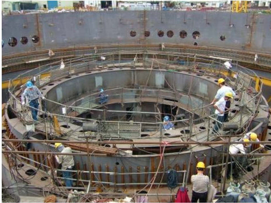
照片十三、基座第五層吊裝後情形
