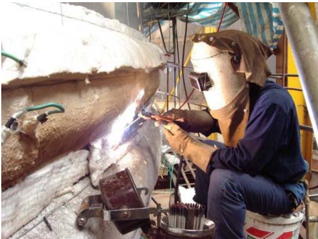
照片二、WN23 鐳道施鐳作業情形(一)
