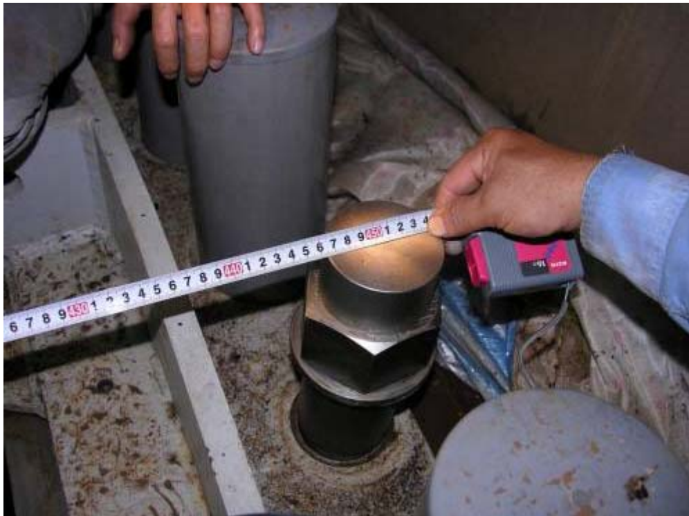
照片二十六、Support Skirt Flange 上反應器基礎螺栓安裝後量測情形(二)
