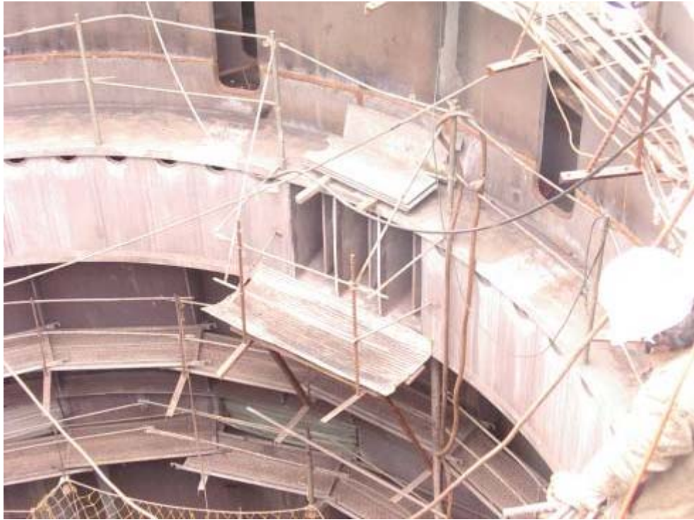
照片十五、基座第三層 Support Skirt Flange 內加強肋鈹結構
