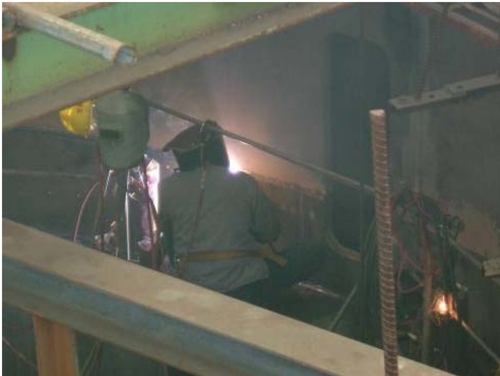
照片十二、基座第三、四層間內鈹水平鐸道施鐸作業情形
