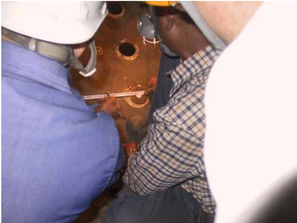
照片二十四、Support Skirt Flange 上反應器基礎螺栓孔鑽孔後孔位量測情形(二)
