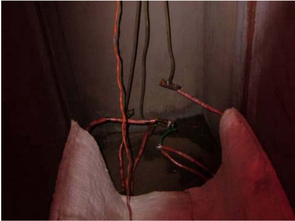
照片十九、基座第三層 Support Skirt Flange 第一次熱處理保溫毯耦佈置情形
