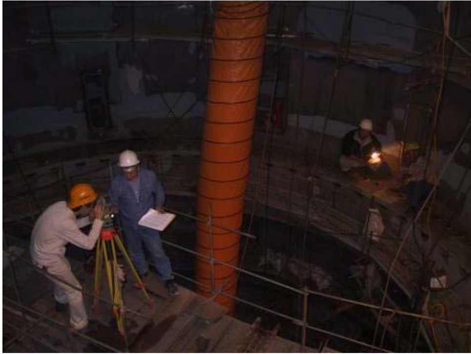
照片二十三、Support Skirt Flange 上反應器基礎螺栓孔鑽孔後孔位量測情形(一)
