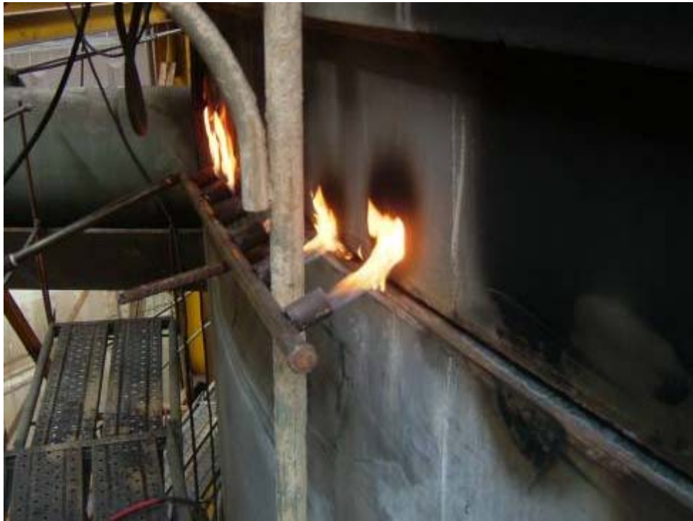
照片九、基座第二、三層間外板水平銲道施銲作業情形(一)
