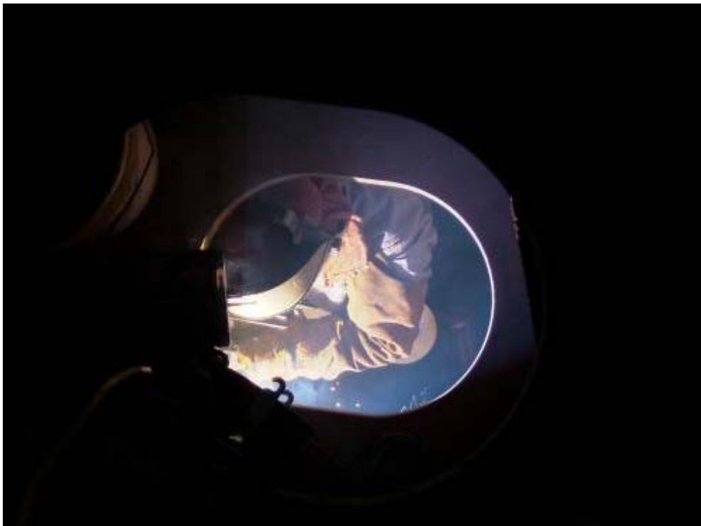
照片十、基座第二、三層間外板水平銲道施銲作業情形(二)
