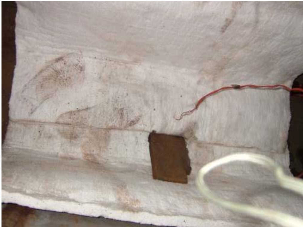
照片十八、基座第三層 Support Skirt Flange 第一次熱處理熱電耦佈置情形
