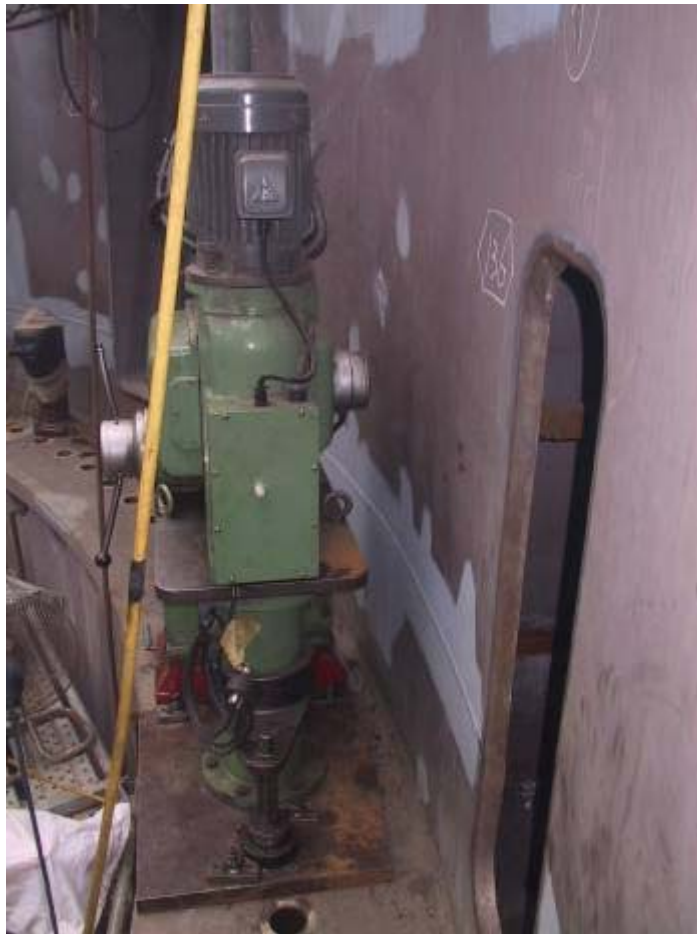
照片二十二、基座第三層 Support Skirt Flange 上反應器基礎螺栓孔鑽孔情形
