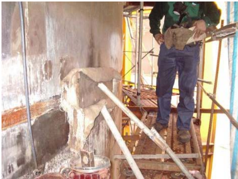
照片八、WN23 鐸道鐸接缺陷修補後持溫情形
