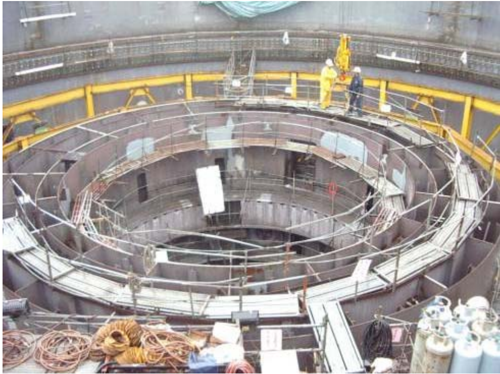
照片十一、基座第四層吊裝後情形
