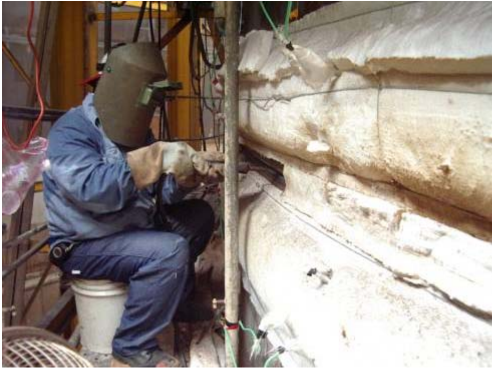
照片三、WN23 鐸道施鐸作業情形(二)
