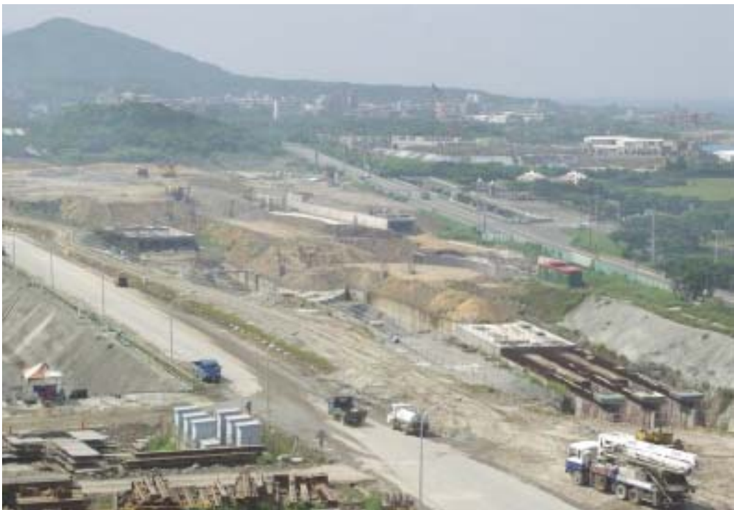
照片六：進水暗渠施工現況
