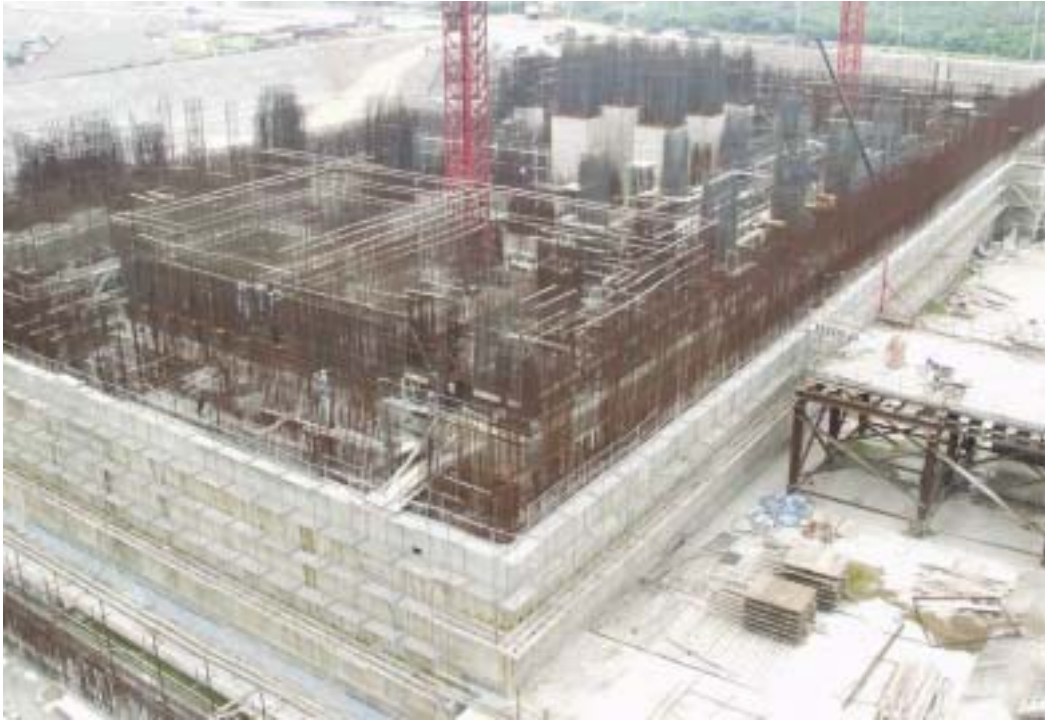
照片三：一號機汽機廠房施工現況
