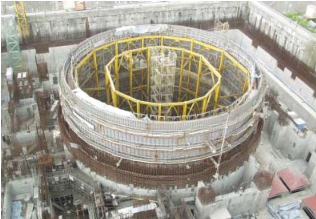
照片四：二號機反應器廠房施工現況
