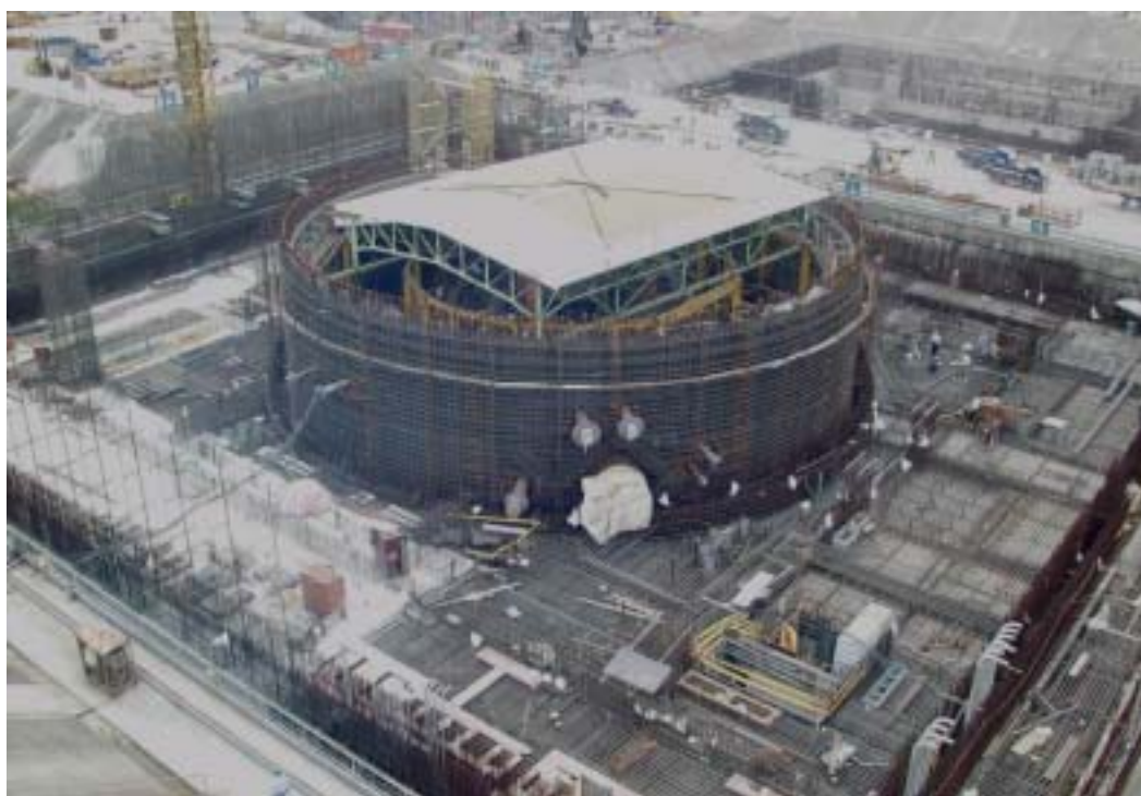
照片二：一號機反應器廠房施工現況
