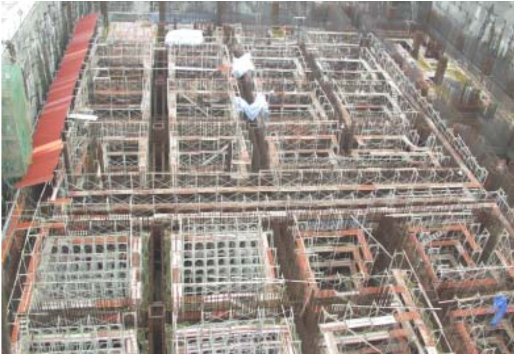
照片七：核廢料廠房施工現況
