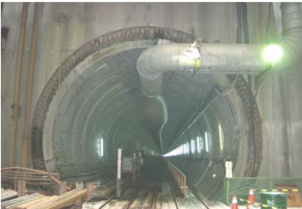
照片八：出水道工程一號機潛盾隧道施工現況
