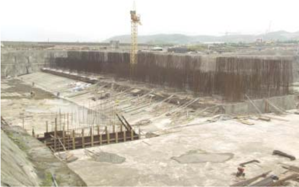
照片五：抽水機房施工現況
