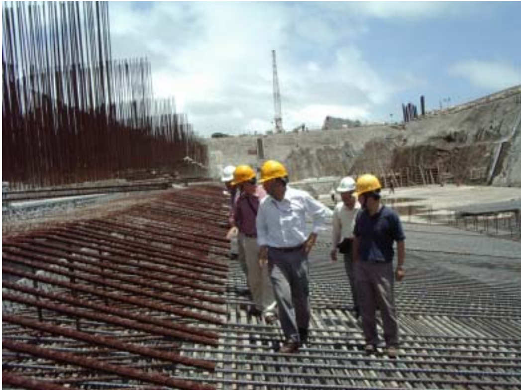
照片九：視察抽水機房施工現場情形
