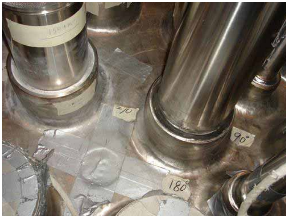
圖-21、960810 爐內 CRDH 安裝狀況：上圖為 CRDH 02-35 在完成 9mm 銲道厚度後的場景，右下角為已經完成銲接的 ICH；下圖右邊為已完成全部銲程並通過 Go-guage 的 CRDH 34-35，左邊為完成 9mm 厚之 CRDH 30-35，十字形膠布中間的圓孔為 RWCU 爐底洩水孔。
