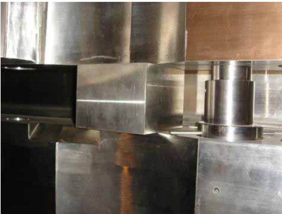
圖-12、960511 在爐內所見爐心底鈹安裝中的場景。照片上方為爐心底鈹之局部；中間方塊為臨時之 spacing block，圓柱為 seismic pin、與 eccentric sleeve；下方則為 shroud 之 core plate ledge。
