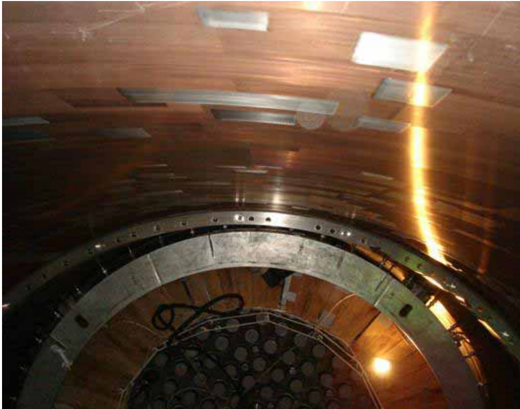
圖-7、爐心側板初安置進 RPV 之狀況；焊道在爐內高程約 2.4 米，即下層白色環狀處向外輻射之處。上層白色環狀處即為 core plate ledge；其上的穿透孔為供爐心底板螺栓孔，白色反光亮點為供爐心底板安裝 seismic pin 之處。
