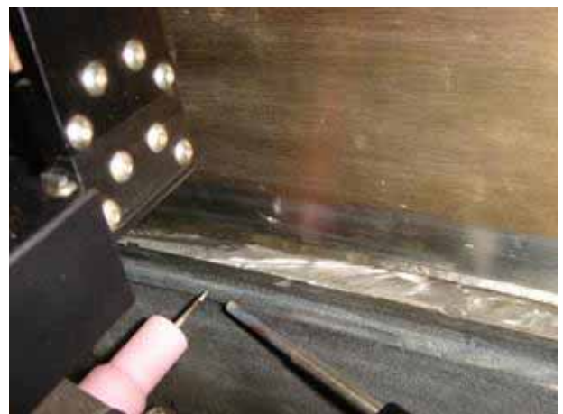
圖-8、左圖為外側第 3 層焊接完畢後，在 0° 附近執行第 2 次 NDE 現場；右圖為將自動電焊機移至 shroud 內側準備第 4 層焊接之場景。
