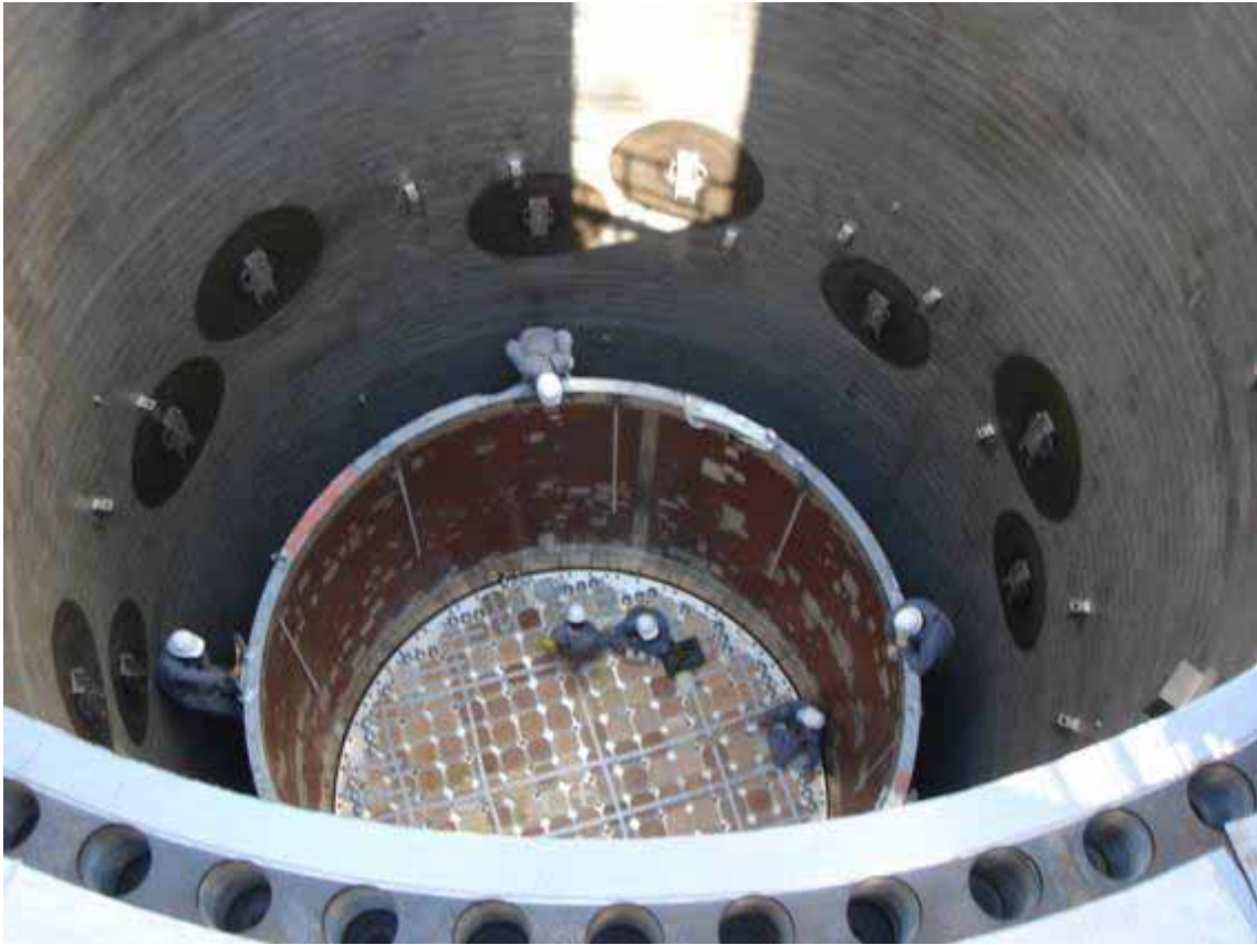
圖-10、960419 爐心底板初吊入 RPV 爐內時之場景。本圖下面圓弧為 RPV upper flange 及螺栓孔，其高程約 17.7 米；上面中間日照縫者為 30°MFW Nozzle，其高程約 11.6 米，以及 10° SD outlet Nozzle，其高程約 10.9 米；圖中間圓圈為 shroud 上法蘭，高程約 9.3 米，正面工作人員左側法蘭面的凹槽即為 0° 位置；更內圈則為 core plate，將來定位後高程約 5.1 米，其詳細安裝相關數據如下：shroud 上法蘭內徑 5461mm、nominal 內徑 5490mm、core plate ledge 內徑 5269mm；core plate 外徑 5435mm。
