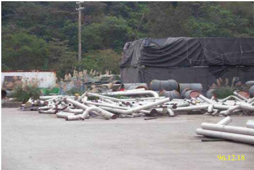
照片七：冷凝水儲存傳送系統管路露天堆疊儲存未墊高情形
