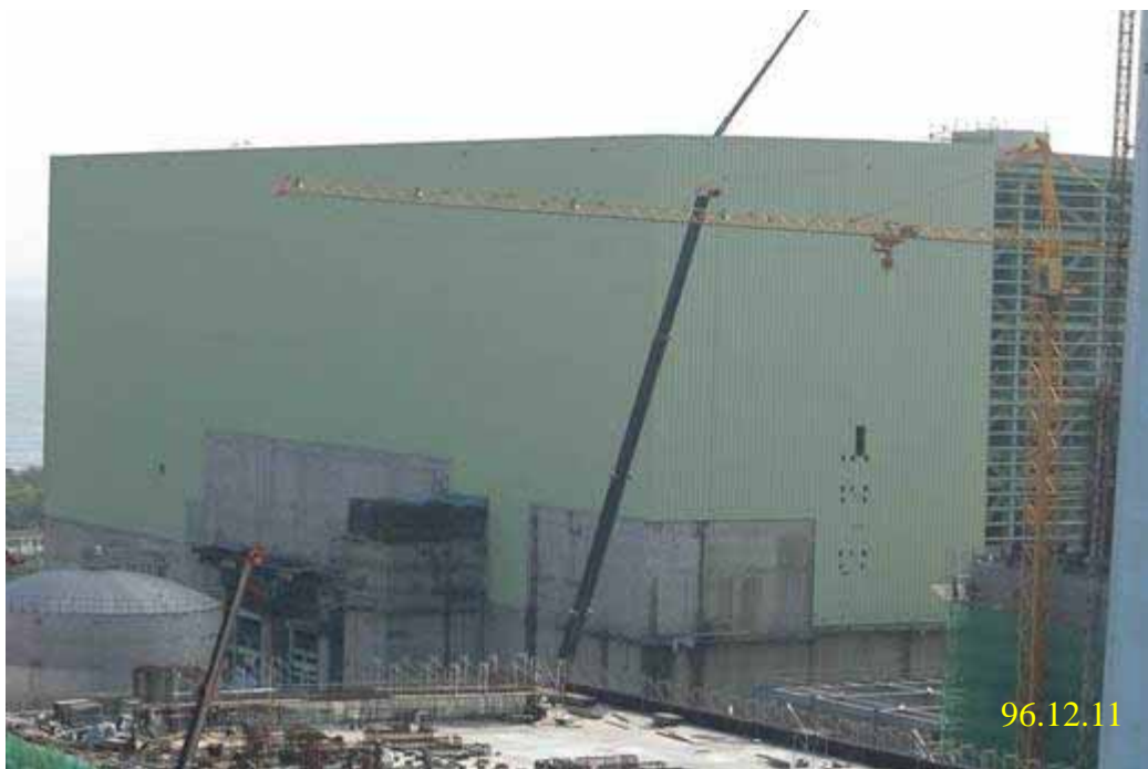
照片四：一號機汽機廠房施工現況
