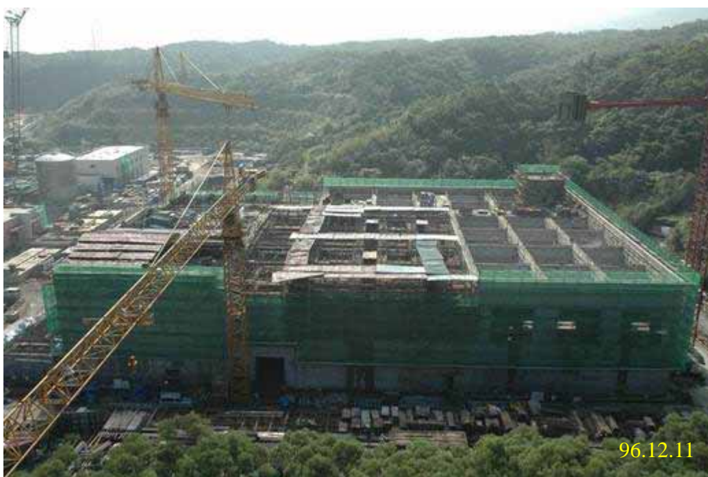
照片六：核廢料廠房施工現況
