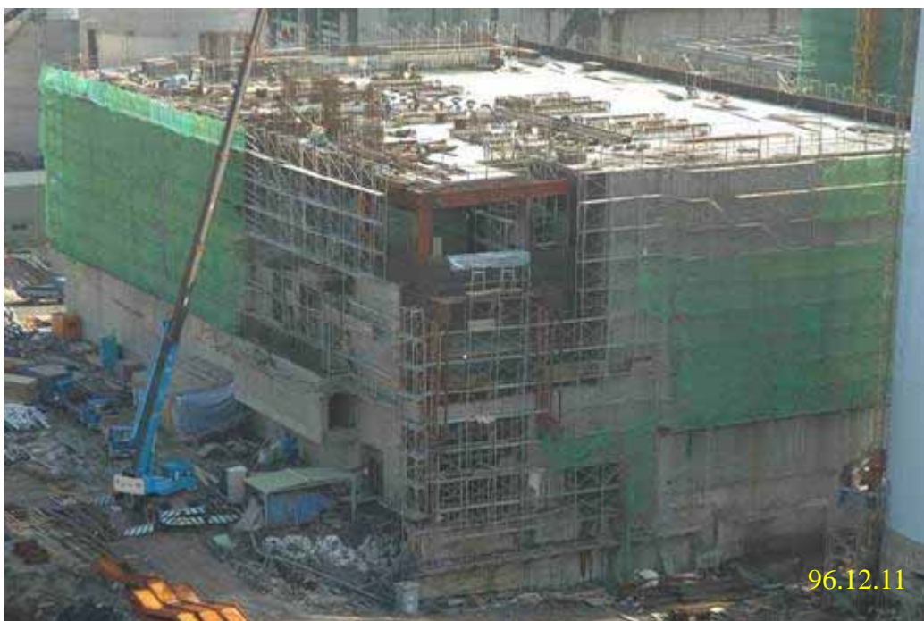
照片五：輔助燃料廠房施工現況
