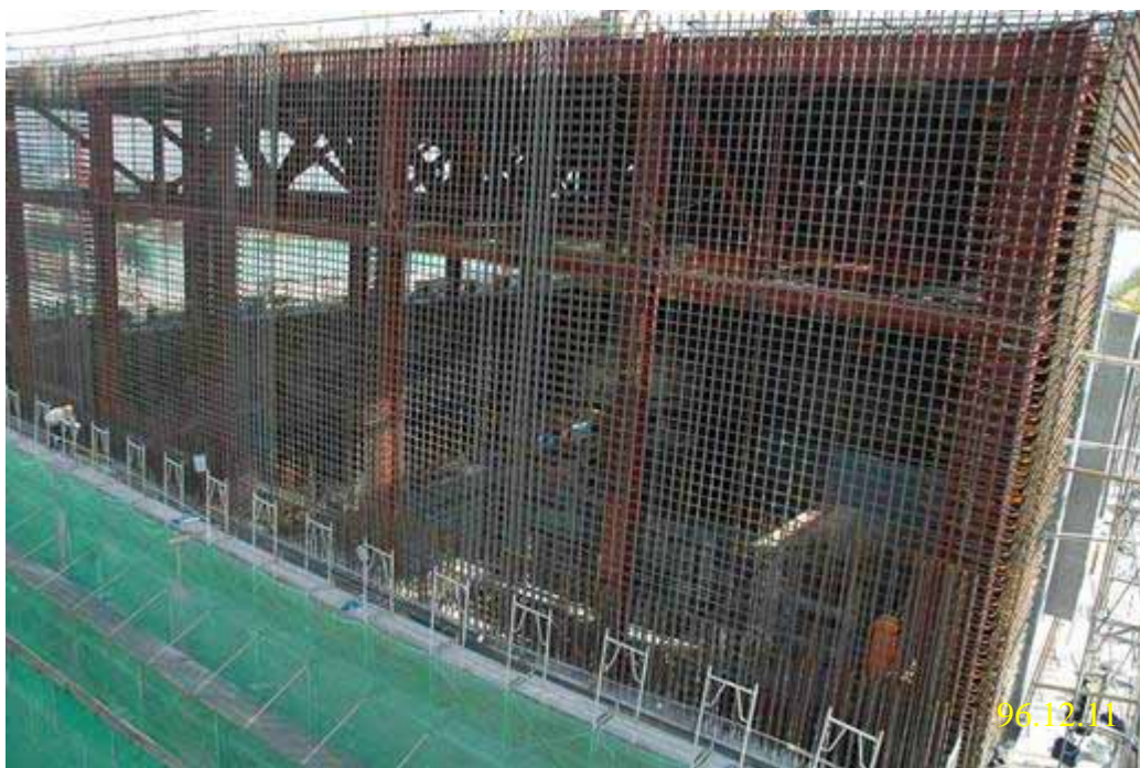
照片二：一號機反應器廠房施工現況
