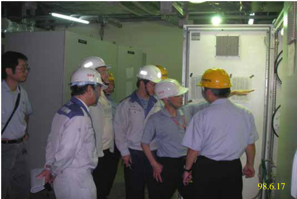
照片九：日本專家執行電氣盤面檢查現況
