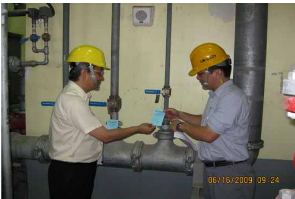
照片七：龍門電廠一號機初始測試掛卡管制作業視察現況
