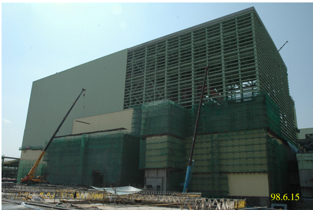
照片三：二號機汽機廠房施工現況
