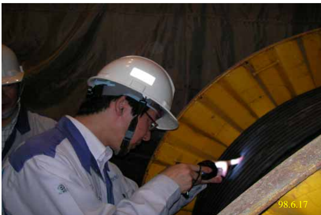
照片八：日本專家執行電纜線檢查現況
