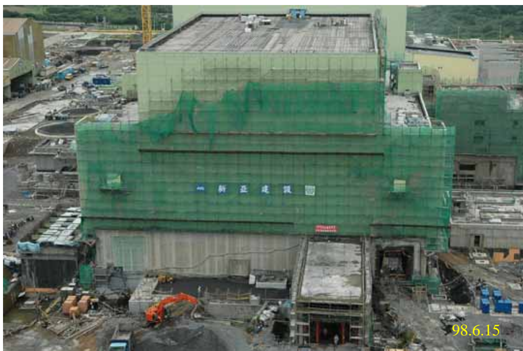
照片二：二號機反應器廠房施工現況
