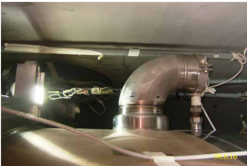
照片四：二號機 RPV HPCF Top Guide Side Elbow 安裝施工現況
