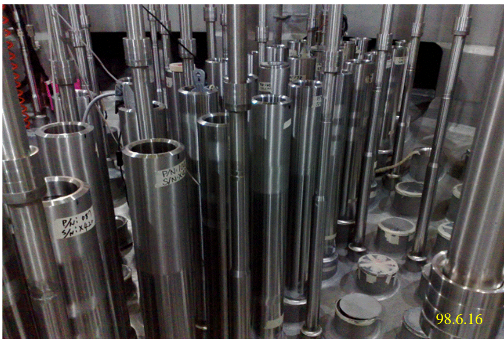
照片五：二號機反應器控制棒驅動殼安裝施工現況
