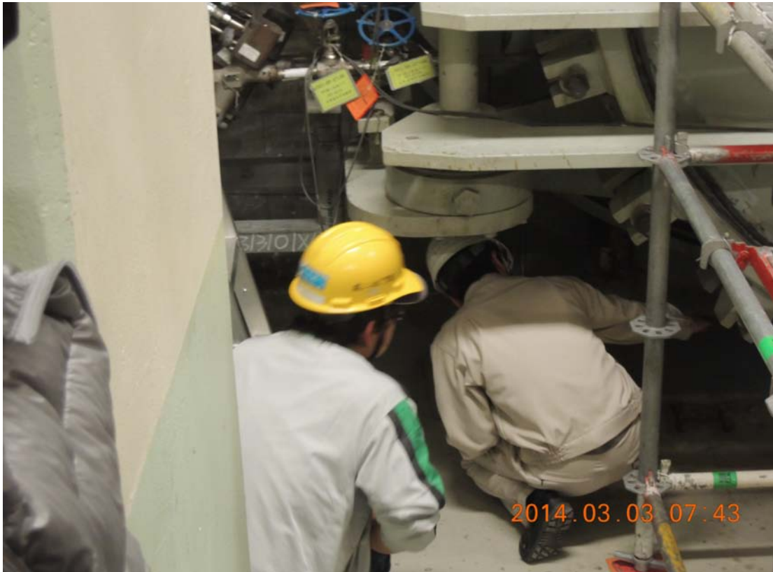
照片 11：SIT 測試完全解壓後之 RCCV 外牆與混凝土裂縫 Mapping 現場目視檢查作業情形
