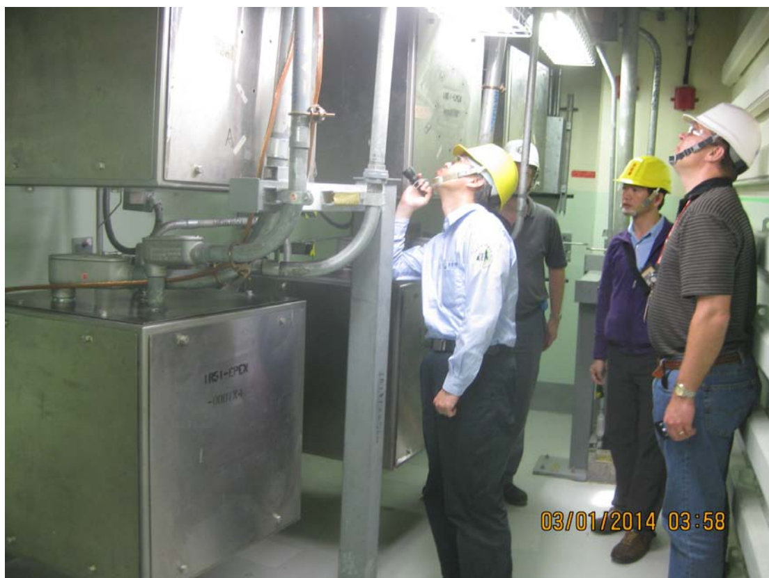
照片 10：SIT 測試最大壓力持壓期間之 RCCV 外牆現場目視檢查作業情形
