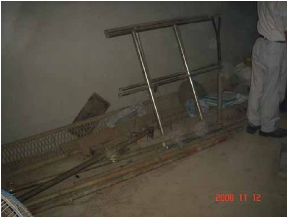
管路水壓測試現場仍堆放他項施工遺留之管架雜物
