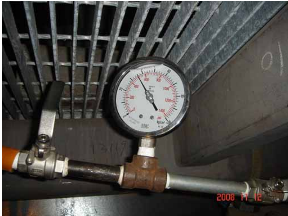
管路水壓測試的壓力錶，指示為測試壓力 36\text{kg/cm}^2
