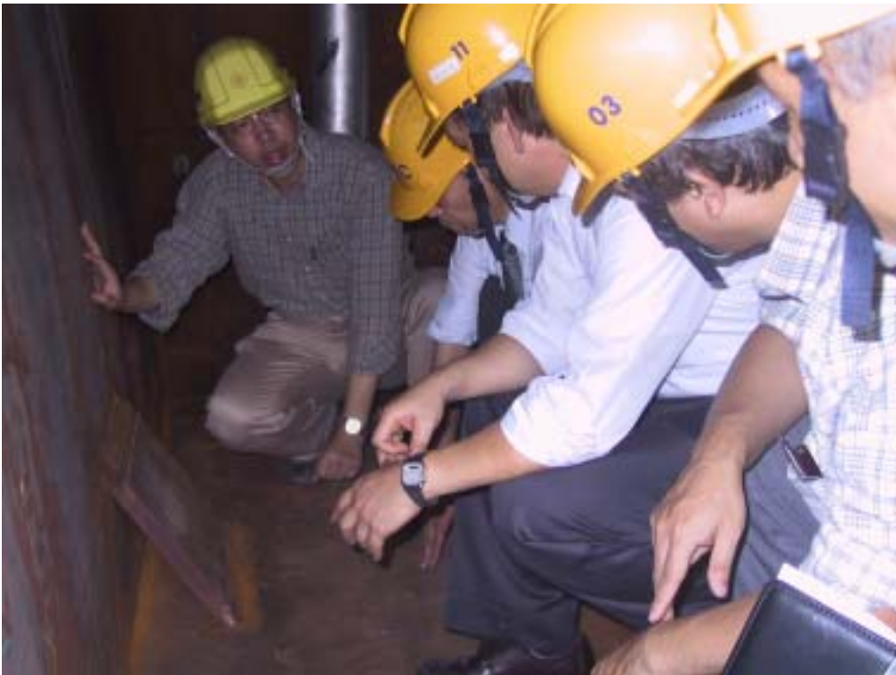
照片六：視察反應器基座第一層輔助板拆除作業情形
