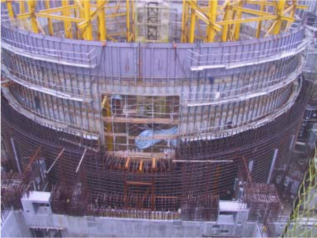
照片三：二號機反應器廠房施工現況
