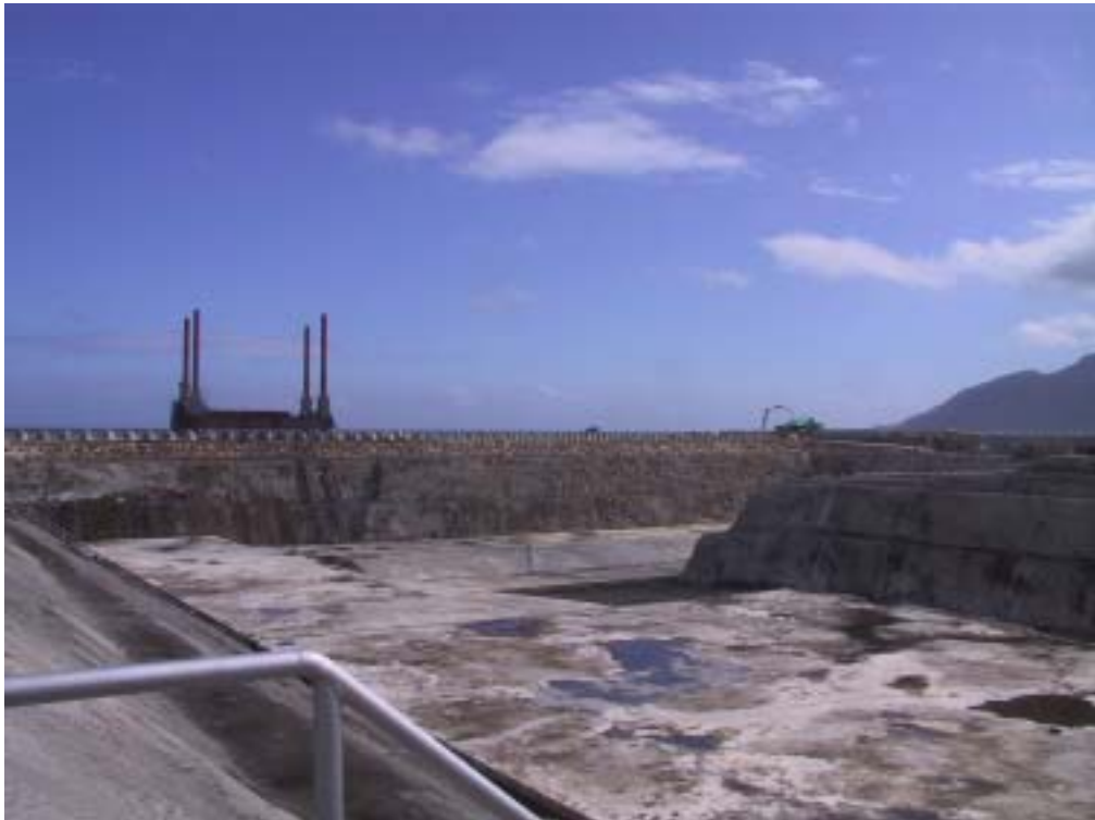
照片四：循環冷卻水抽水機廠房工程施工現況
