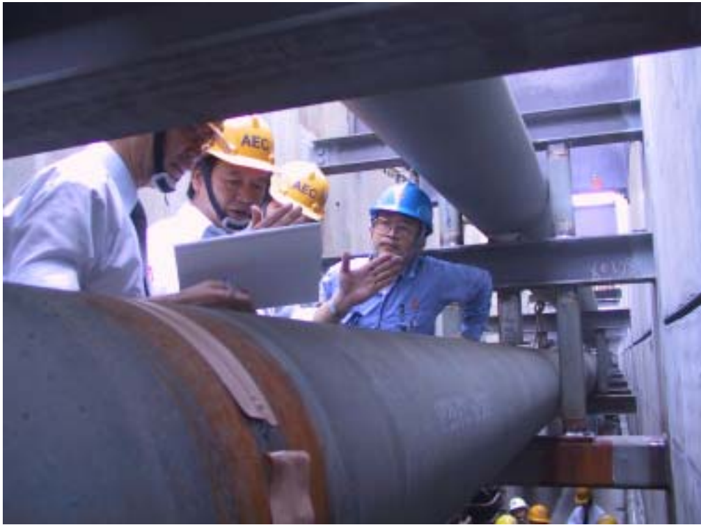
照片五：視察反應器廠房機械設備及管路安裝情形
