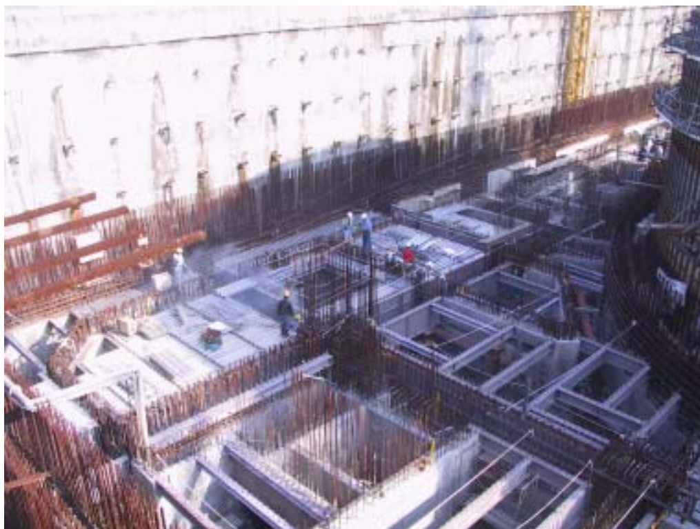
照片二：一號機反應器廠房施工現況
