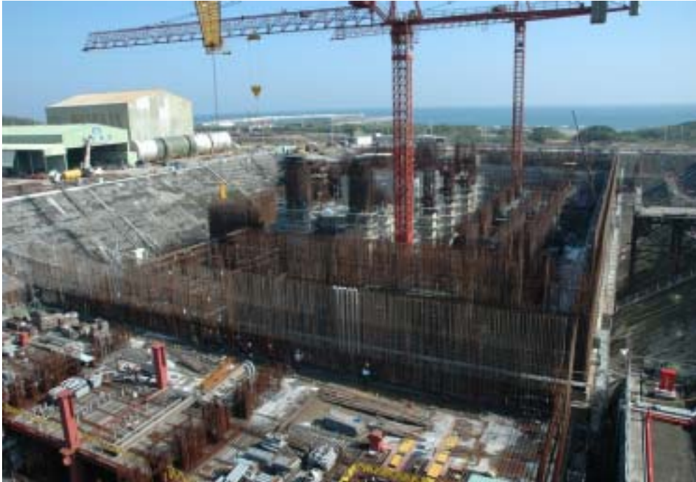
照片九：二號機汽機廠房施工現況
