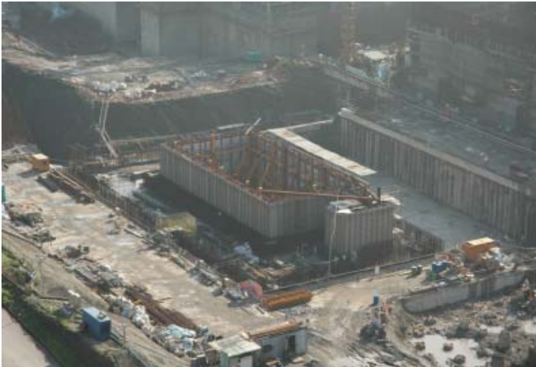
照片五：輔助用過燃料廠房施工現況
