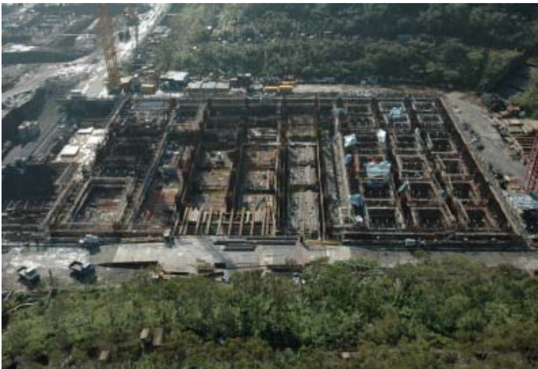
照片六：核廢料廠房施工現況
