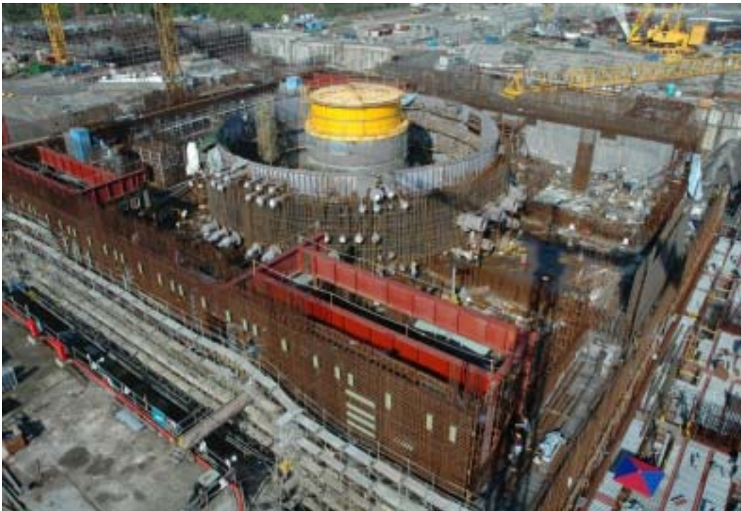
照片二：一號機反應器廠房施工現況
