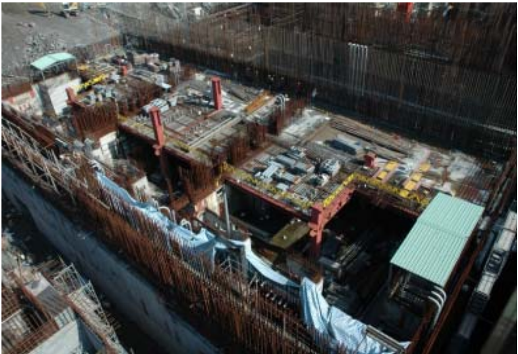
照片八：二號機控制廠房施工現況
