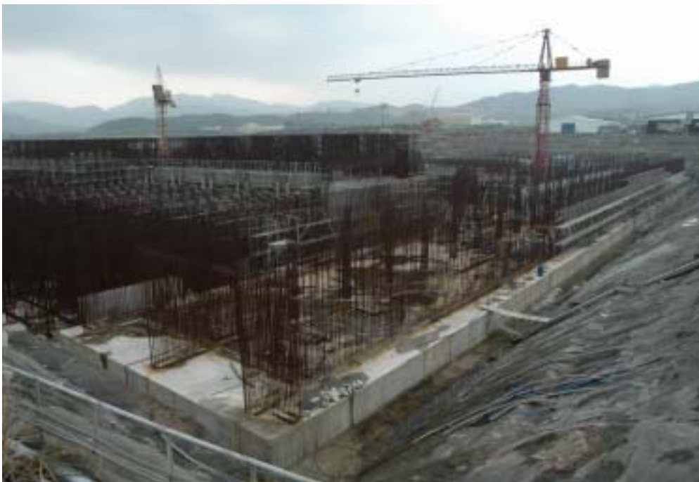
照片十：抽水機房施工現況
