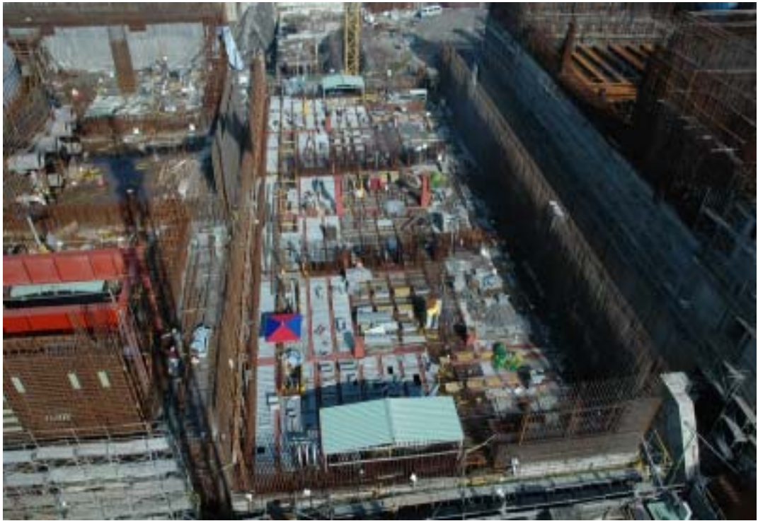
照片三：一號機控制廠房施工現況
