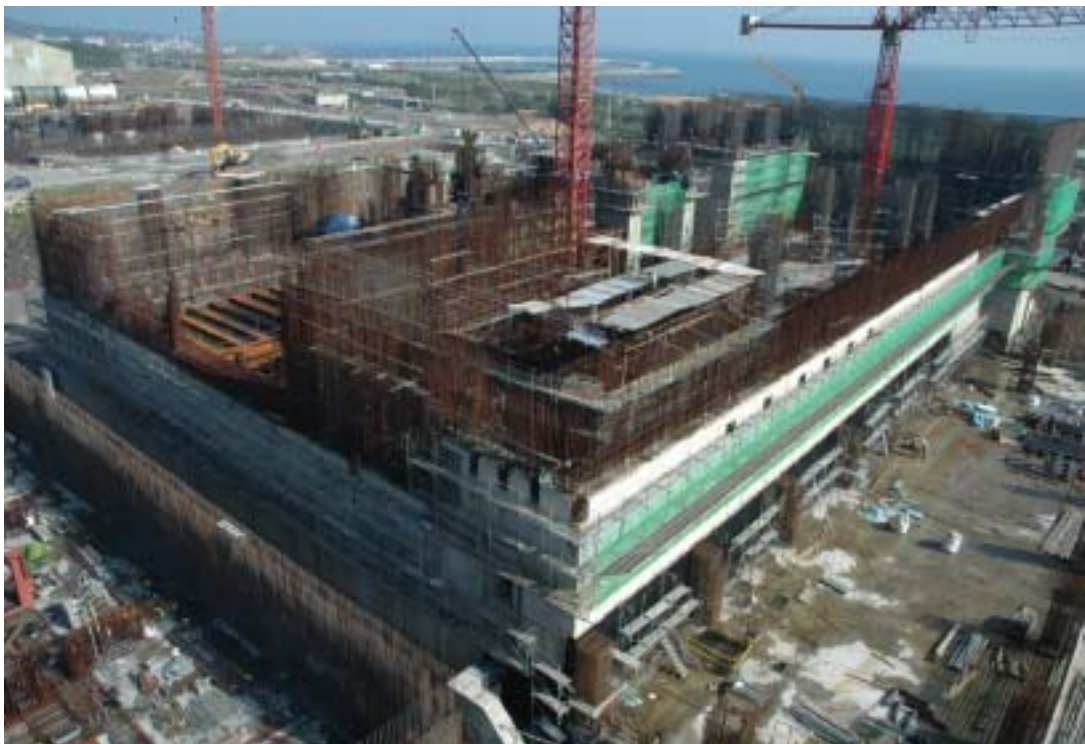
照片四：一號機汽機廠房施工現況
