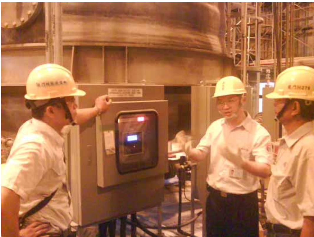
本會視察員於海水電解廠房現場與電廠運轉人員討論設備運轉情形
