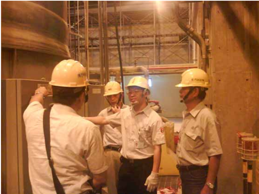
本會視察員於海水電解廠房現場詢問電廠設備電氣設備運轉情形
