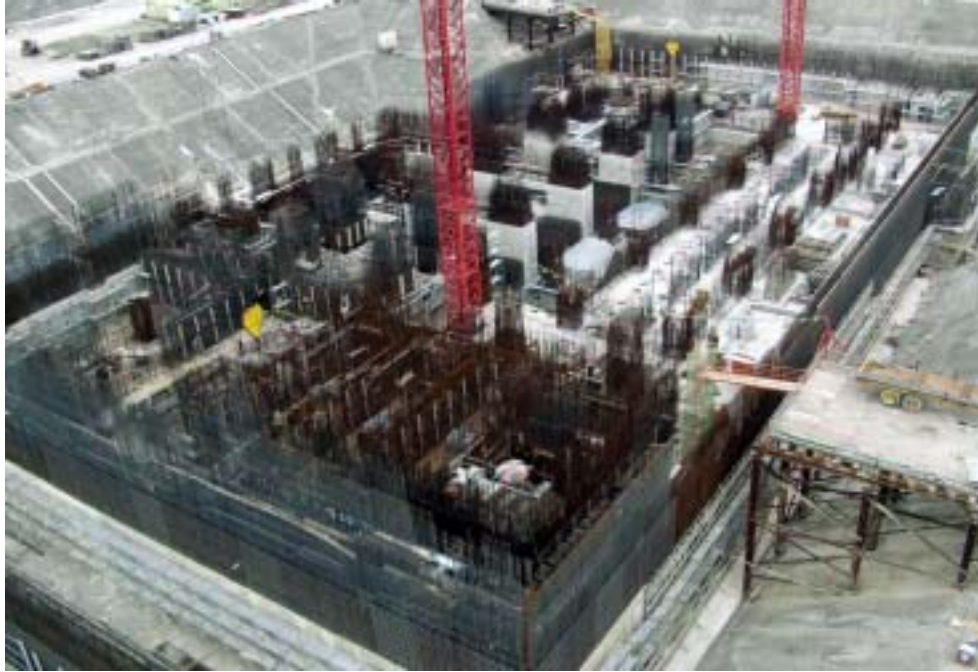
照片三：一號機汽機廠房施工現況
