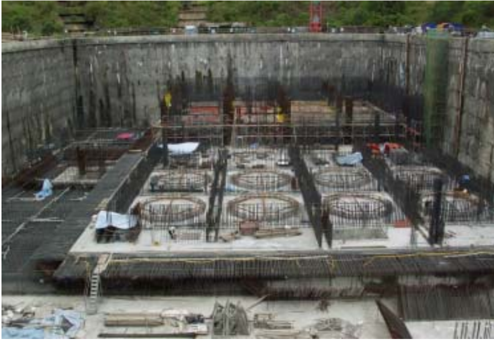
照片五：核廢料廠房施工現況
