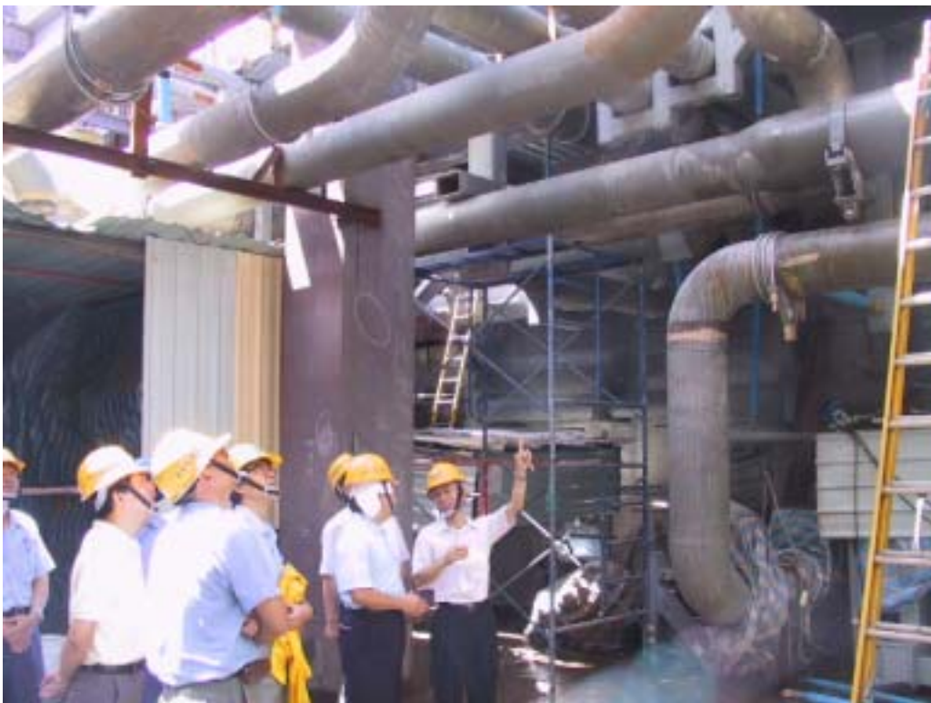
照片六：視察反應器廠房機械設備及管路安裝情形
