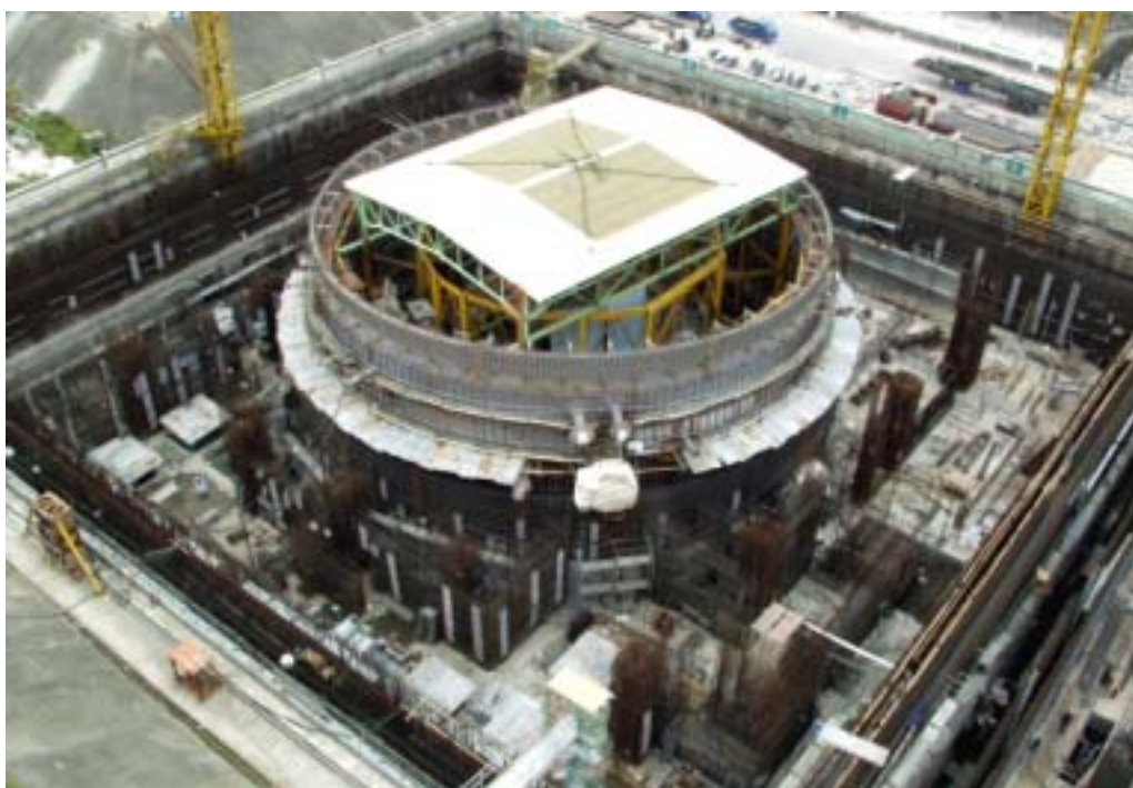
照片二：一號機反應器廠房施工現況
