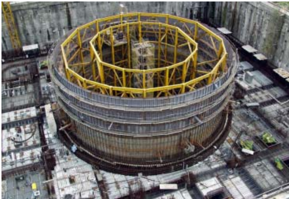
照片四：二號機反應器廠房施工現況
