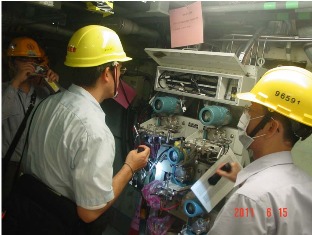
本會視察員於 FPCU 試運轉測試前檢查儀器設定及校正情形
