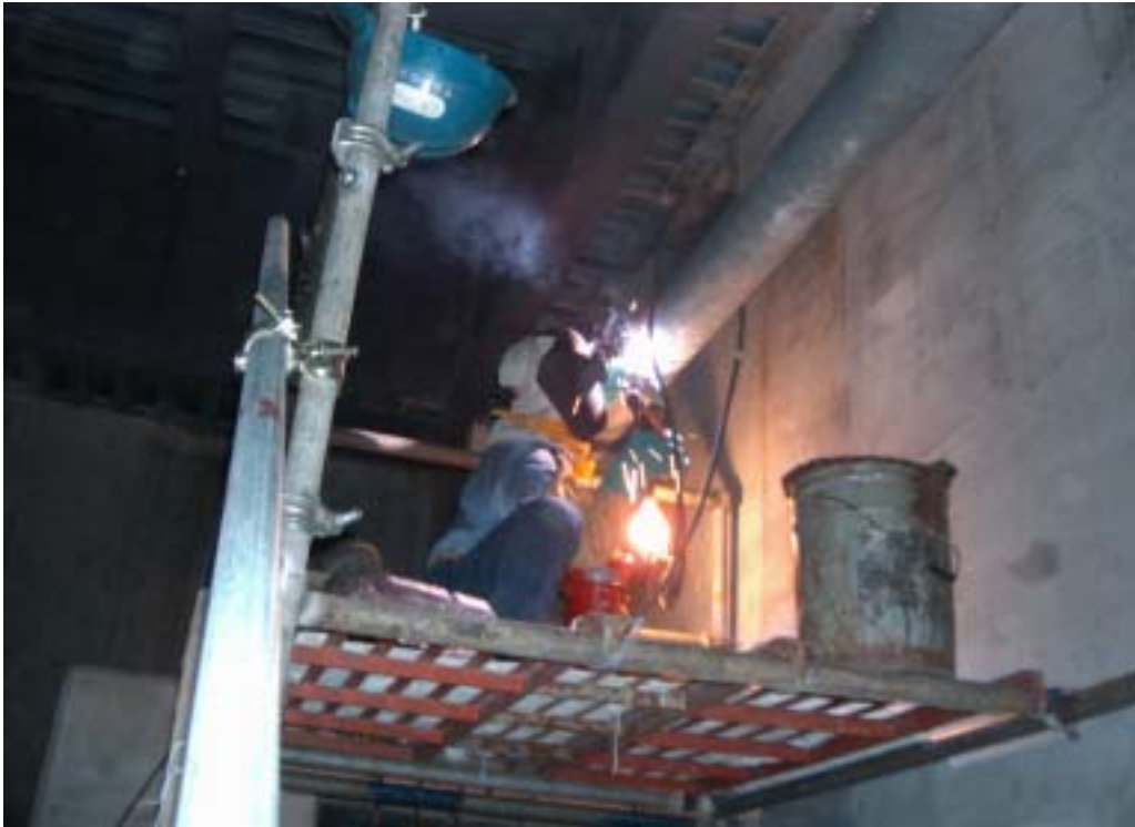
照片七 管路與機械設備安裝施作現況查證
