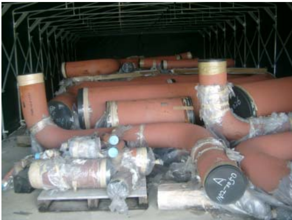
照片八 主蒸汽管節籠式遮雨棚儲存現況查證
