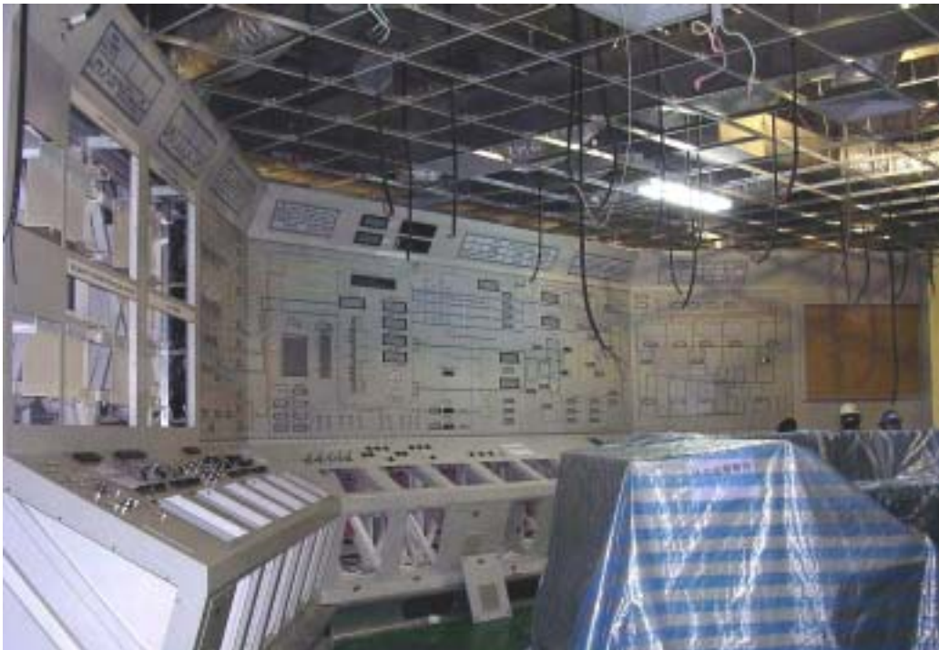
照片四 模擬器安裝工程現況
