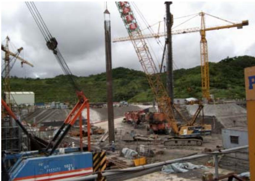
照片六 共同煙囪工程施工現況
