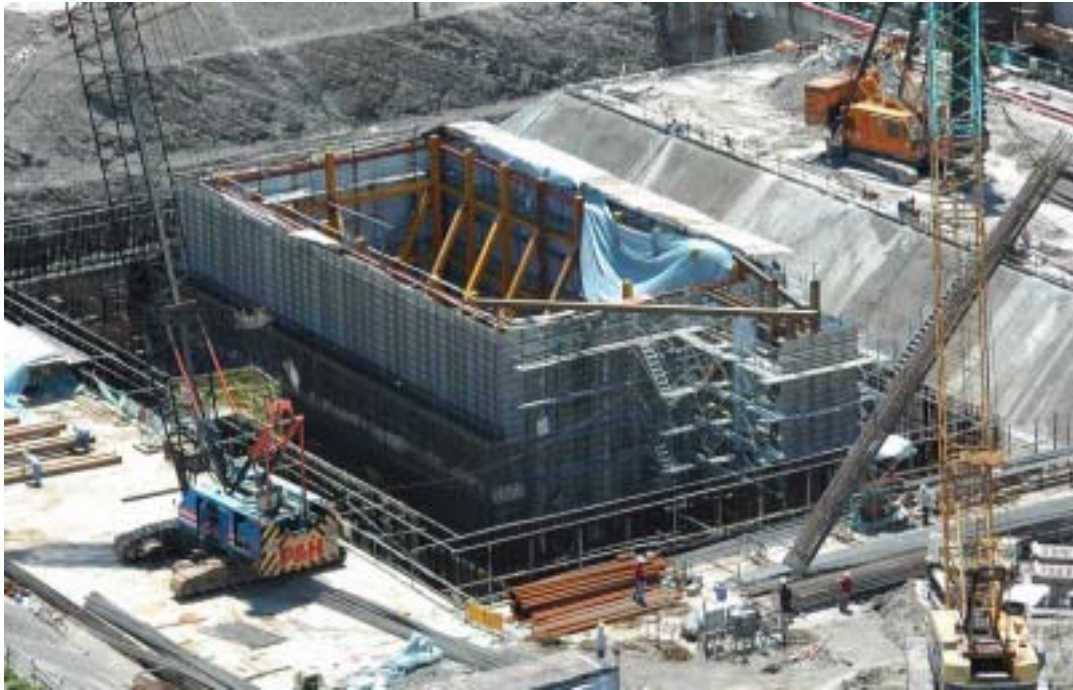
照片十一 輔助用過燃料廠房施工現況圖景
