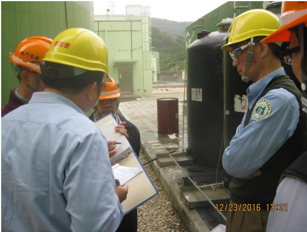
照片 3: SDG 貯油槽室外查證移油作業
