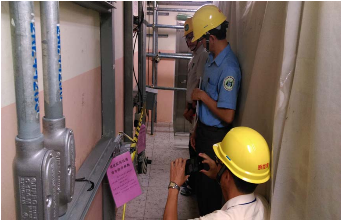
照片 3：2 號機廠房/設備環境條件監控現場作業查證
