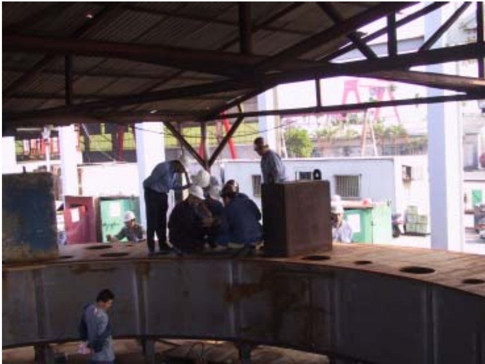
照片九：視察人員現場查證銲接作業管制執行狀況
