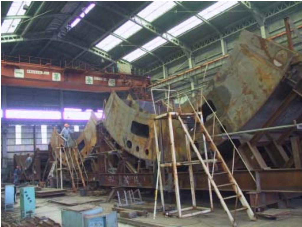
照片六：二號機反應器基座鋼構第一層製造現況
