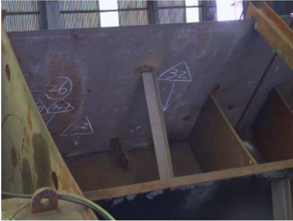
照片七：基座鋼構鐸道使用鐸材現場標示作業執行情形
