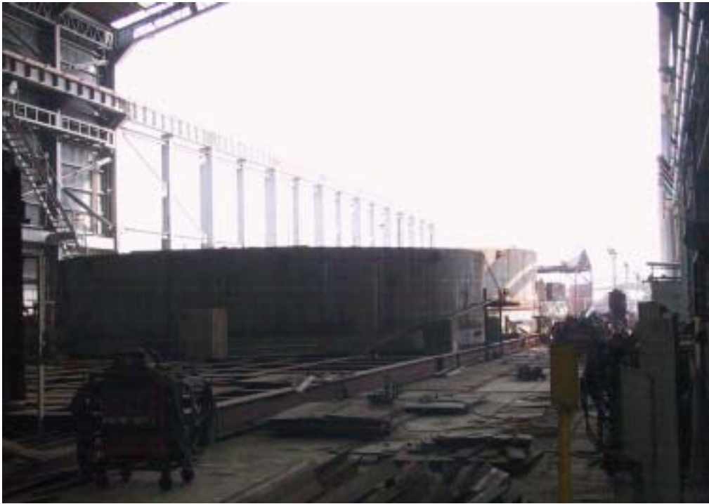
照片五：一號機反應器基座鋼構第二至五層製造現況
