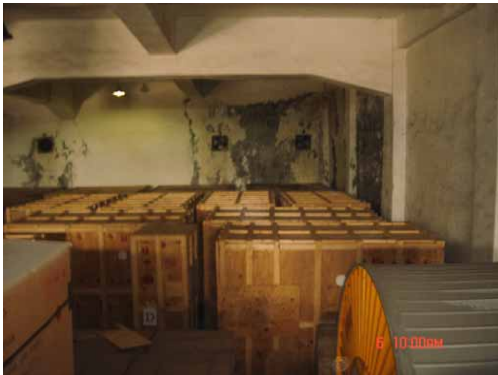
照片十、基隆港光華倉庫設備倉儲情形(二)
