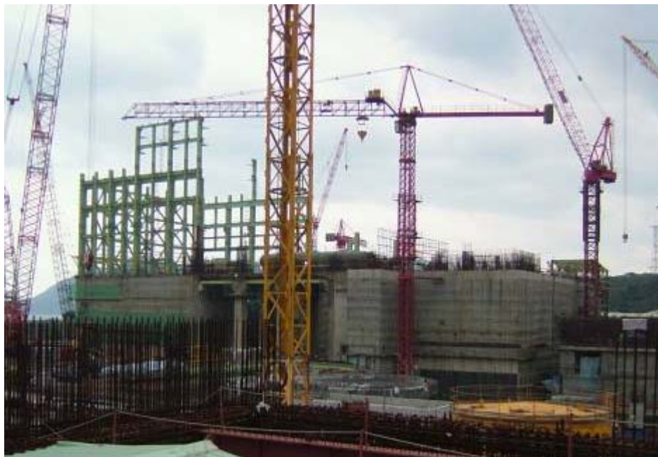
照片四：一號機汽機廠房施工現況
