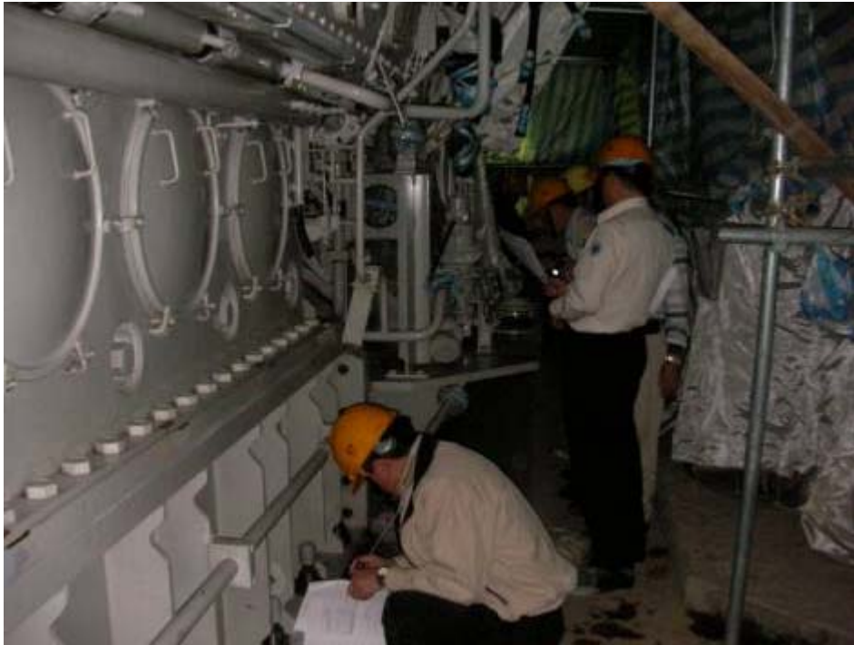
照片五：視察緊急柴油發電機情形
