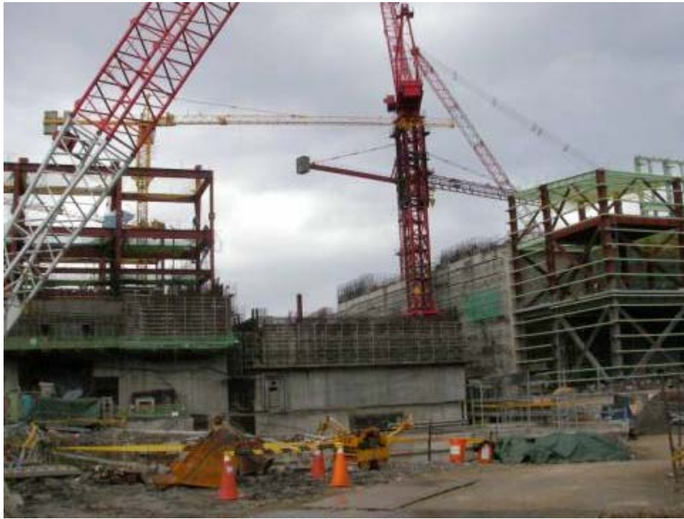
照片三：一號機控制廠房施工現況
