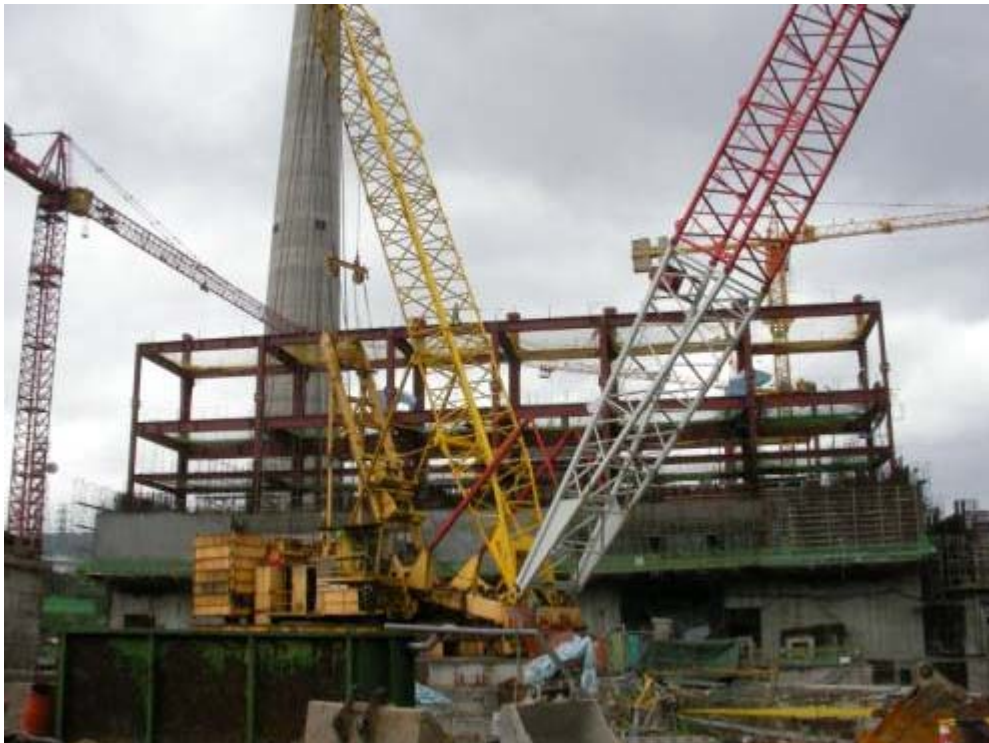
照片二：一號機反應器廠房施工現況
