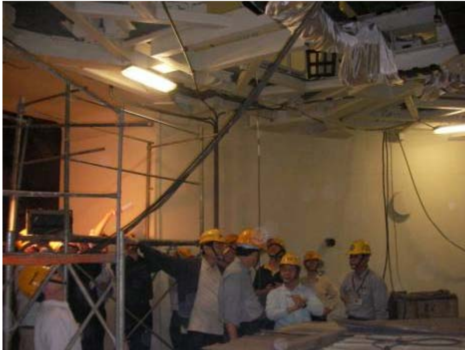
照片九：視察一號機下乾井情形
