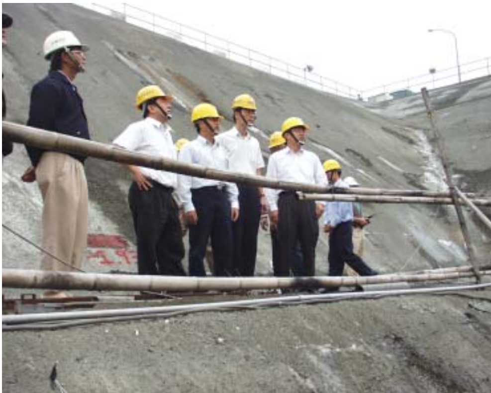
圖六：視察一號機汽機廠房施工情形
