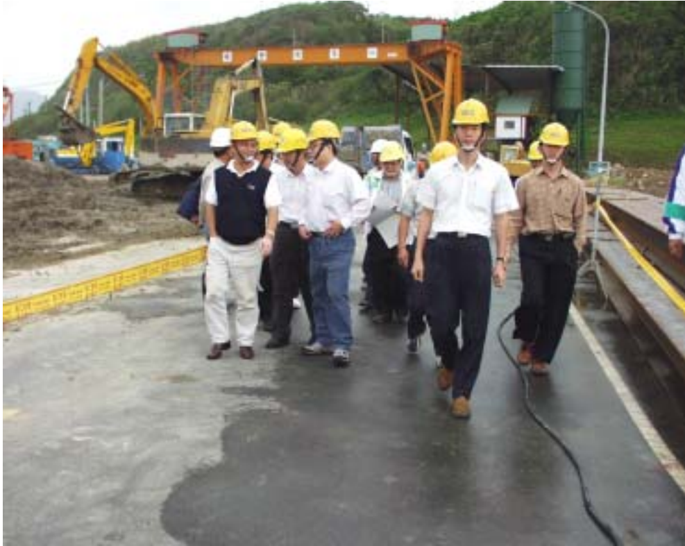
圖七：視察循環冷卻水出水道工程出發井施工情形
