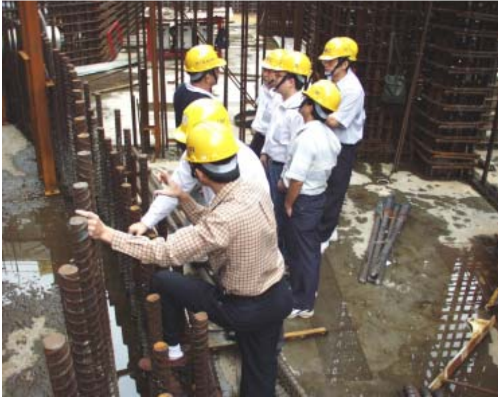
圖三：視察反應器廠房鋼筋及埋件施工狀況
