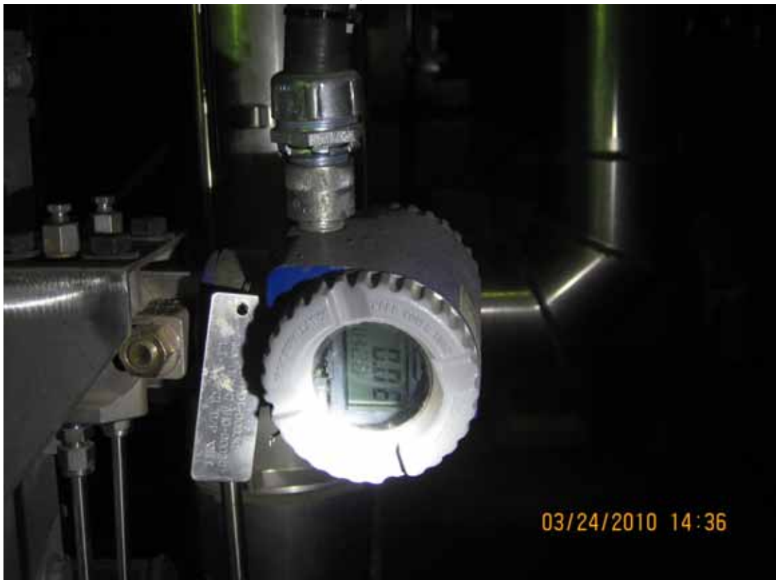
照片八 安裝位置不當致使安裝後之傳送器不易讀取顯示幕數值
