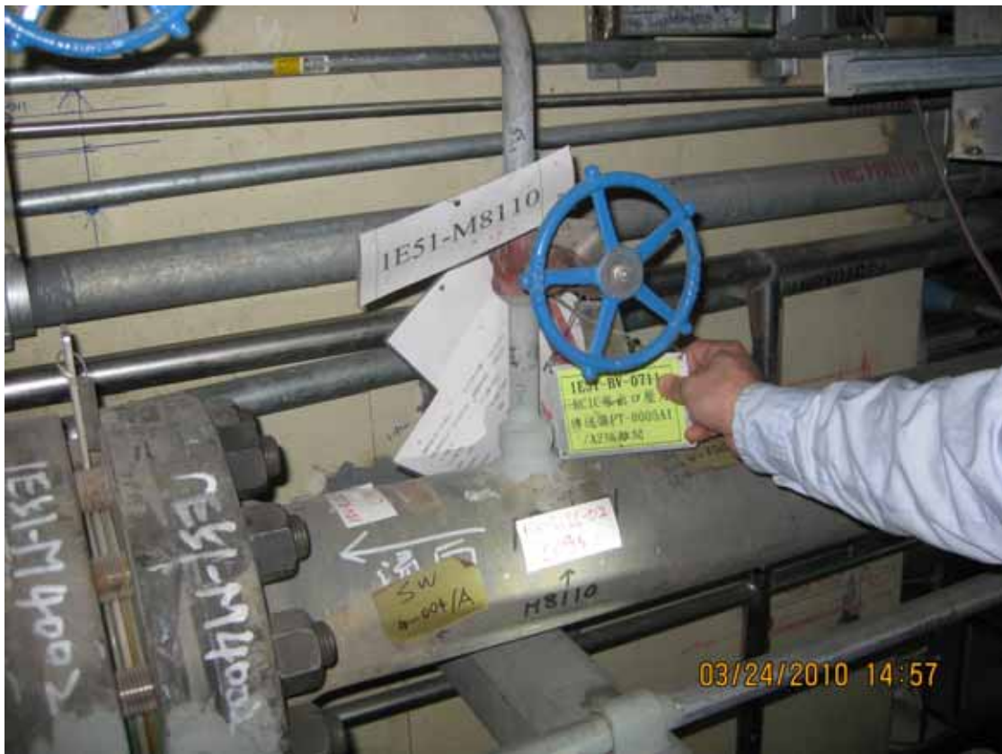
照片三 液體管路 tapping point 朝上
