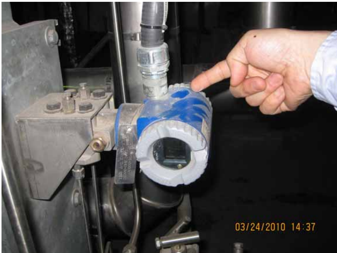
照片七 傳送器灰塵沾染
