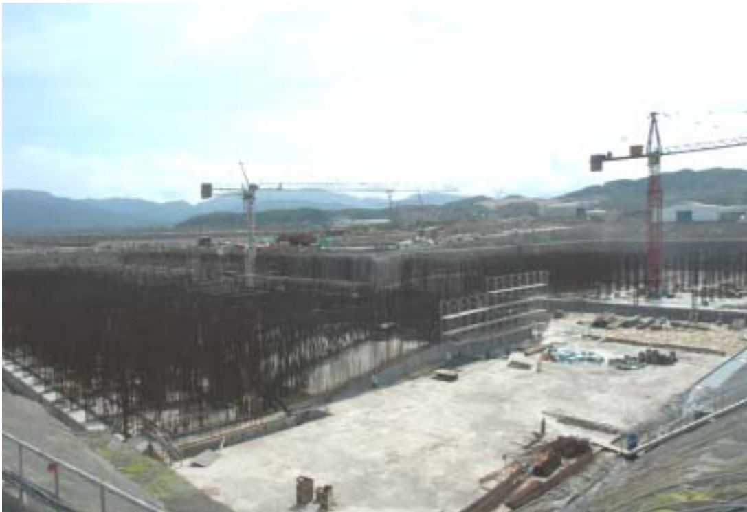
照片八：抽水機房施工現況
