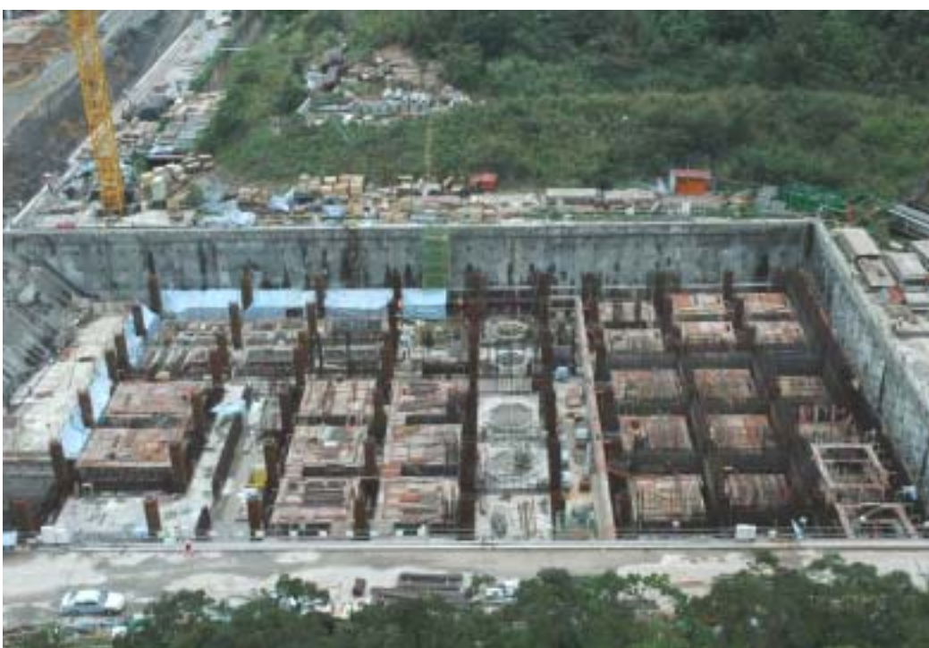
照片六：核廢料廠房施工現況
