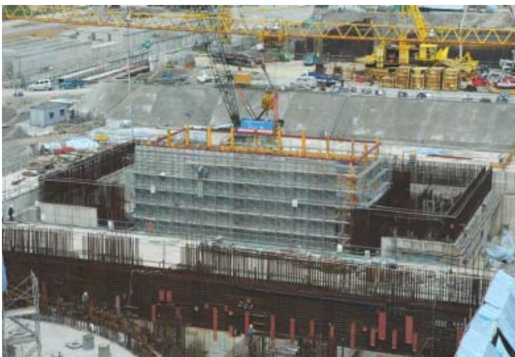
照片五：輔助用過燃料廠房施工現況
