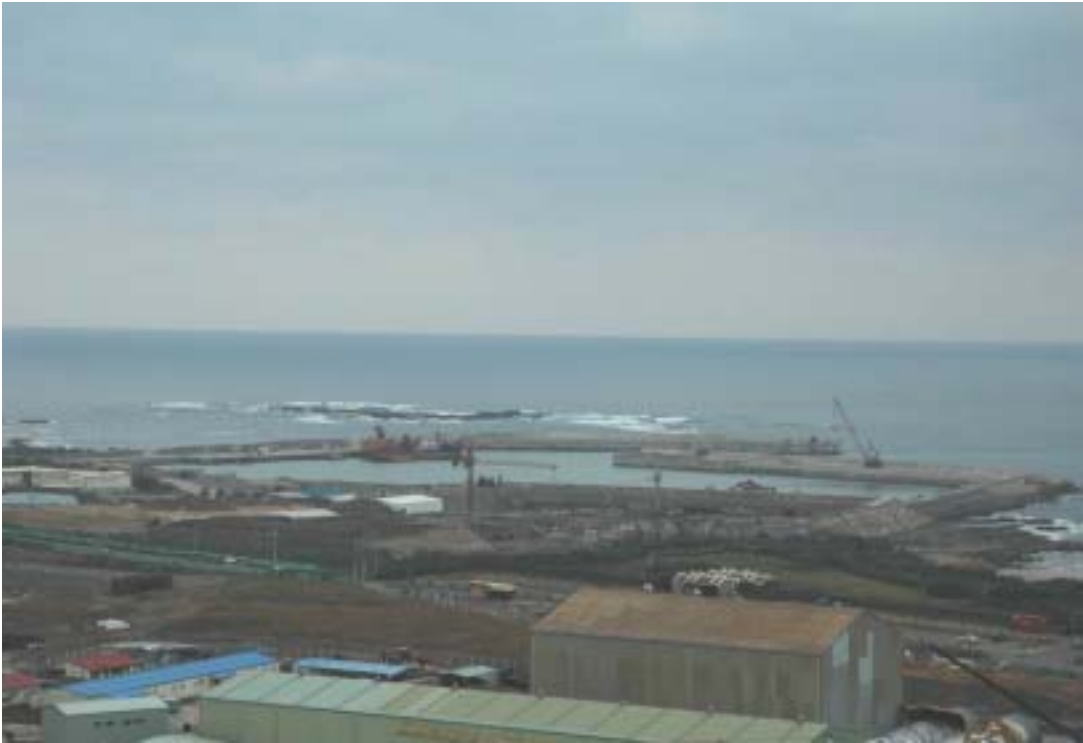
照片七：南北防波堤及重件碼頭施工現況
