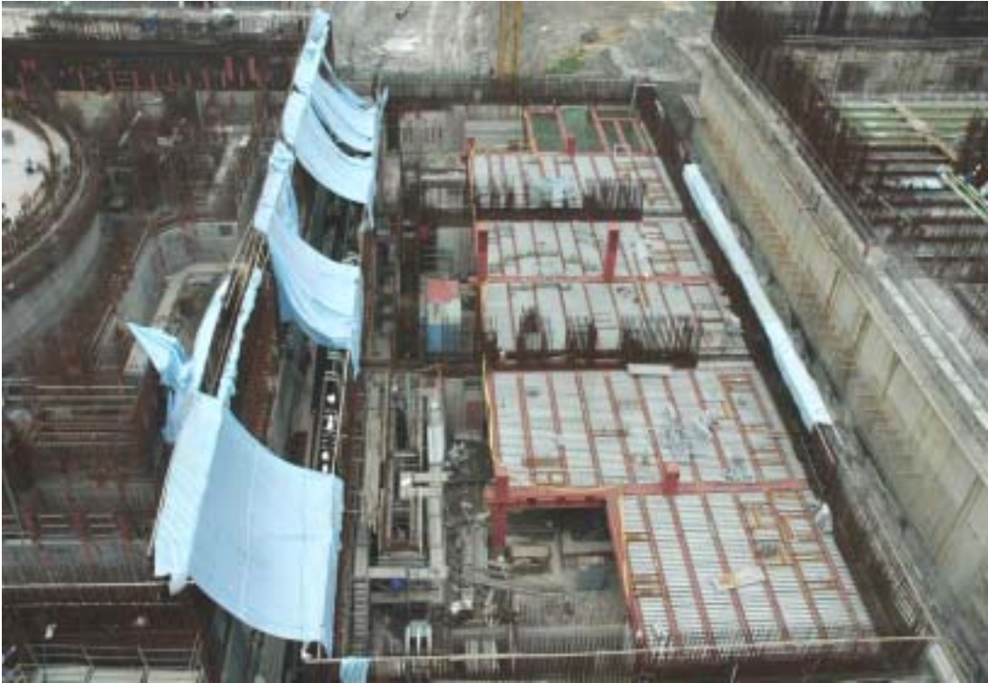
照片三：一號機控制廠房施工現況
