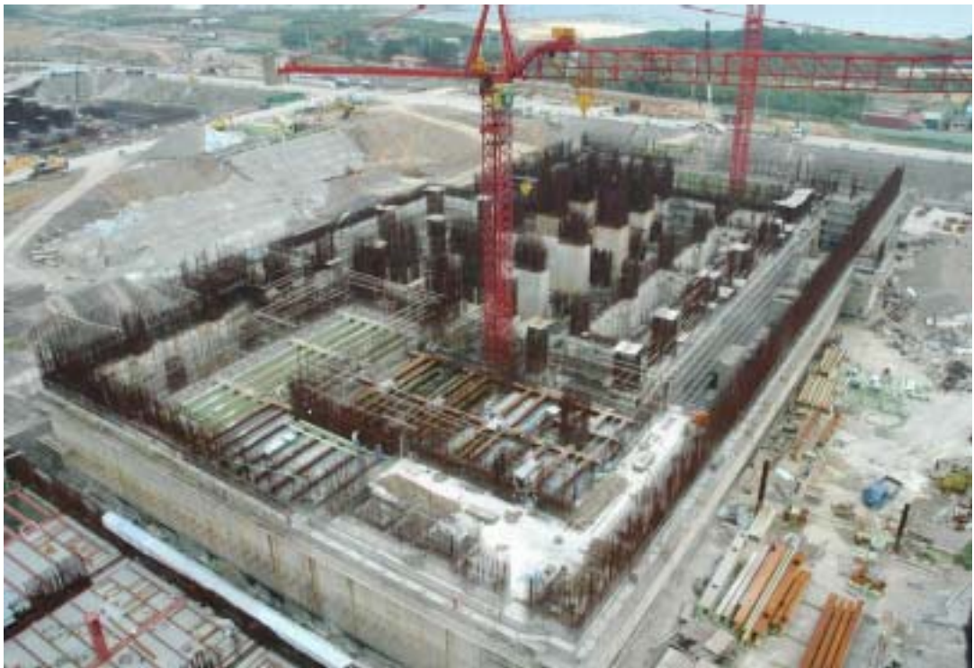
照片四：一號機汽機廠房施工現況
