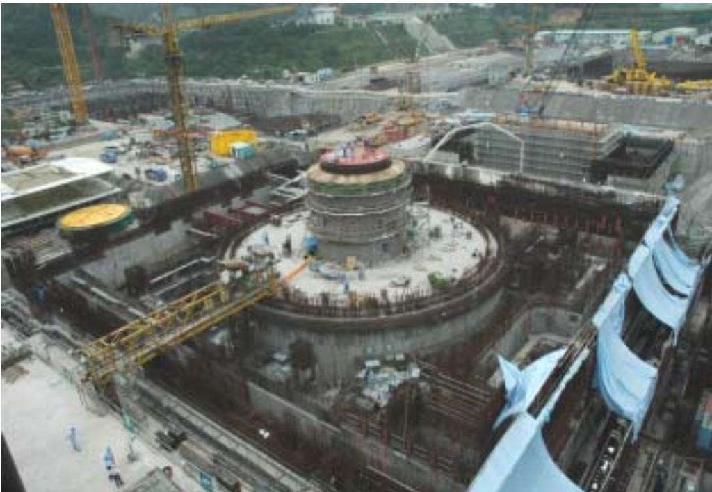
照片二：一號機反應器廠房施工現況
