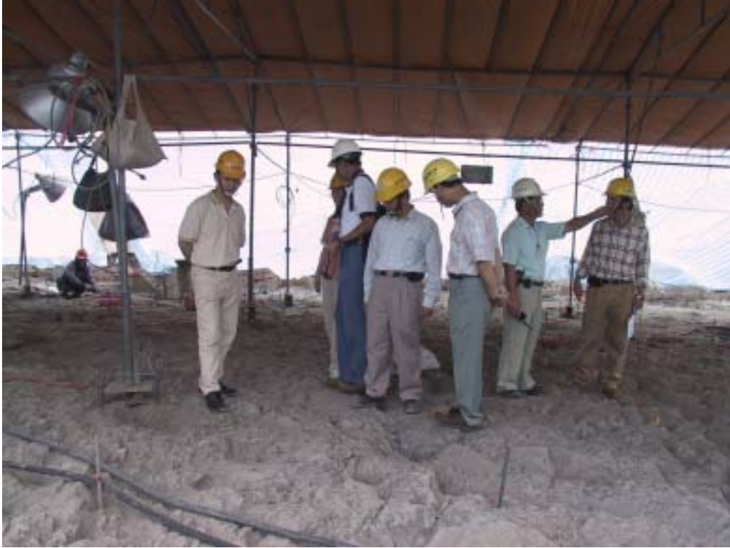
照片九：視察二號機汽機廠房地質測繪情形
