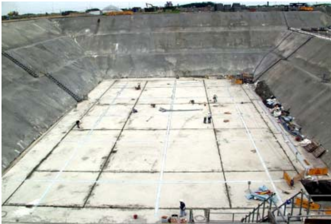
照片四：輔助用過燃料廠房工程施工現況
