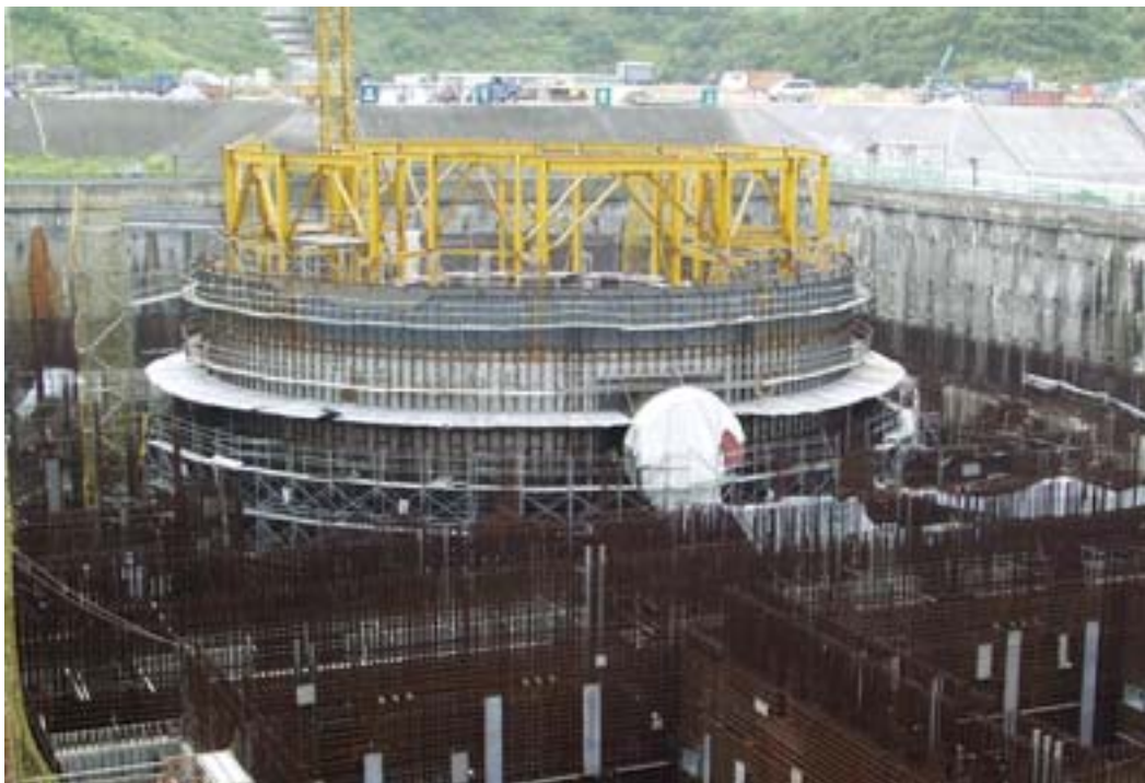
照片二：一號機核島區施工現況
