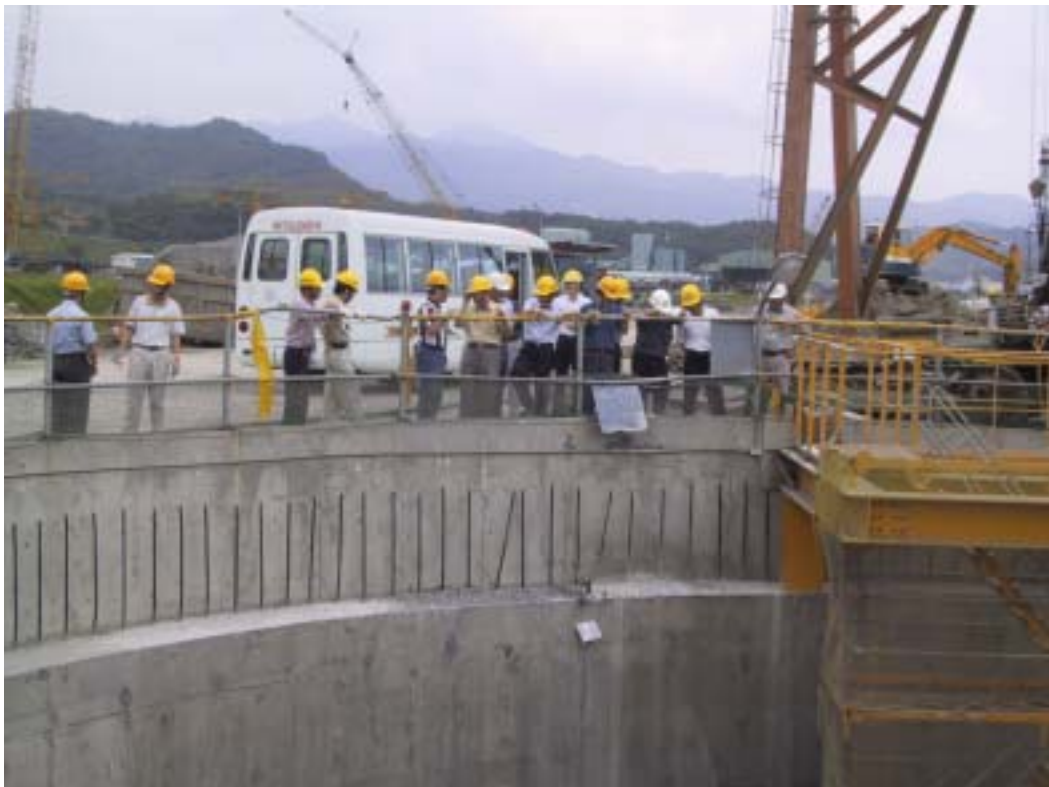
照片八：視察循環冷卻水出水道工程一號出發井施工情形
