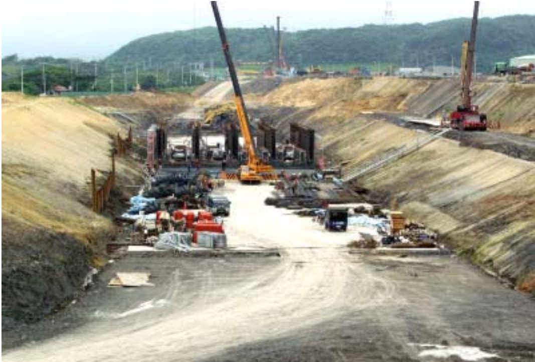
照片七：進水暗渠施工情形
