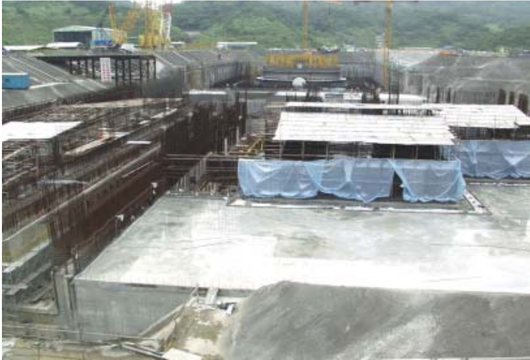
照片三：一號機汽機島區施工現況
