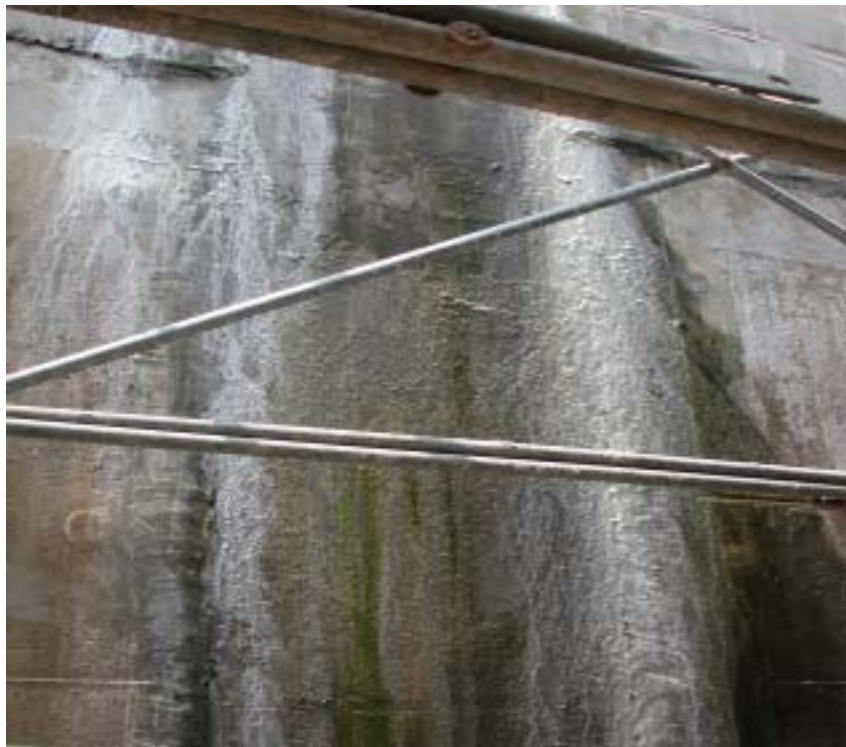
照片十：一號機反應器廠房外牆乳白色滲析結晶及滲水情形
