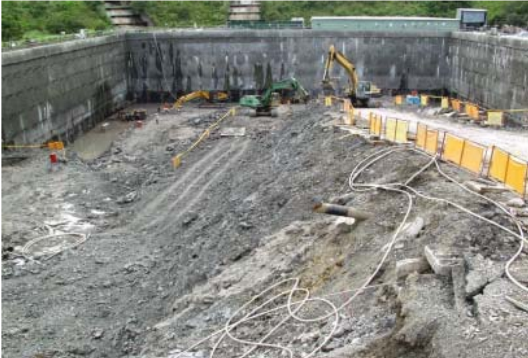
照片五：核廢料廠房工程施工現況
