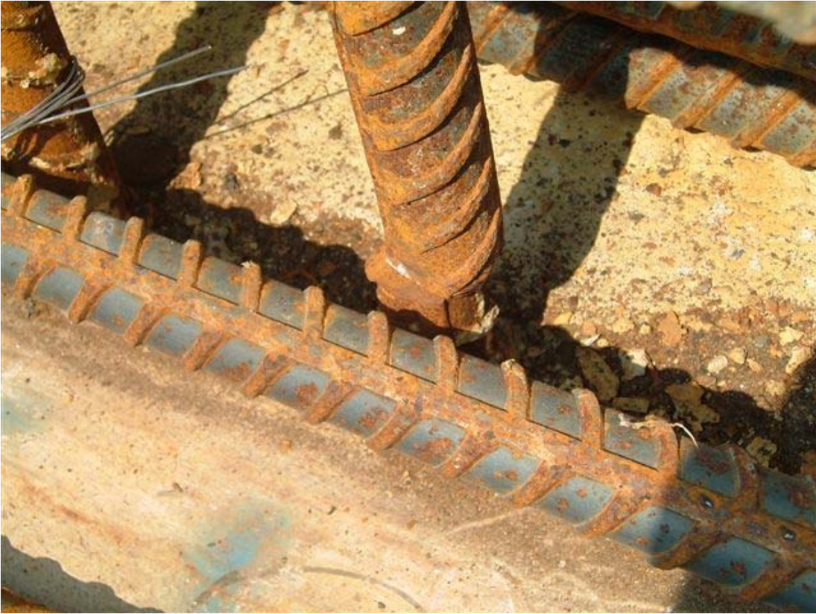
圖十一：鋼筋直接對接處理
