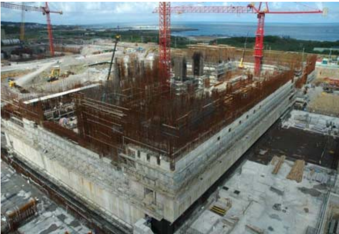
圖二：一號機汽機廠房施工現況
