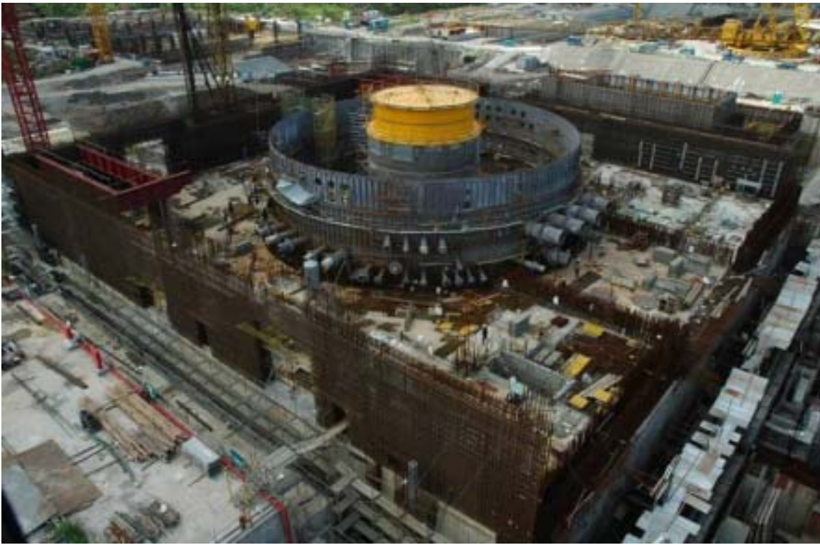
圖一：一號機反應器廠房施工現況
