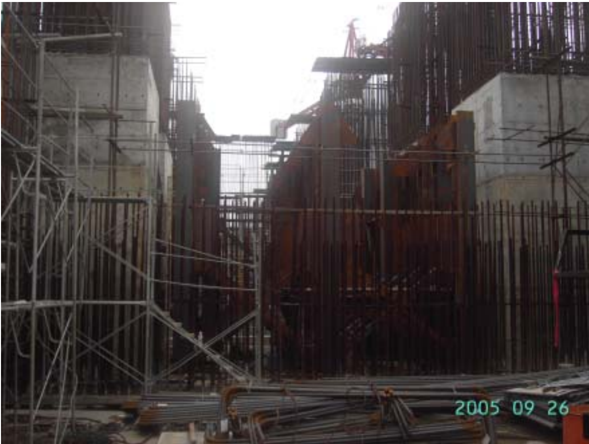
圖三：一號機汽機廠房汽機台柱施工現況
