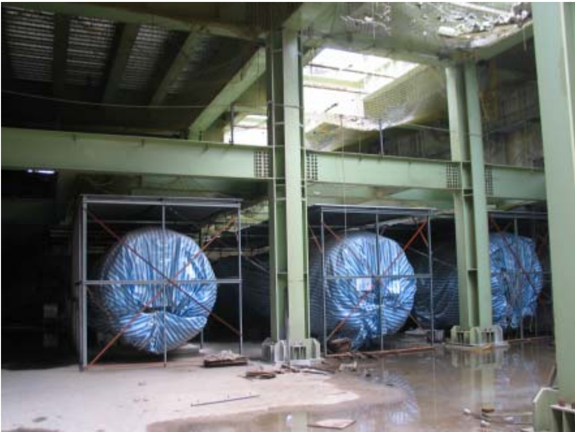
圖五：一號機汽機廠房使用 A307 錨定螺栓之七根鋼柱位置現況
