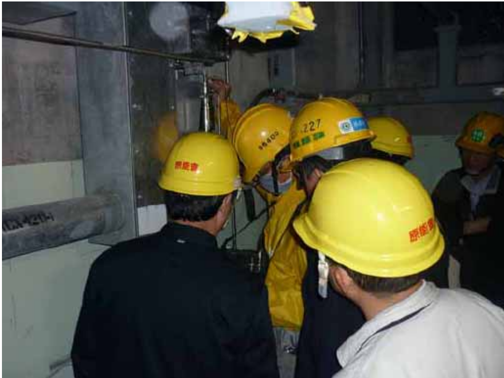
照片 6：現場以超音波量測 SMP 螺栓長度情形
