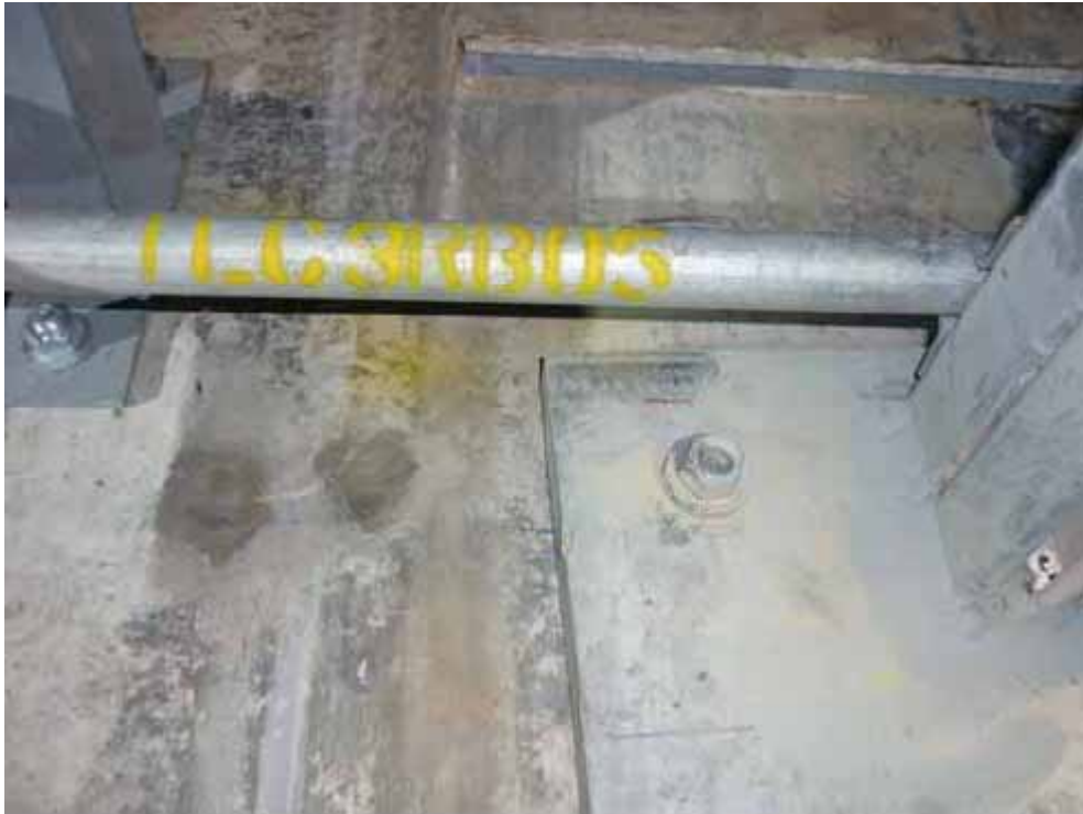
照片 11：SMP 螺栓低於螺帽端面情形
