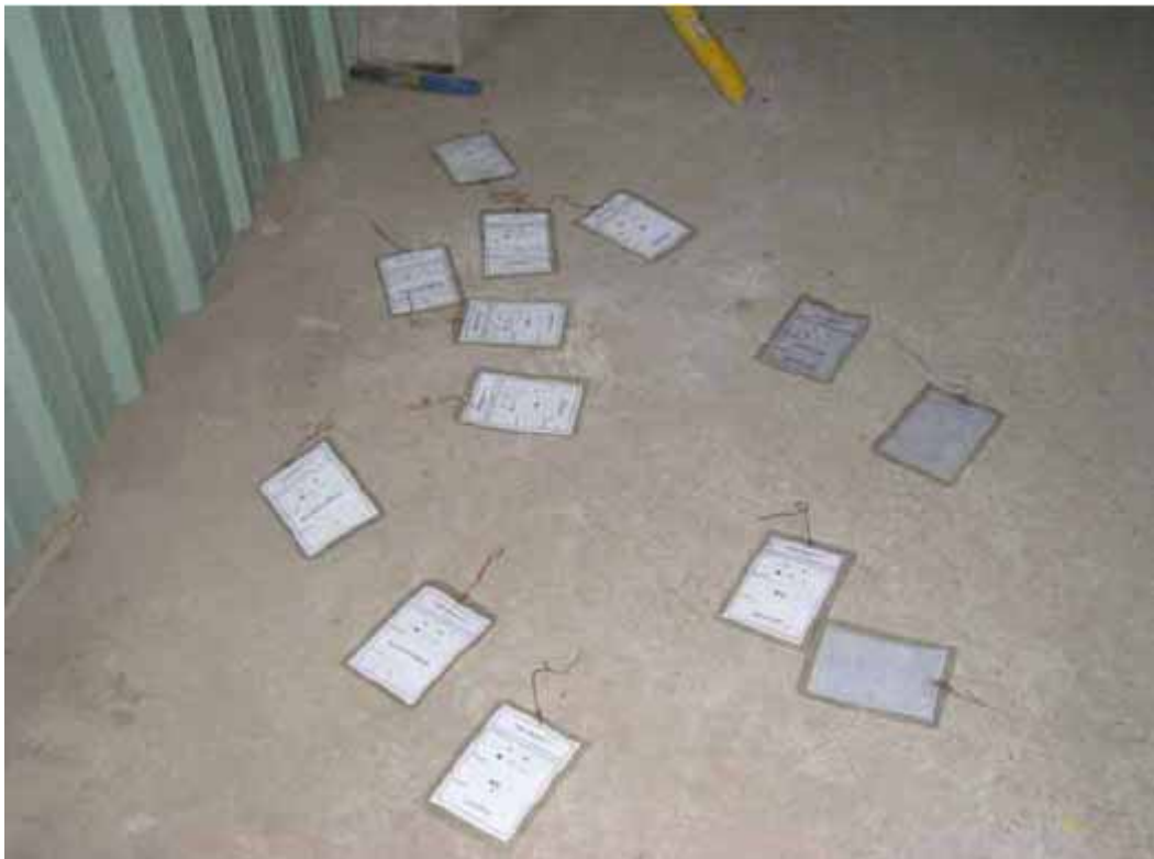
照片 4：安全級承包商儲存區域內標識散落地面
