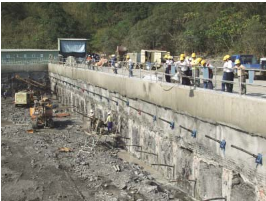
照片八：視察核廢料廠房預力地錨施工情形(二)
