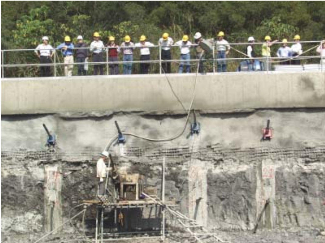
照片七：視察核廢料廠房預力地錨施工情形(一)
