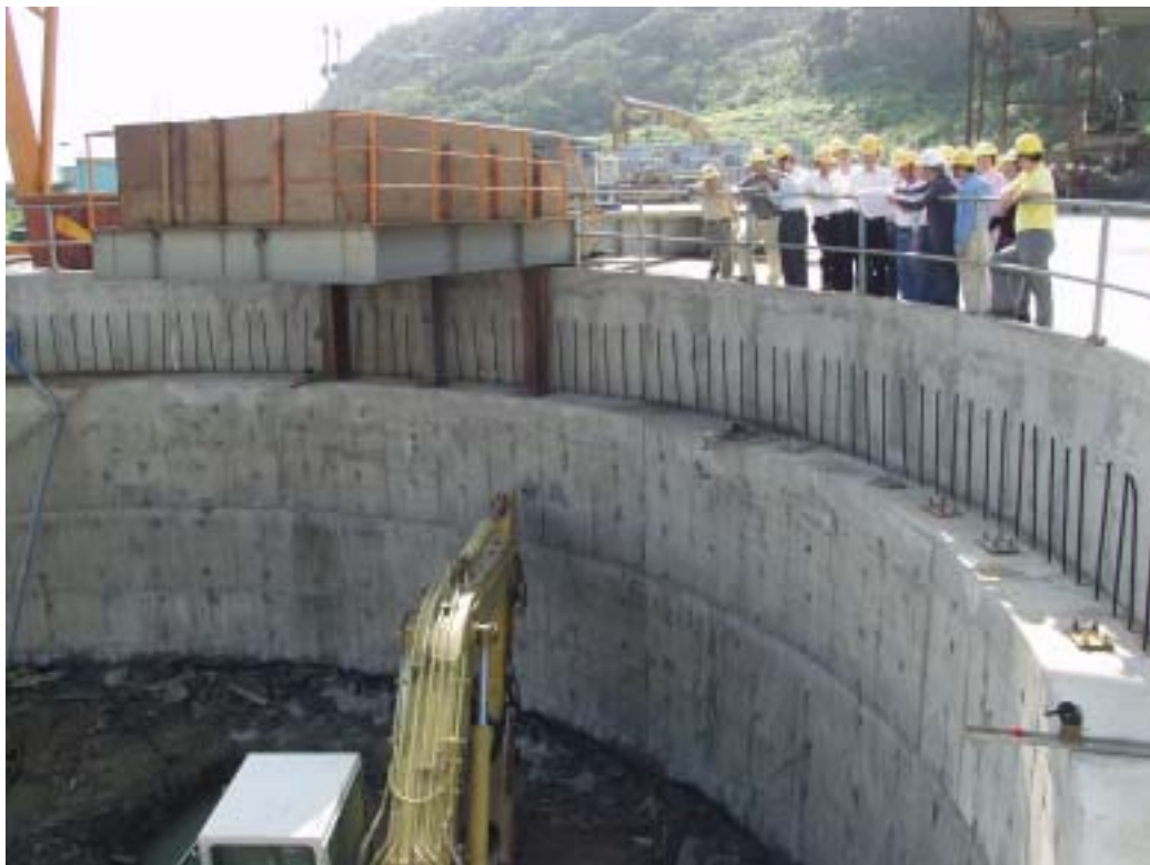
照片六：視察循環冷卻水出水道工程一號出發井施工情形
