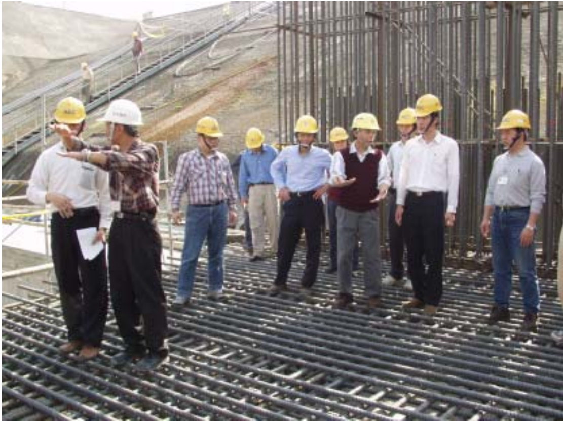
照片九：視察汽機廠房鋼筋綁紮情形
