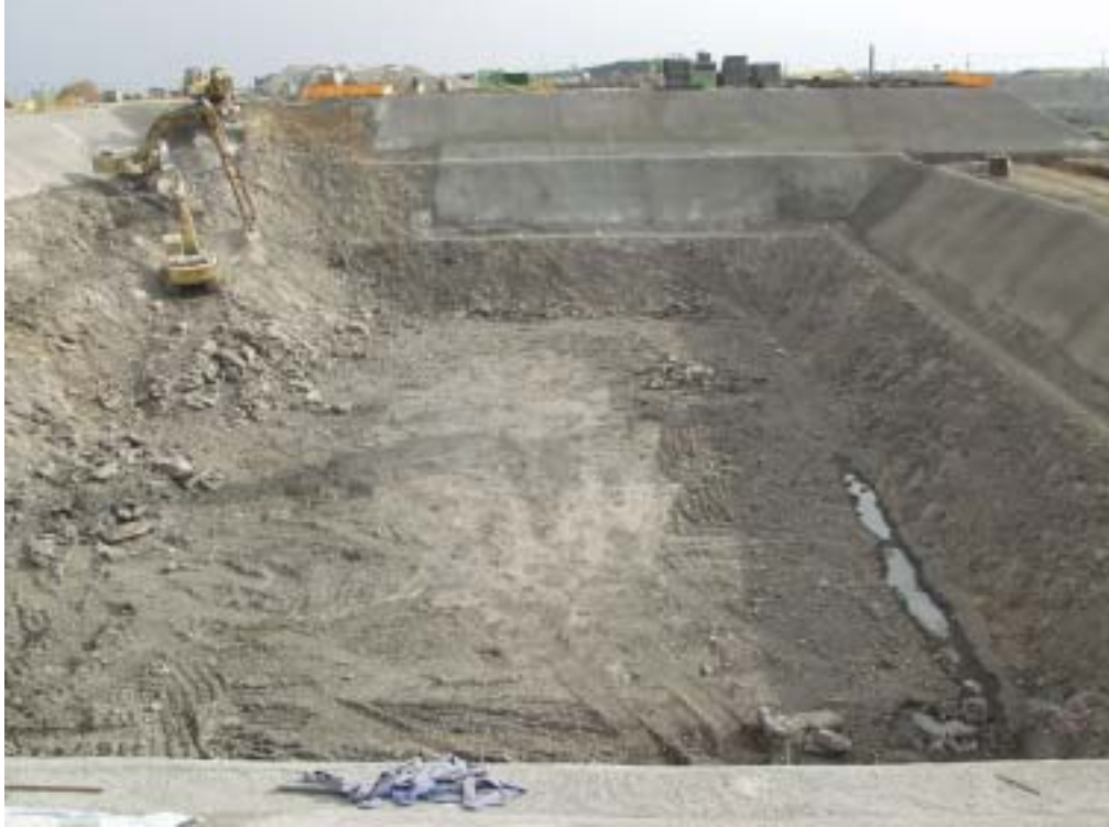
照片三：輔助用過燃料廠房工程開挖施工情形
