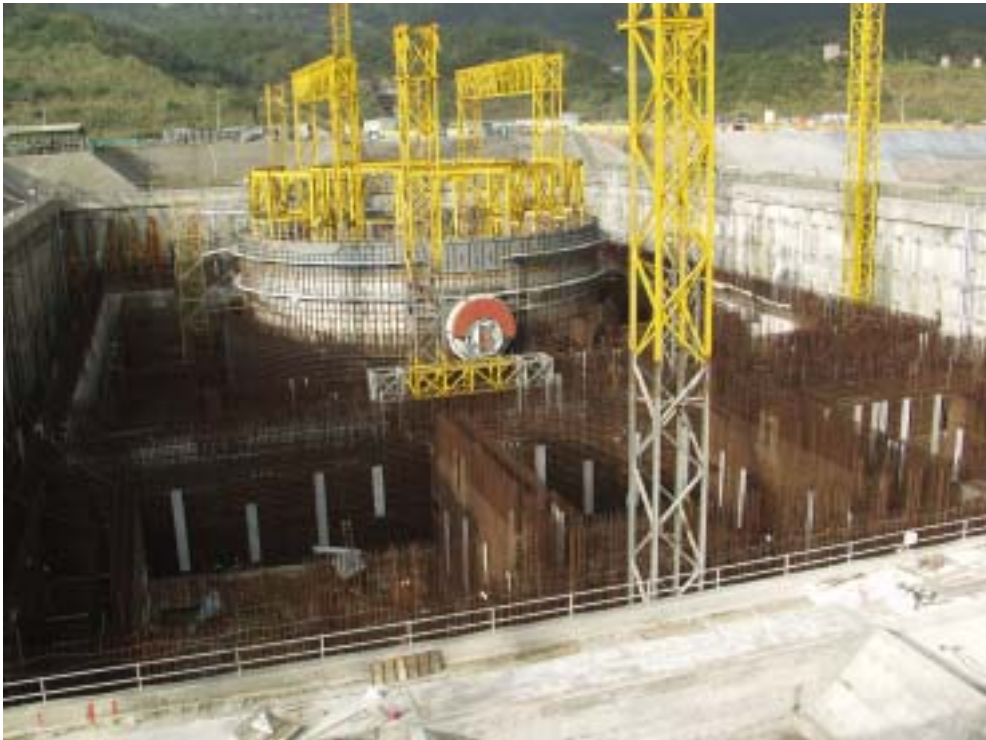
照片二：核島區施工情形
