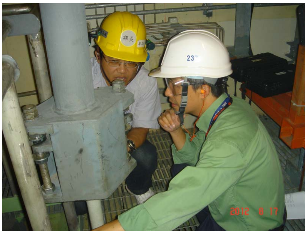
NRC 專家與電廠測試人員討論管路支撐系統
