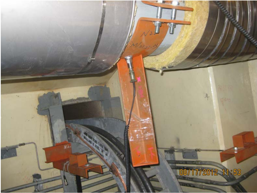
管路振動測量偵測器安裝情形
