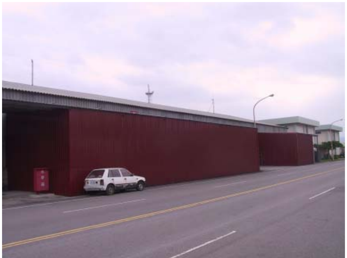
圖二：中三倉庫旁加蓋臨時鐵皮屋儲存 C 級設備現況
