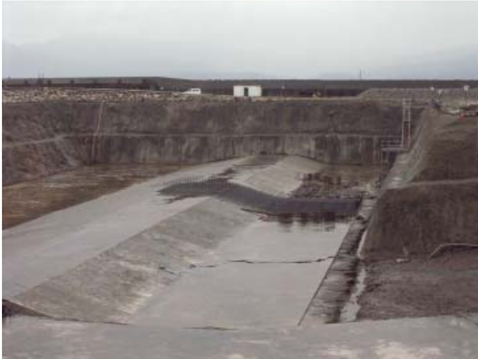
照片五：循環冷卻水抽水機廠房施工現況
