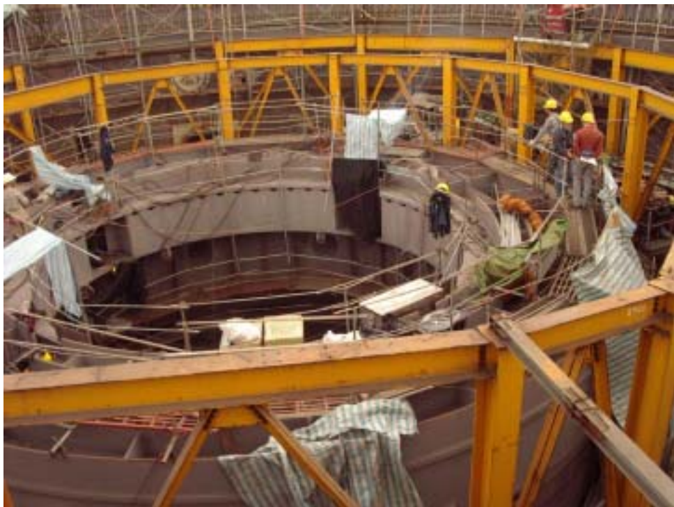
照片四：一號機反應器基座施工現況
