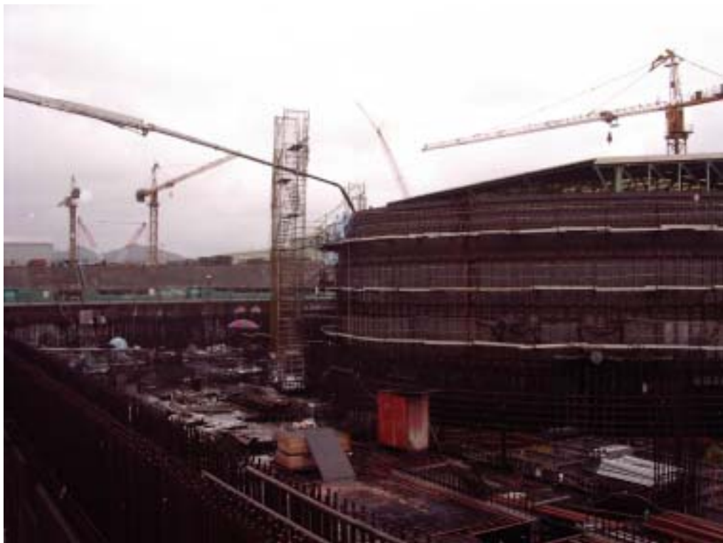
照片二：一號機反應器廠房施工現況
