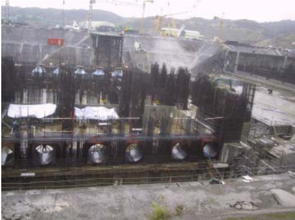
照片三：一號機汽機廠房施工現況
