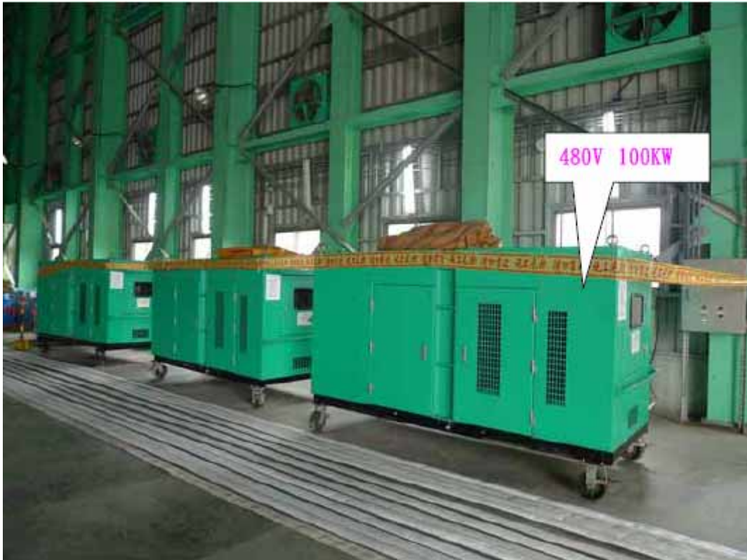
圖三 龍門電廠已購置放於消防隊部之移動式發電機
