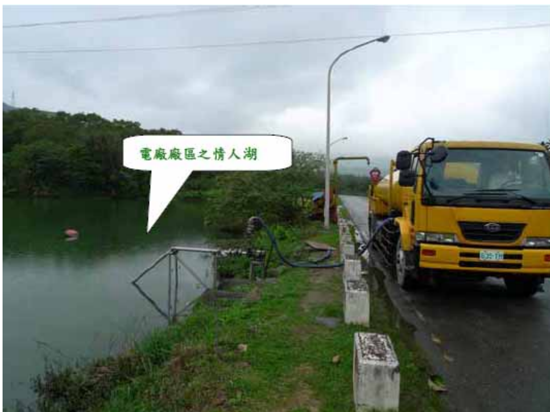
圖二 機組斷然處置消防水車自廠區情人湖取水注入反應爐
