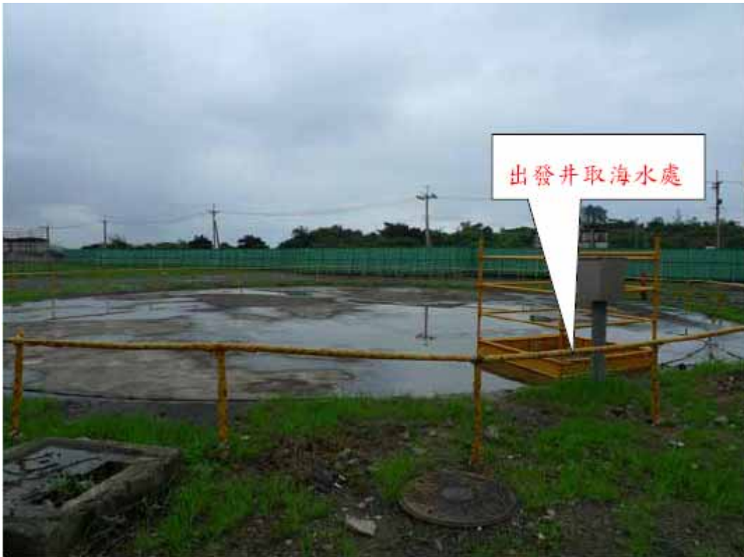
圖五 斷然處置措施引海水注入反應器之取水處（出發井）
