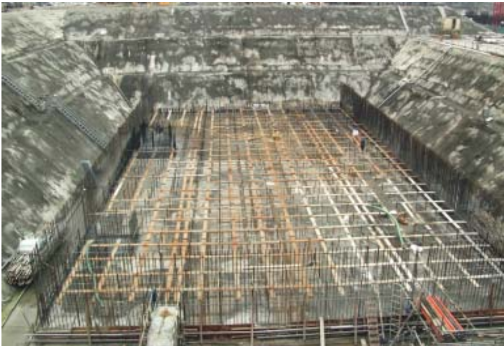
照片四：輔助用過燃料廠房施工現況
