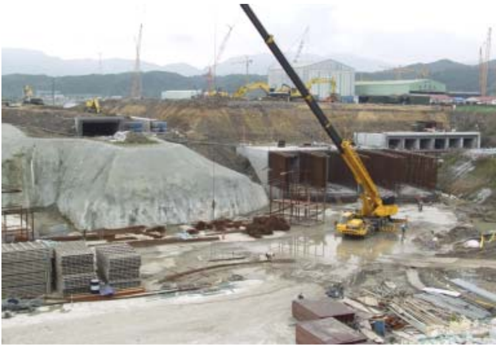
照片五：進水暗渠施工現況
