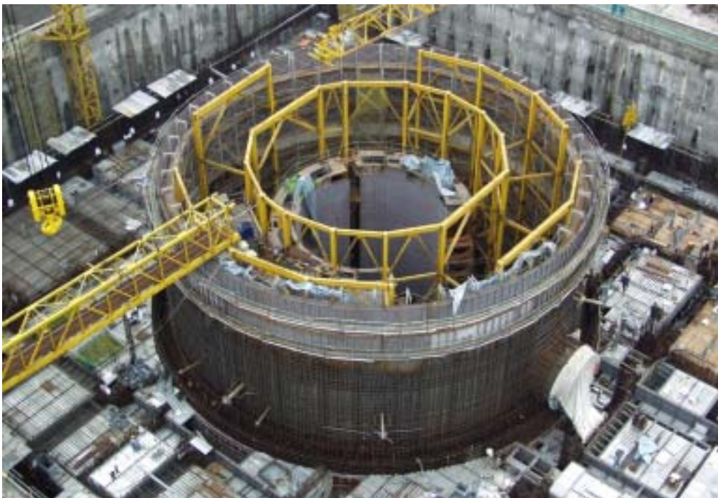
照片二：一號機反應器廠房施工現況
