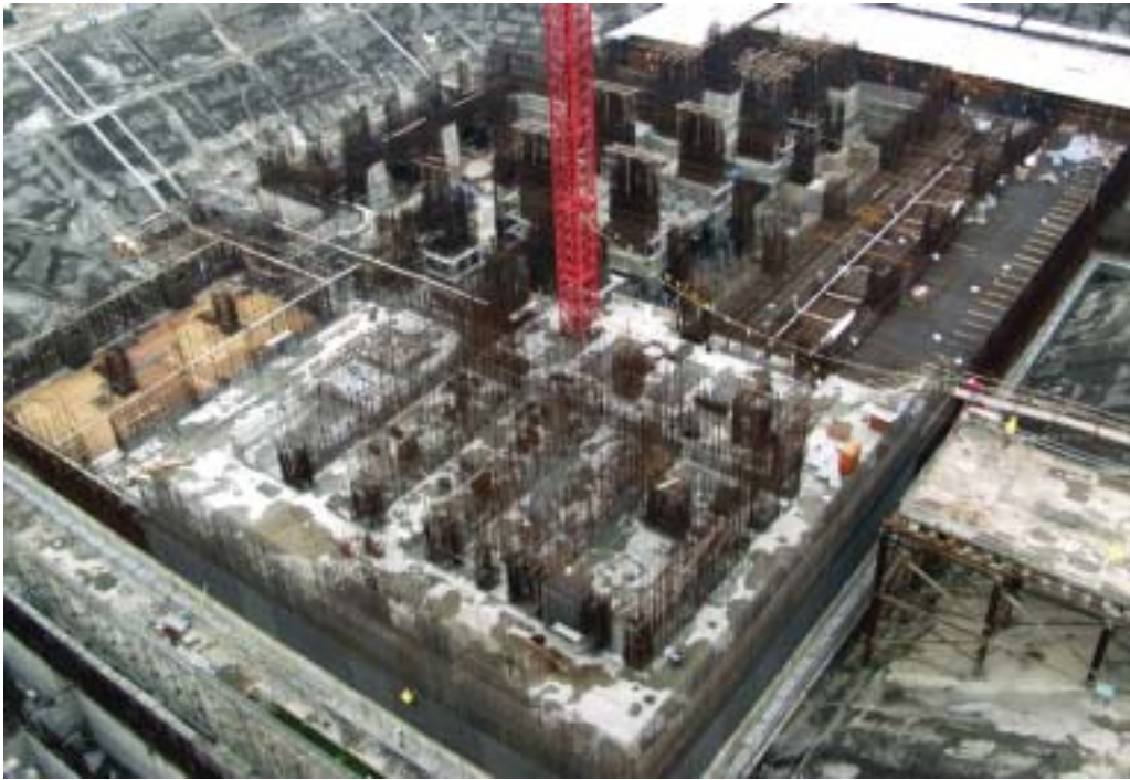
照片三：一號機汽機廠房施工現況
