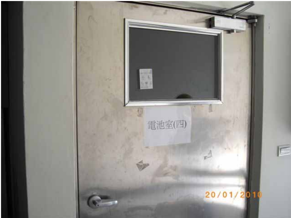
照片 5 開關場電池室防火門現況
