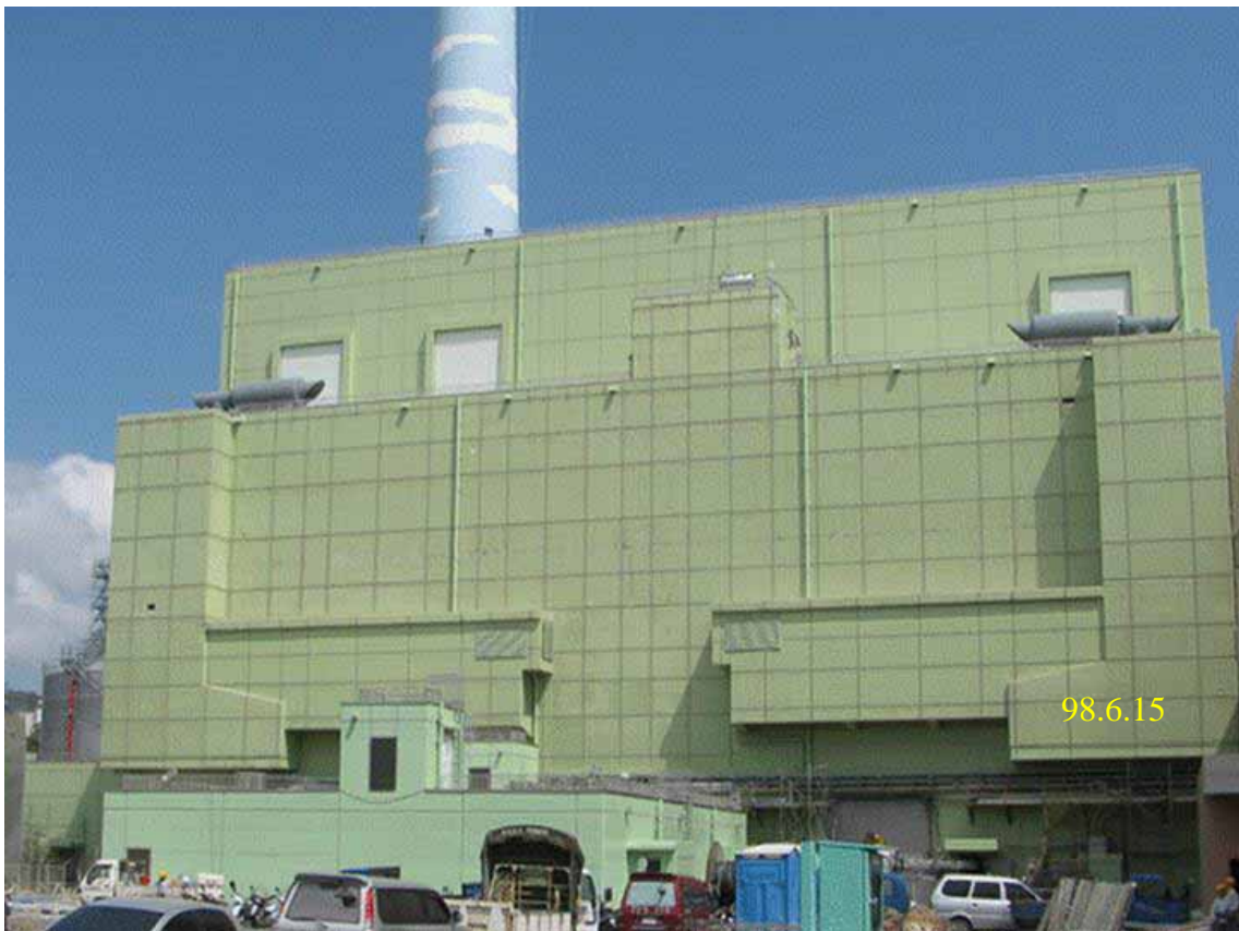
照片三：二號機反應器廠房施工現況
