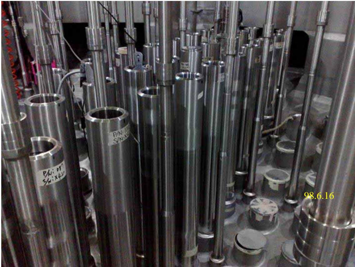
照片五：二號機反應器控制棒驅動殼安裝施工現況
