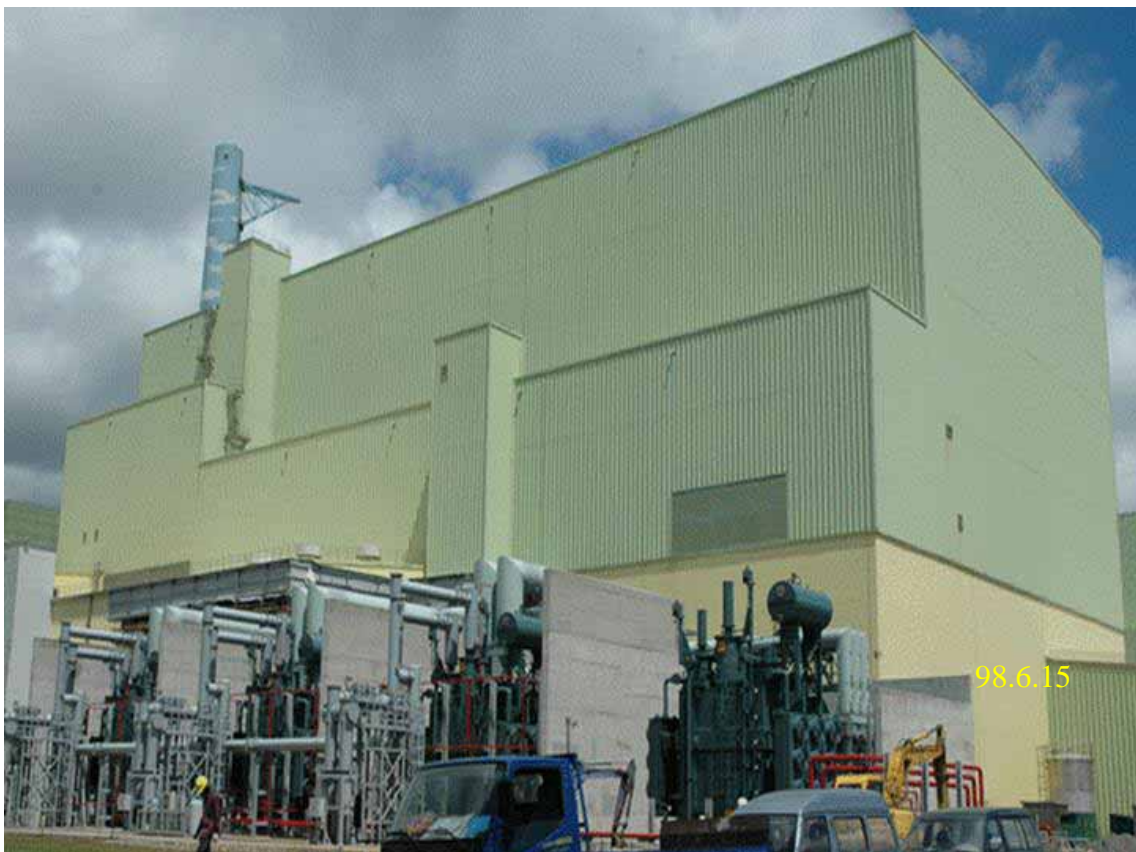
照片二：一號機反應器廠房現況
