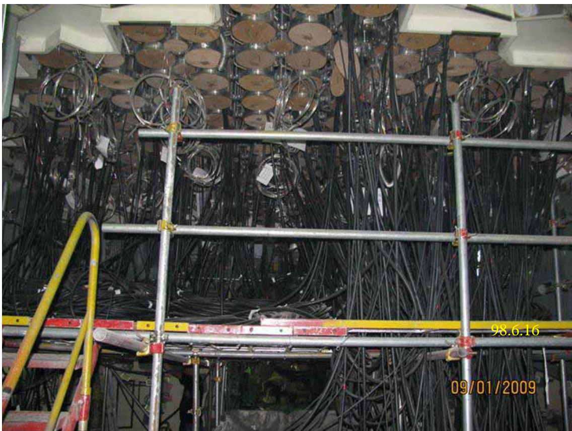
照片四：一號機 FMCRD 拉線情形
